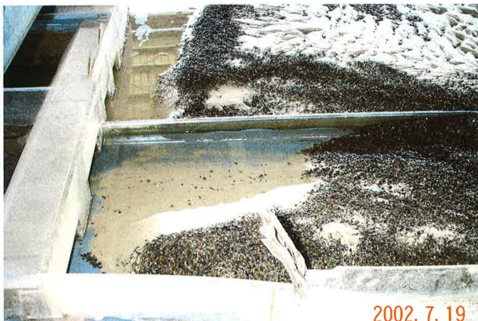
照片 7-13：建議案試驗、攔河堰上游淤積情形（水流由右往左流）
