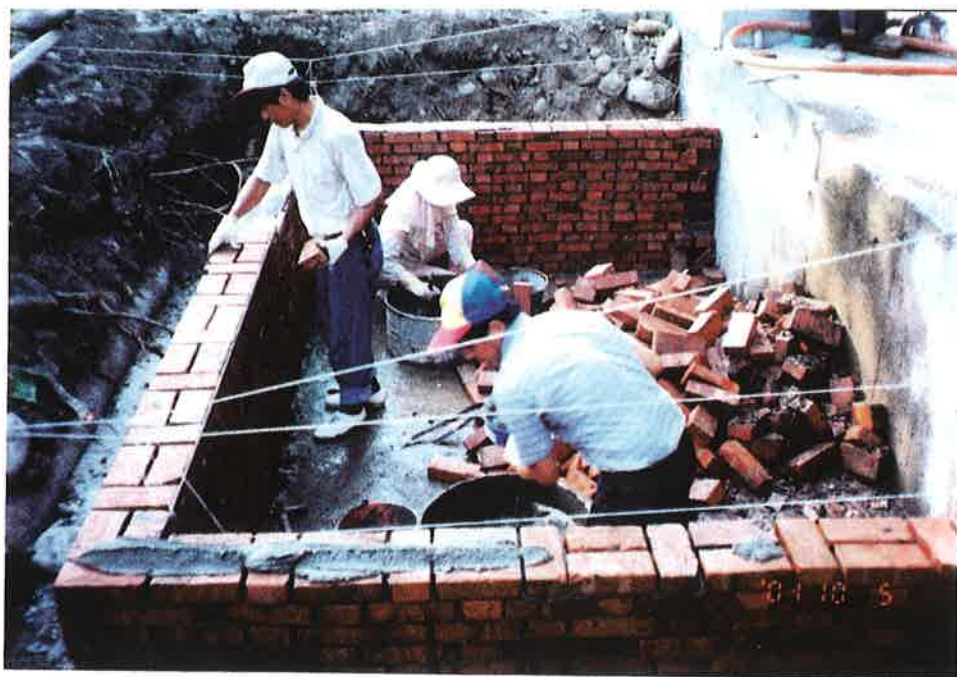
(10)供、量、迴水設備建造
