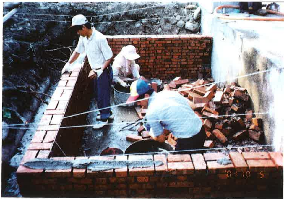
(10)供、量、迴水設備建造
