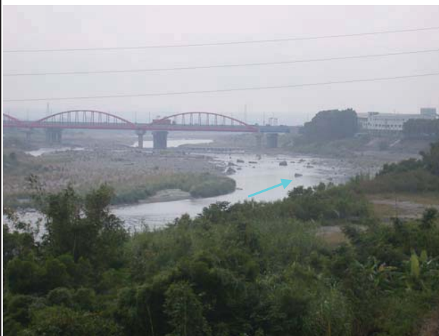
3.由右岸拍攝自來水管橋及上游照片
