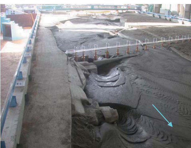
16. 試驗後新山線鐵路橋下游情況
