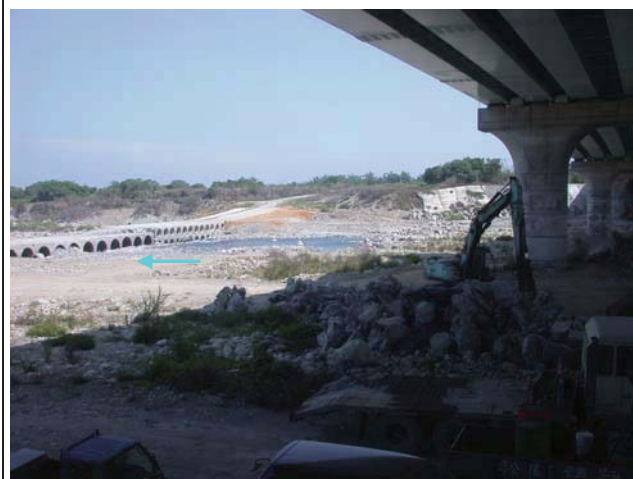
4.由后豐橋下拍攝下游臨時便道右岸加固情況
