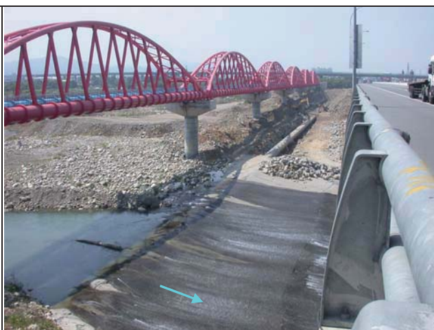
2.由后豐橋上拍攝上游河道送水管拆除情況
