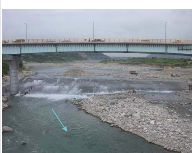
12.現場后豐橋上游流路（面向上游）
