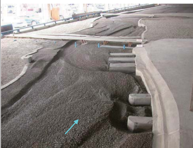
10.試驗後地形（后豐橋上游正隆護岸丁壩）
