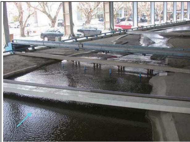
19.退水段 1,580 秒立方公尺 (后豐橋上游正隆護岸丁壩)
