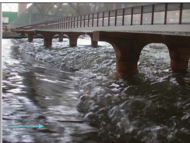
8. 試驗流量通過后豐橋上游端流況
