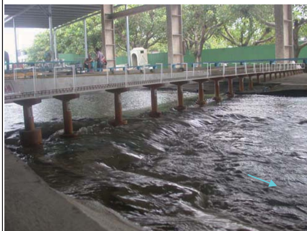
3. 試驗漲水段 2,480 秒立方公尺通過新山線鐵路橋流況
