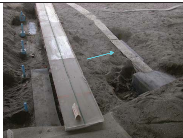
1.后豐便橋拆除、河道送水管 PB 左側拆除及后豐便道不拆除+布置正隆護岸丁壩
