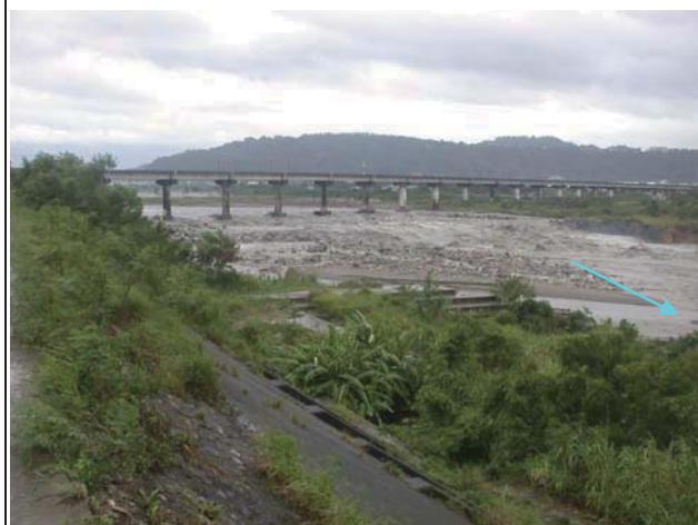
3.現場新山線鐵路橋下游高水位流路
