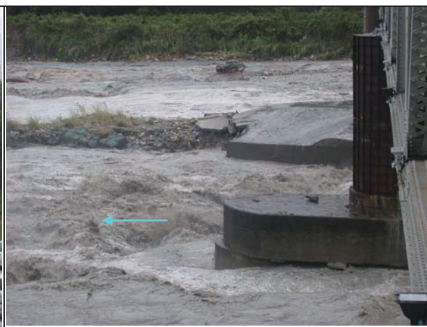
2.現場舊山線鐵路橋下游流路
