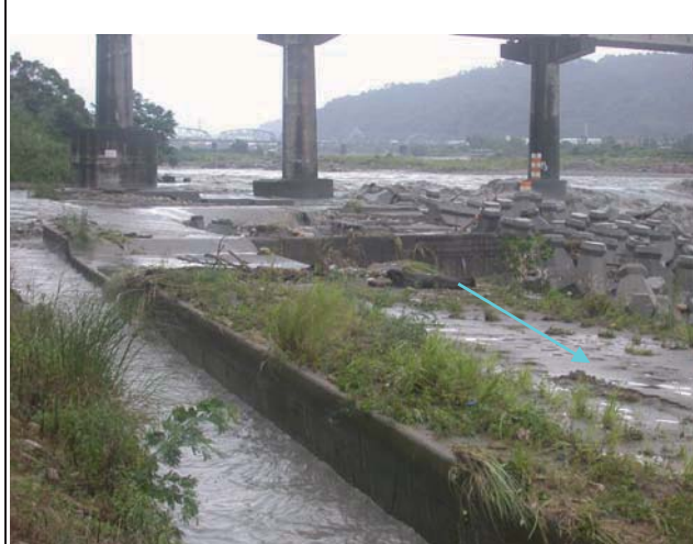
5.現場新山線鐵路橋下游流路
