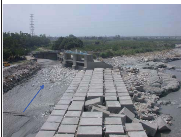
橋下游箭蘆墩圳取水口（2008.09.24）
