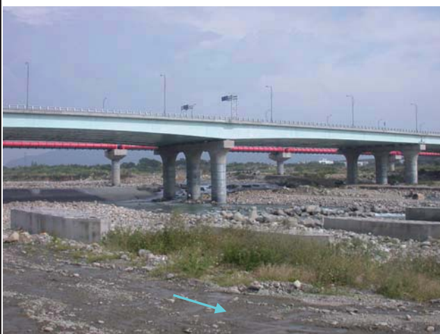
5.由右岸拍攝后豐大橋及下游照片之二
