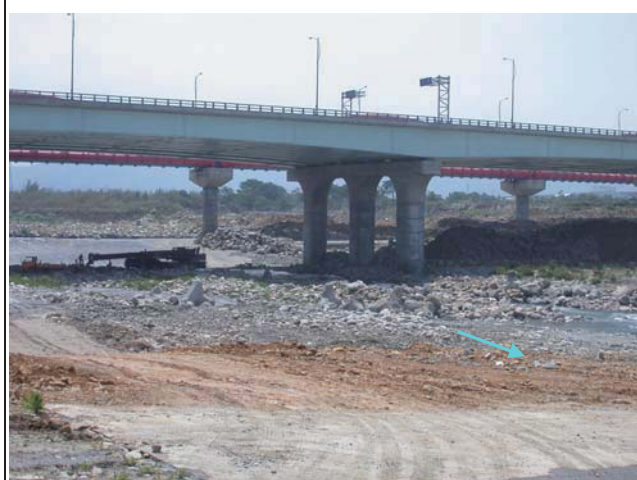
5.由下游拍攝后豐橋及下游臨時便橋橋墩拆除情況
