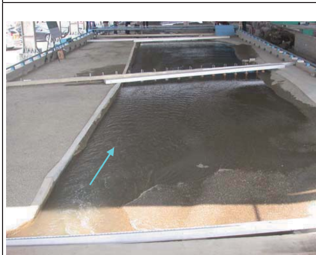
15.退水段 3,082 秒立方公尺（新山線鐵路橋上下游）
