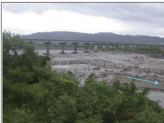
7.現場新山線鐵路橋下游流路
