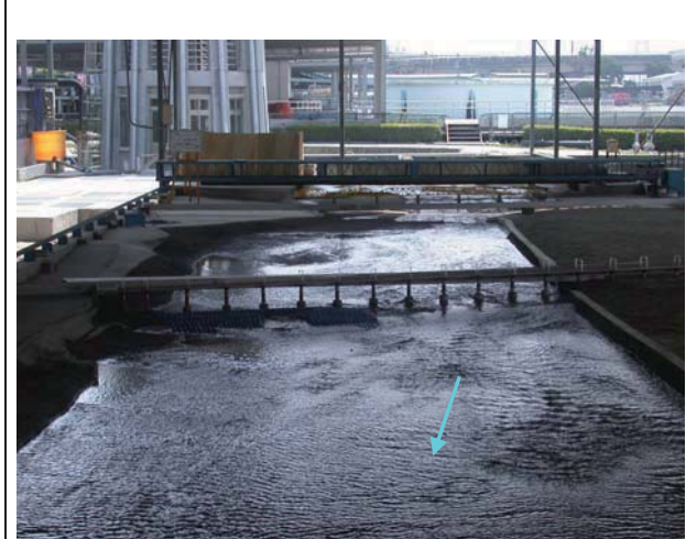
17.退水段 1,959 秒立方公尺（新山線鐵路橋上下游）
