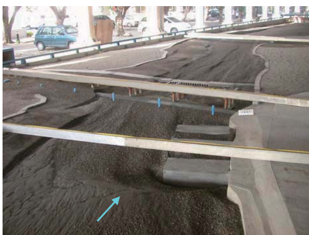
11.試驗後地形（后豐橋上游正隆護岸丁壩）
