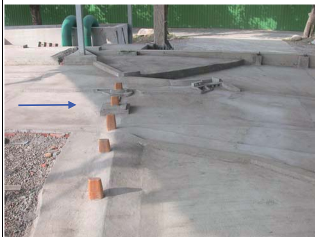
15.完成舊山線鐵路橋墩及地形塑造
