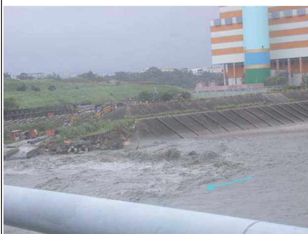
17.現場中山高速公路橋上游流路
