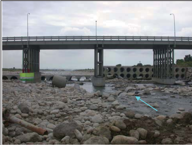
13.現場鋼便橋上游流路（面向下游）
