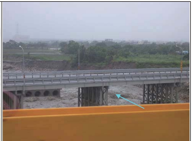
14.現場鋼便橋下游流路
