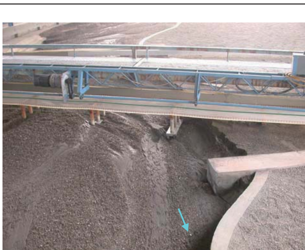
12.試驗後地形（后豐橋下游臨時便道拆除處）
