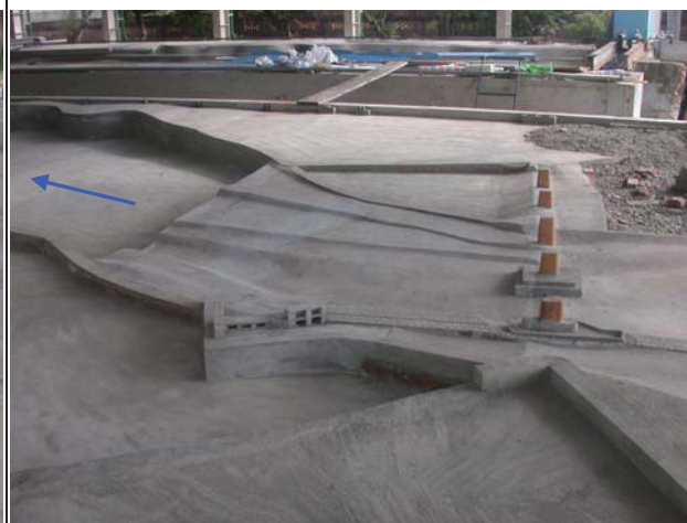
16.完成舊山線鐵路橋墩及地形塑造
