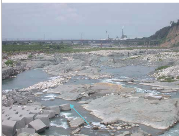
4.現場舊山線鐵路橋下游流路
