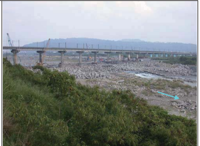
2.由右岸拍攝新山線鐵路橋及下游照片
