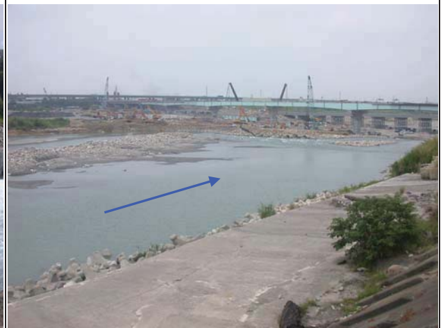
重建橋墩上游地形（2009.06.08）
