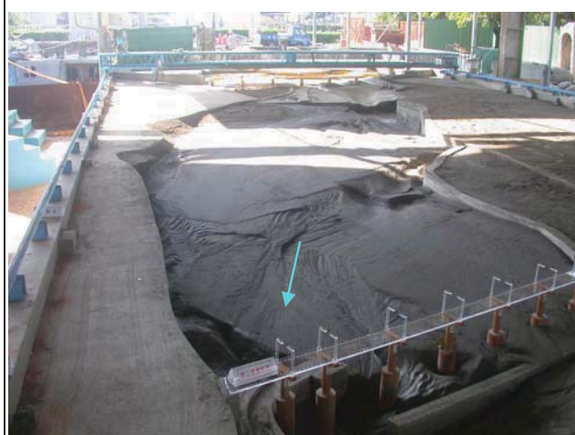
15. 試驗後新山線鐵路橋上游情況
