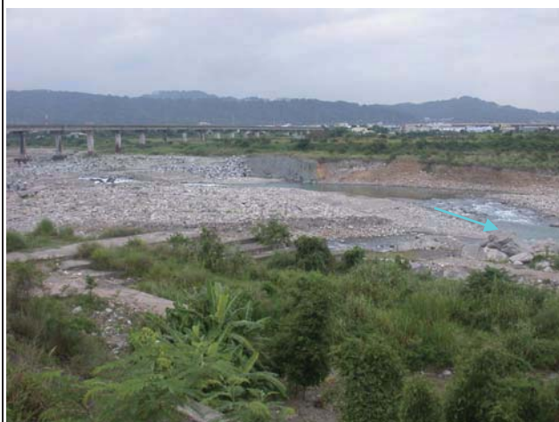
3.現場新山線鐵路橋下游低水位流路
