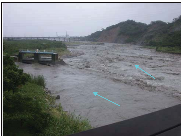
1.現場舊山線鐵路橋下游高水位流路
