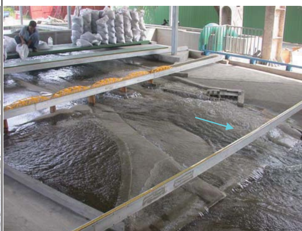
4. 試驗流量通過舊山線鐵路橋流況
