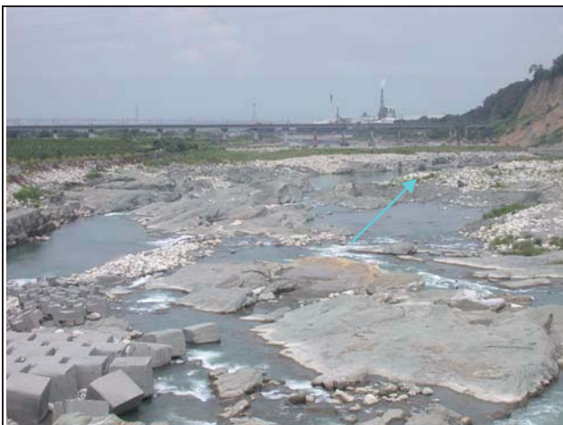
1.現場舊山線鐵路橋下游低水位流路
