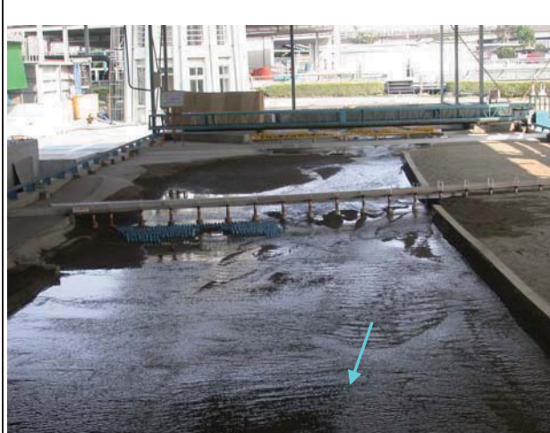
23.退水段 710 秒立方公尺 (新山線鐵路橋上下游)
