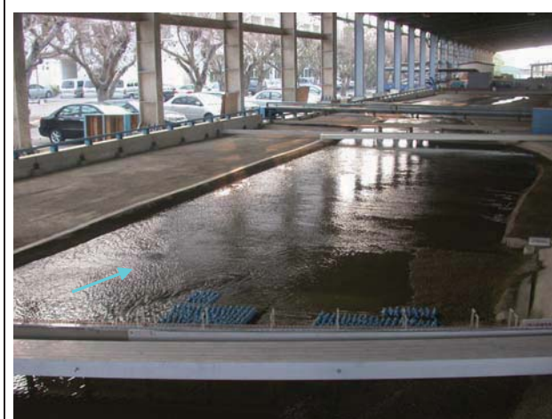
5. 漲水段 710 秒立方公尺 (新山線鐵路橋下游)
