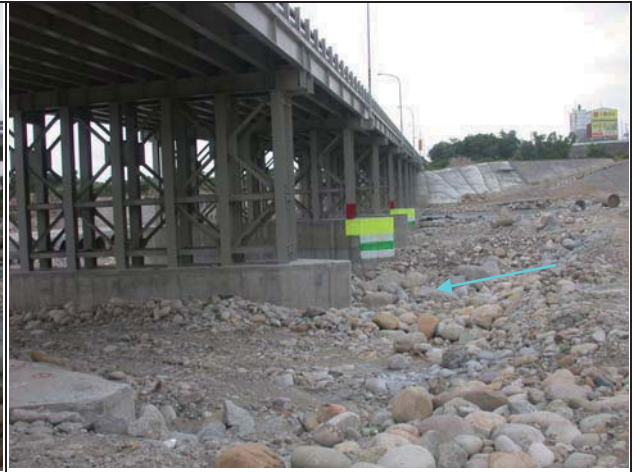
14.現場鋼便橋上游流路（面向右岸）
