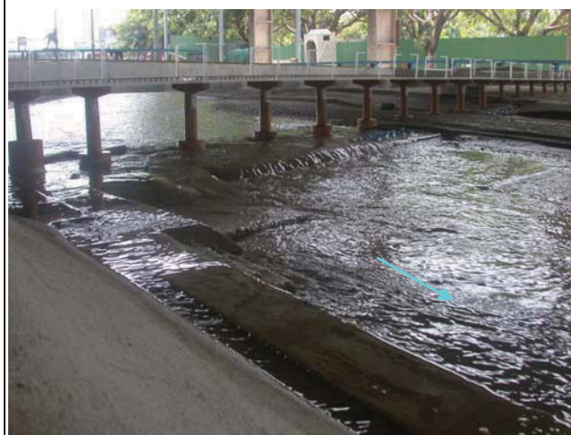
9. 試驗退水段 1,192 秒立方公尺通過新山線鐵路橋流況
