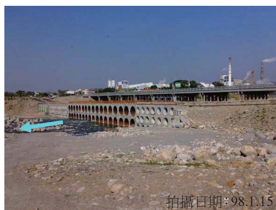
(e)后豐大橋修復及下游通車便道
