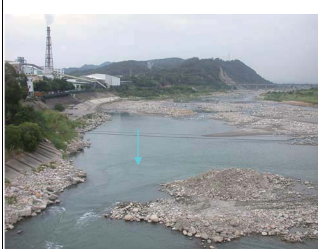
11.現場后豐橋上游流路（面向上游）
