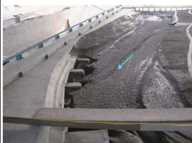
10.試驗後地形（后豐橋上游正隆護岸丁壩）
