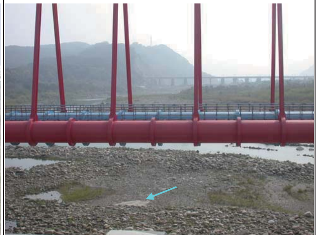
4.由后豐大橋拍攝上游自來水管橋照片
