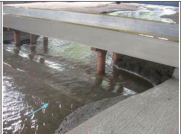
8.模型后豐橋橋下低水位流路
