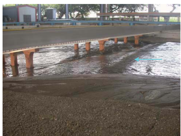
10. 試驗退水段 1,807 秒立方公尺通過后豐橋流況
