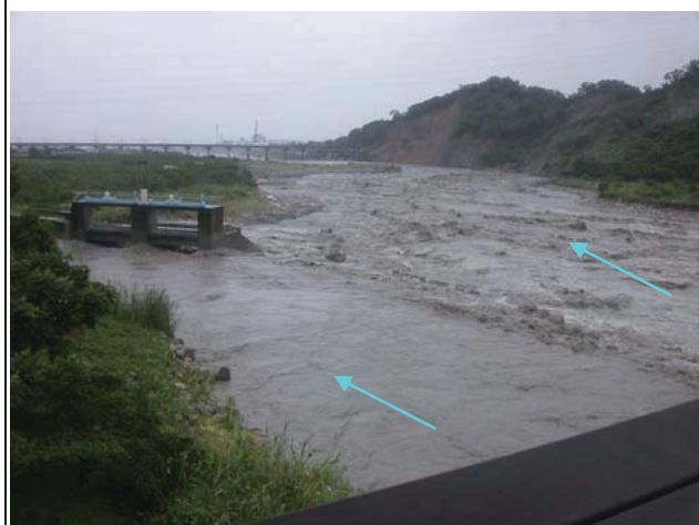
3.現場舊山線鐵路橋下游流路
