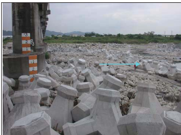
7.現場新山線鐵路橋下游流路
