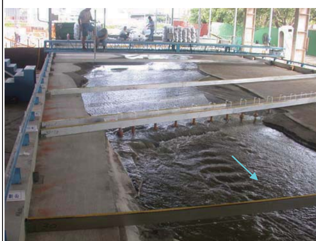
5. 試驗流量通過新山線鐵路橋流況
