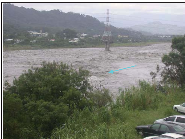
1.現場舊山線鐵路橋上游流路
