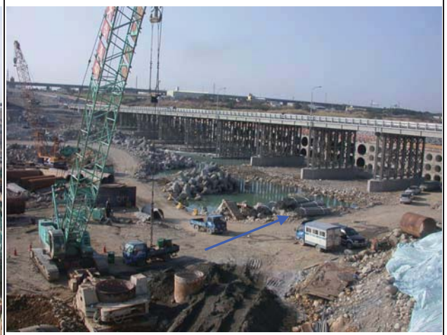
拆橋處橋下游地形 (2009.01.14)
