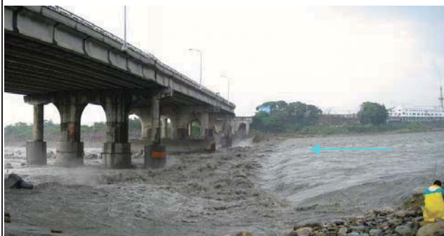
7. 后豐橋斷橋後上游面高水位流況（當時石岡壩實測放流量為 1077.99 CMS）
