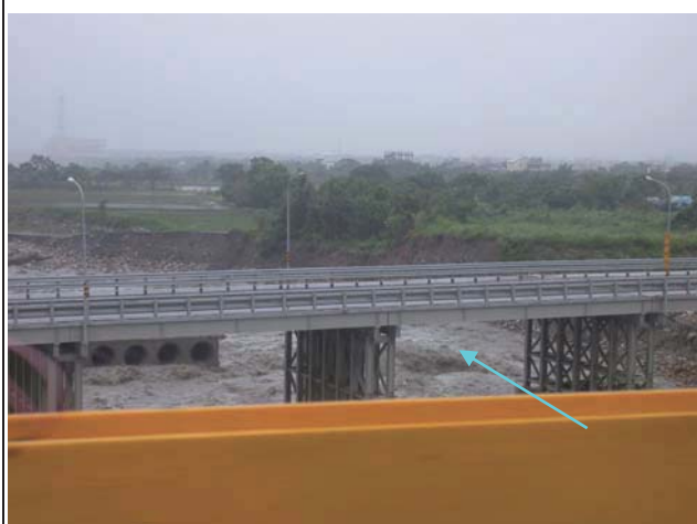
9. 現場后豐橋下游臨時便橋高水位流路
