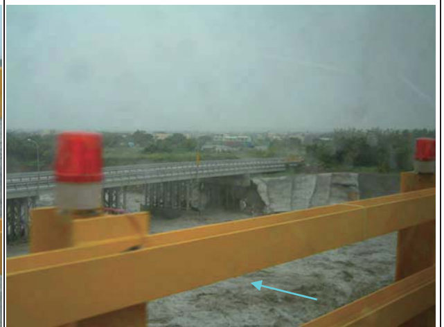
16.現場鋼便橋上游流路
