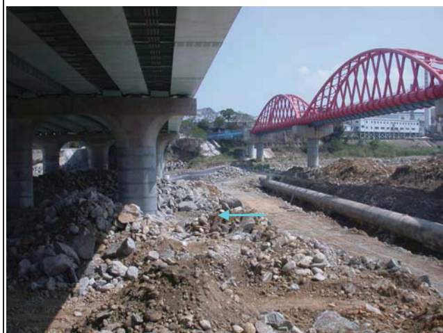
3.由后豐橋下拍攝上游河道送水管拆除情況
