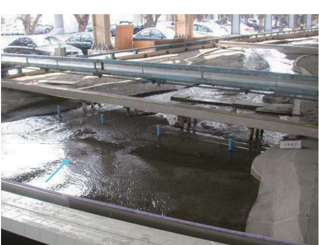
24.退水段 710 秒立方公尺 (后豐橋上游正隆護岸丁壩)
