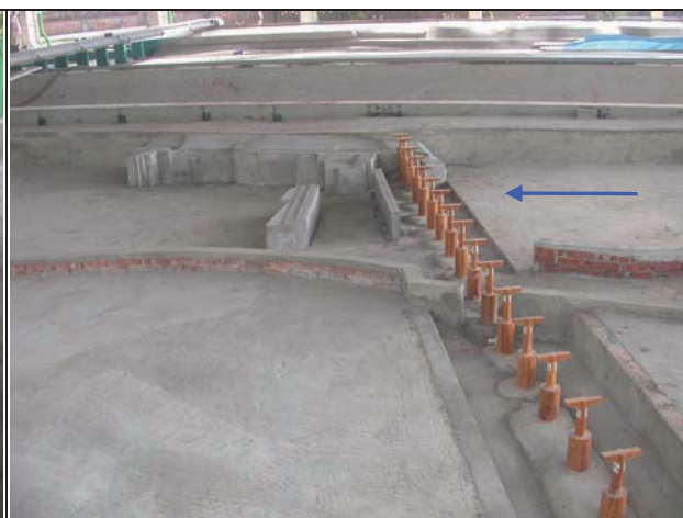
14.完成新山線鐵路橋墩及地形塑造
