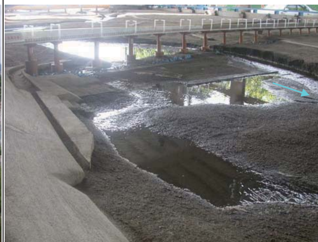
4.模型新山線鐵路橋下游低水位流路
