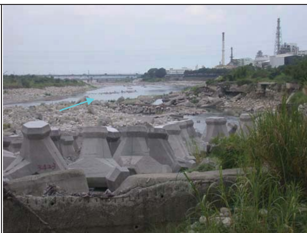
8.現場新山線鐵路橋下游流路
