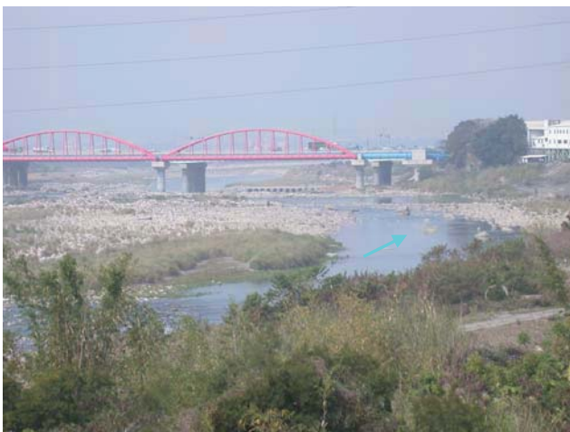
3.由右岸拍攝自來水管橋及上游照片
