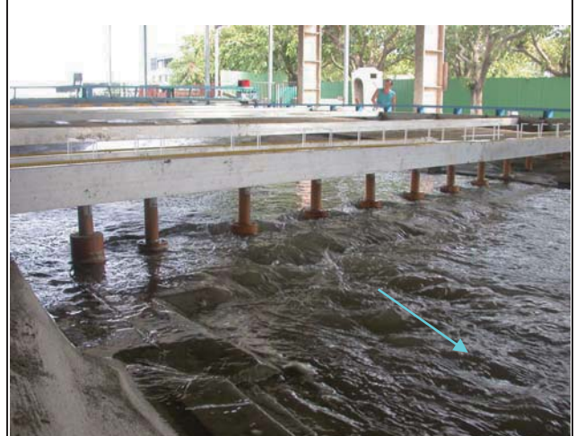
6. 試驗流量通過新山線鐵路橋流況
