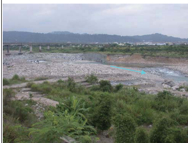
9.現場新山線鐵路橋下游流路
