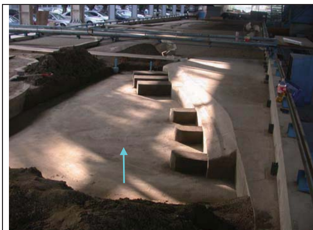
1.后豐便橋、河道送水管(右岸~PD 之間 297m 全拆)及后豐便道拆除+布置正隆護岸丁壩
