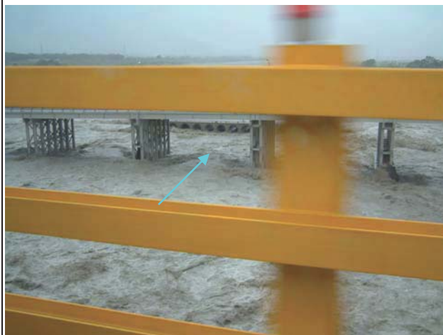
15. 現場鋼便橋上游流路
