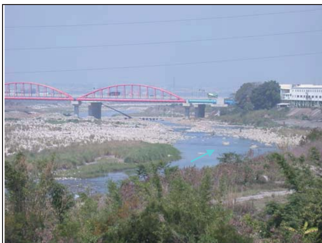
1.由右岸拍攝自來水管橋及上游照片
