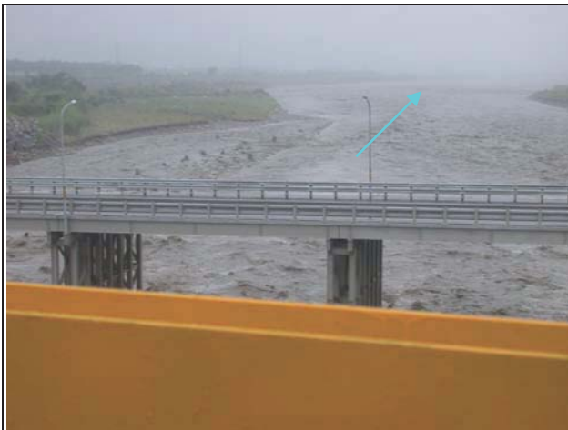
13.現場鋼便橋下游流路
