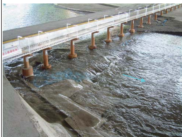
3. 試驗漲水段 1,959 秒立方公尺通過新山線鐵路橋流況
