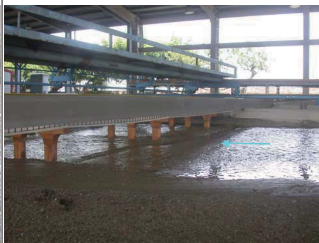
10. 試驗退水段 1,192 秒立方公尺通過后豐橋流況
