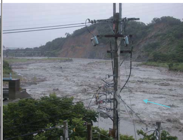
4.現場舊山線鐵路橋下游流路
