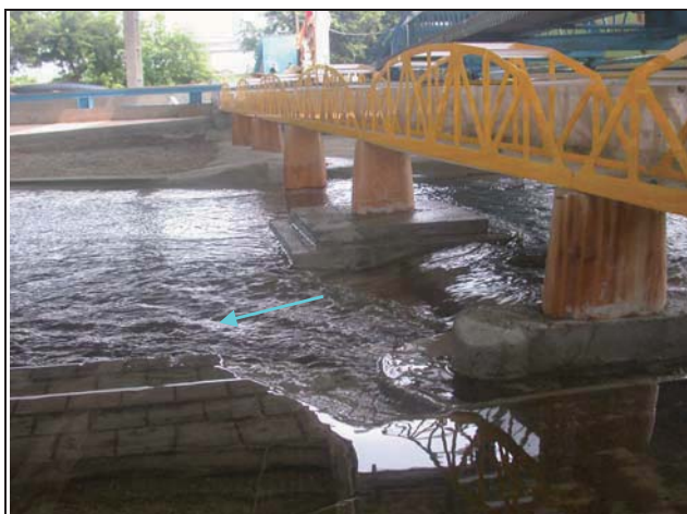
1. 試驗漲水段 710 秒立方公尺通過舊山線鐵路橋流況
