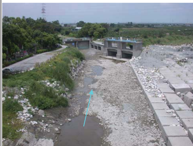
3.現場舊山線鐵路橋下游流路
