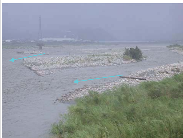
11. 現場中山高速公路橋上游流路
