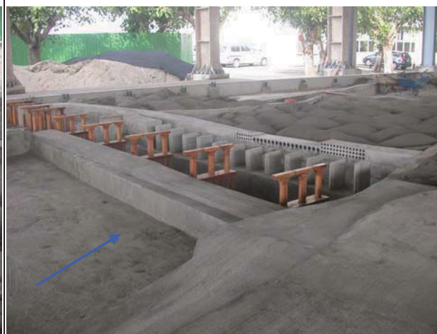
12.完成后豐橋橋墩及地形塑造（面向下游）
