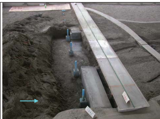
1.后豐橋上游自來水河道送水管 PB~PD 間 (長度約 154m) 拆除
