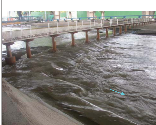
5. 試驗洪峰流量 3,955 秒立方公尺通過新山線鐵路橋流況
