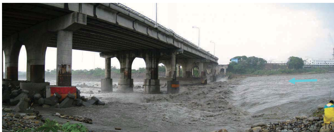
(c)后豐橋上游面流況（當時石岡壩實測放流量為 1077.99 秒立方公尺）
