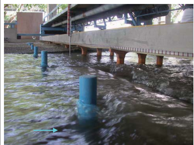
6.洪峰流量 4,007 秒立方公尺 (后豐橋上游)
