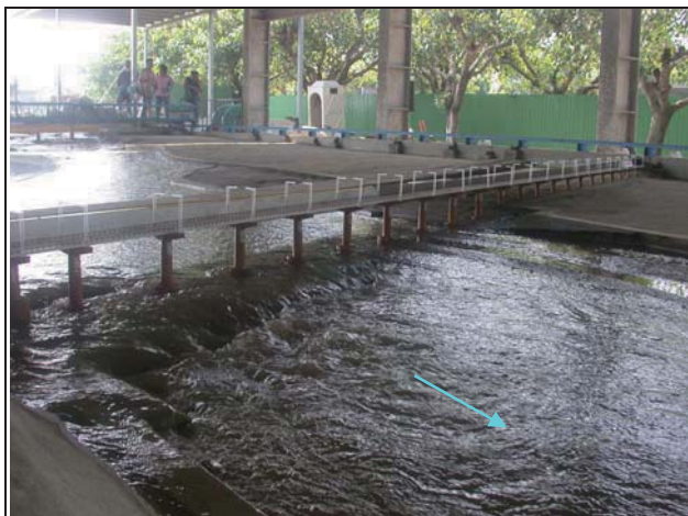
7. 試驗退水段 2,611 秒立方公尺通過新山線鐵路橋流況
