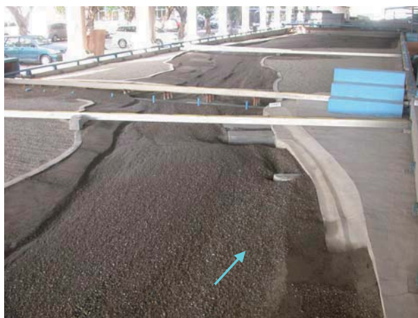
9.試驗後地形（后豐橋上游正隆護岸丁壩）
