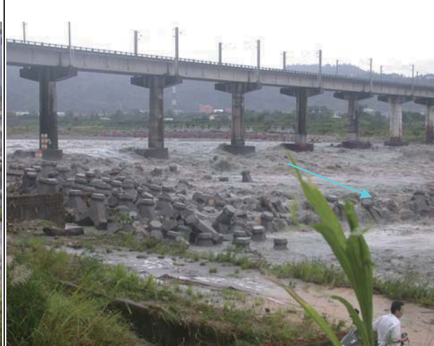
6.現場新山線鐵路橋下游流路
