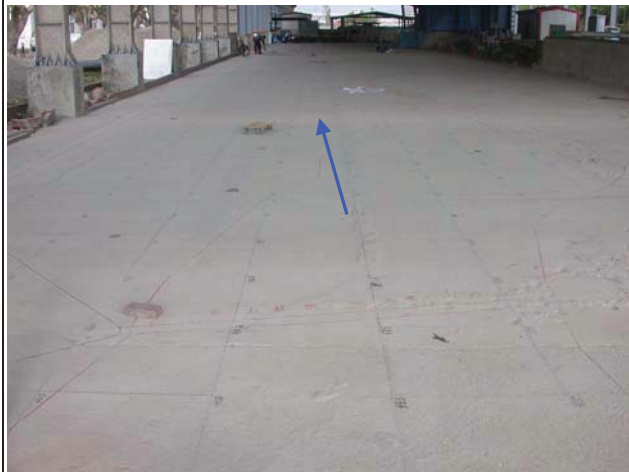
3.畫地形線-舊山線鐵路橋（面向下游）
