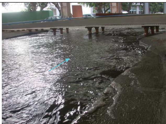
8. 試驗退水段 2,678 秒立方公尺通過后豐橋流況
