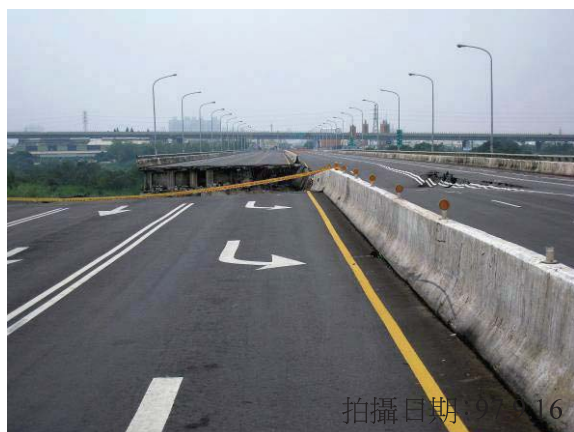
(a)后豐橋橋面斷裂情況
