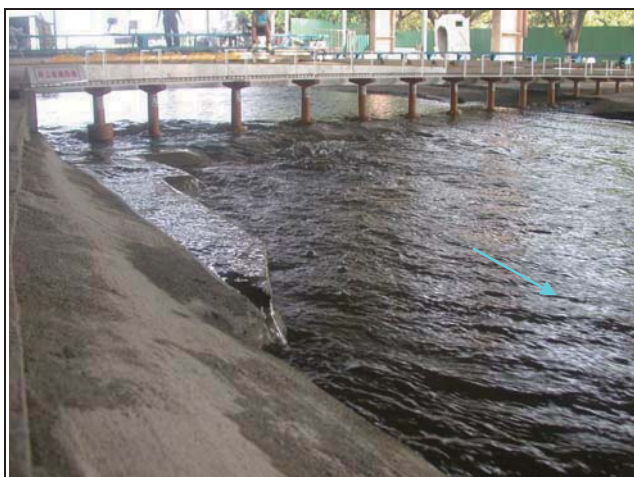
7. 試驗退水段 2,678 秒立方公尺通過新山線鐵路橋流況
