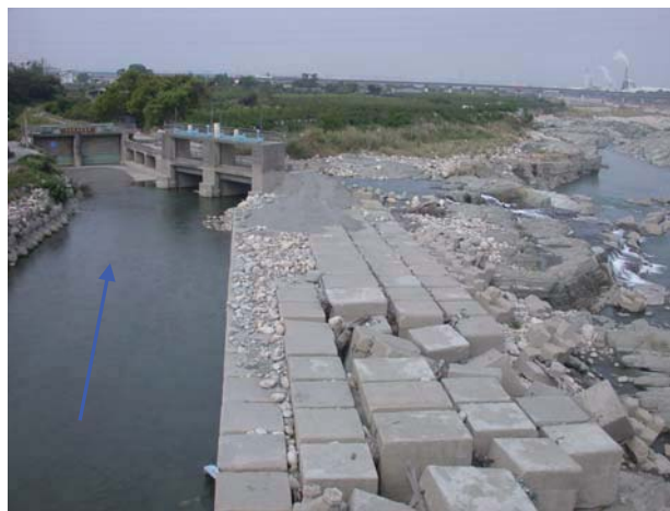
橋下游籐蘆墩圳取水口（2009.04.02）
