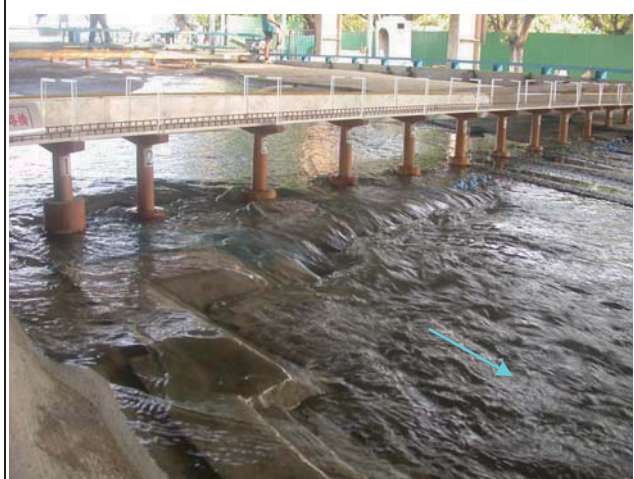
9. 試驗退水段 1,807 秒立方公尺通過新山線鐵路橋流況
