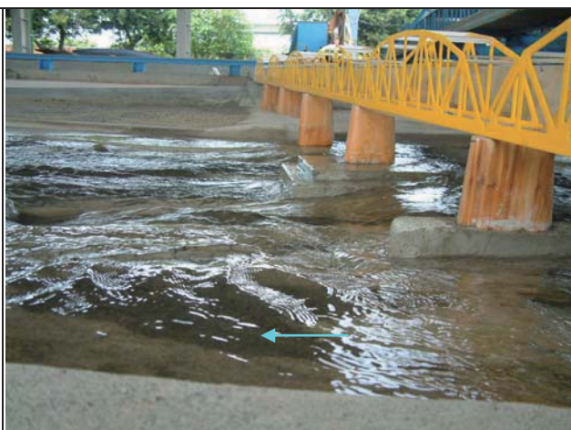
2. 試驗漲水段 1,959 秒立方公尺通過舊山線鐵路橋流況
