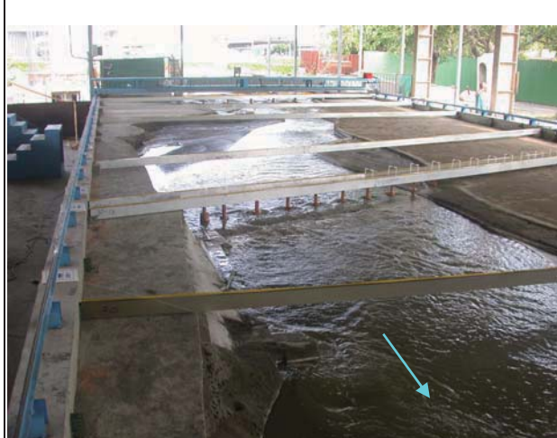
5. 試驗流量通過新山線鐵路橋流況
