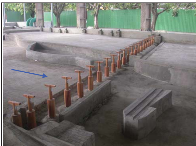
13.完成新山線鐵路橋墩及地形塑造
