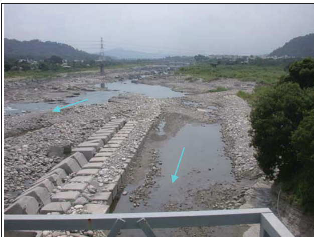
1.現場舊山線鐵路橋上游流路
