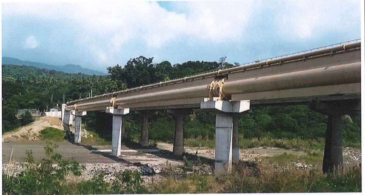
水管橋落墩與曾文一號橋平行
