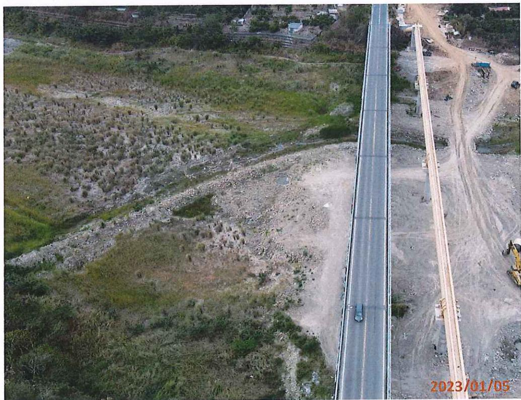
說明：設置引水道防止斷流
