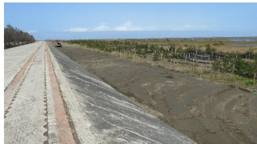
入口處堤防內整地作業 111.2.25
