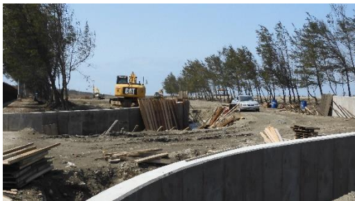
入口處停車場施工 111.2.25
