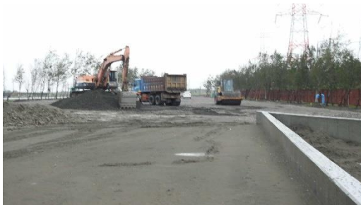
入口處停車場施工 111.3.24
