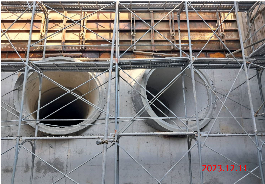
雙向備援工程 落水池牆身第三昇層模板組立
