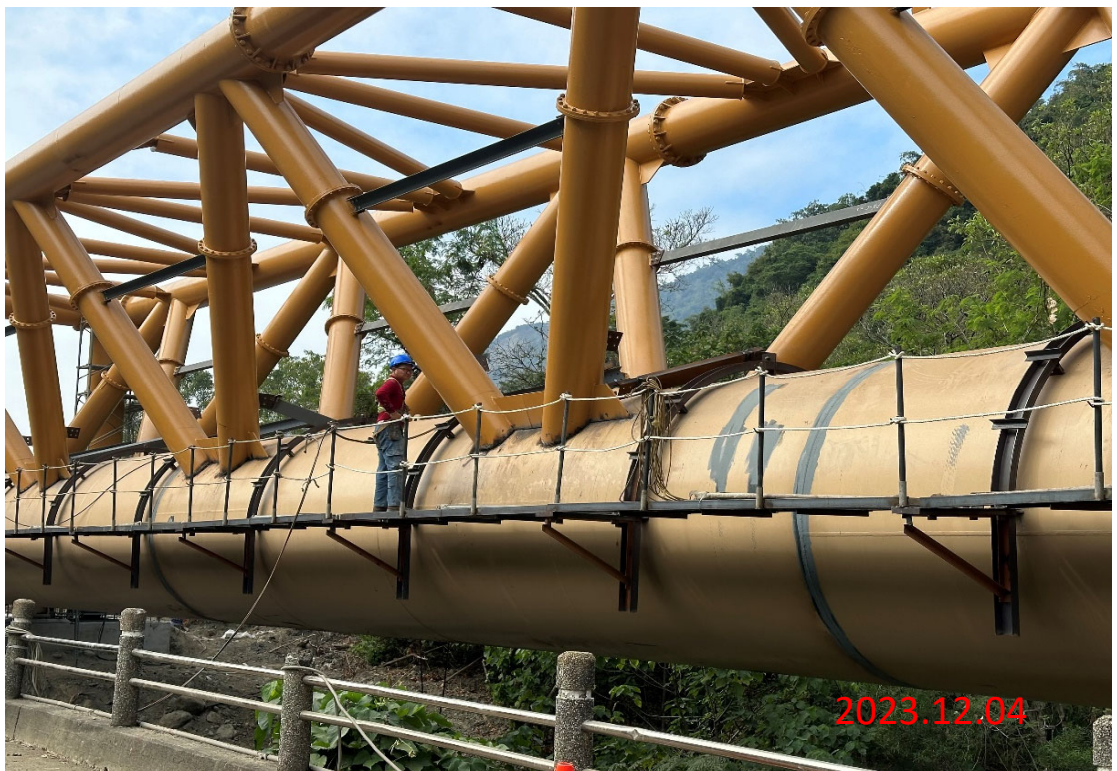
溪畔水管橋 桁架焊接、維修步道施作
