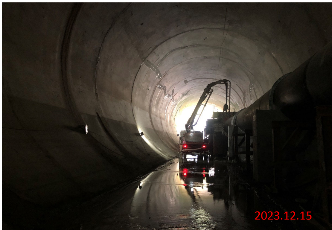
#2導水隧道 DOK+882.35固定台(I)第一昇層、DOK+872.3固定台(I)第二昇層混凝土澆置
