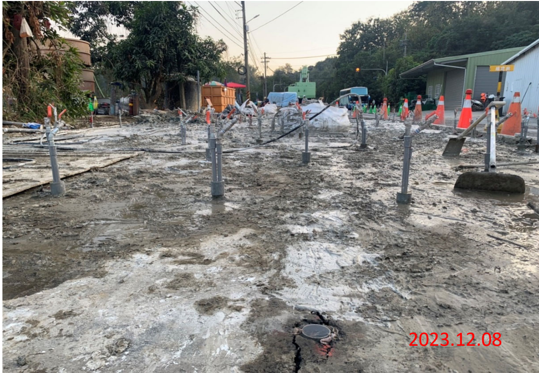
曾庫公路推進段工程 W10A地盤改良灌漿_17孔(累計202孔)
