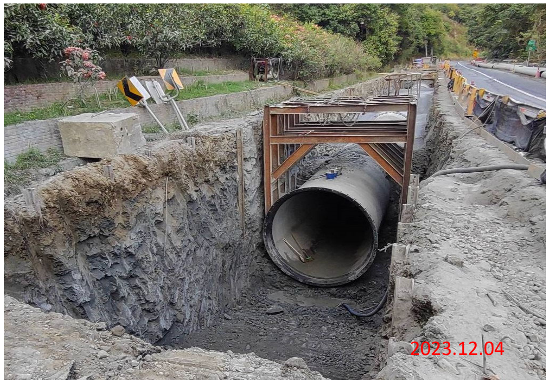
曾庫公路明挖段工程 4K+734.5~4K+740.5 土方開挖，K管埋設， \phi 2600mm
