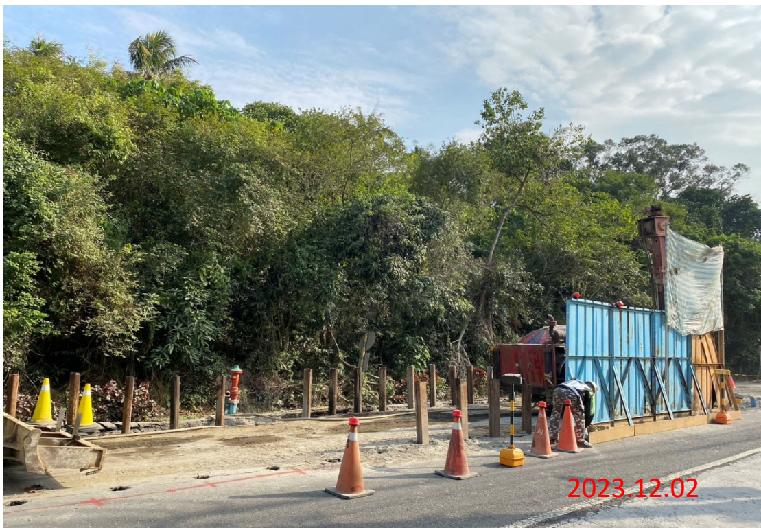
曾庫公路推進段工程 W15B鑽孔，鋼軌樁打設_8孔(累計13孔)
