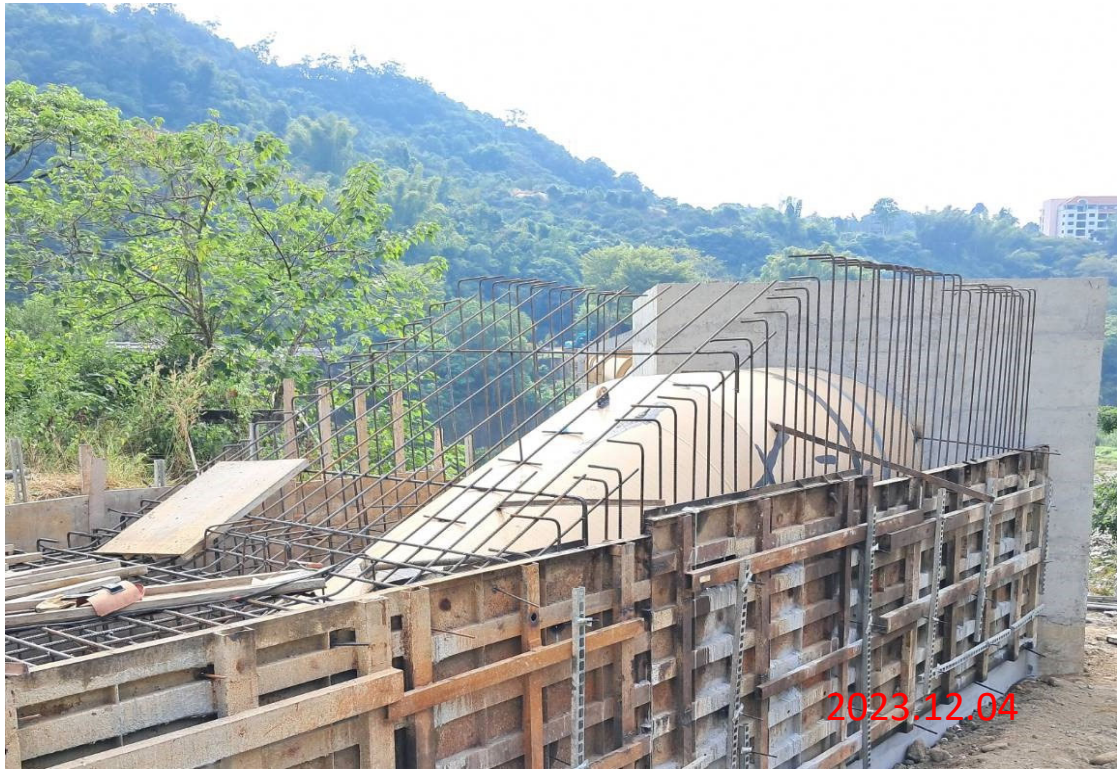
曾文三號水管橋 A1彎管固定台第三昇層模板組立
