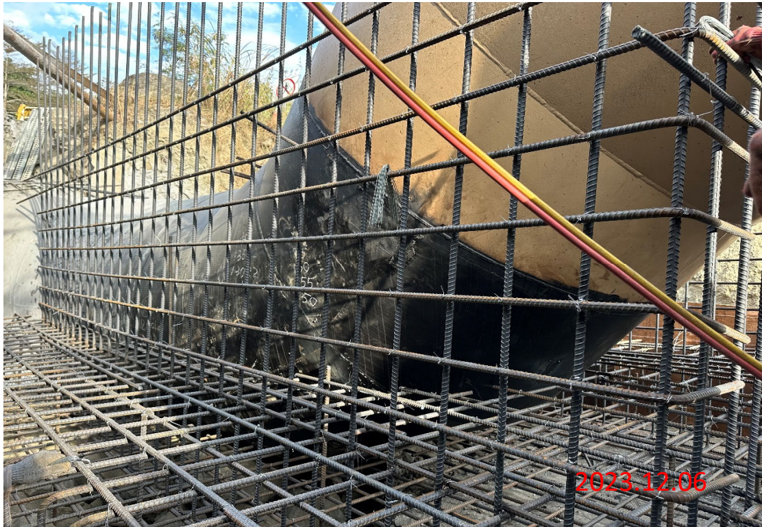
曾庫公路明挖段工程 4K+500.0 船型管A1橋台牆身鋼筋綁紮
