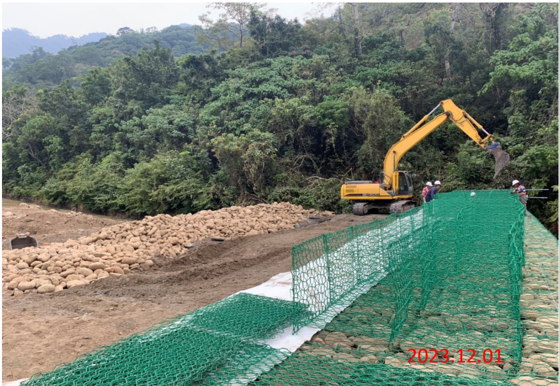
溪畔護岸整治工程 箱型石籠第四層(0~31M)綁紮
