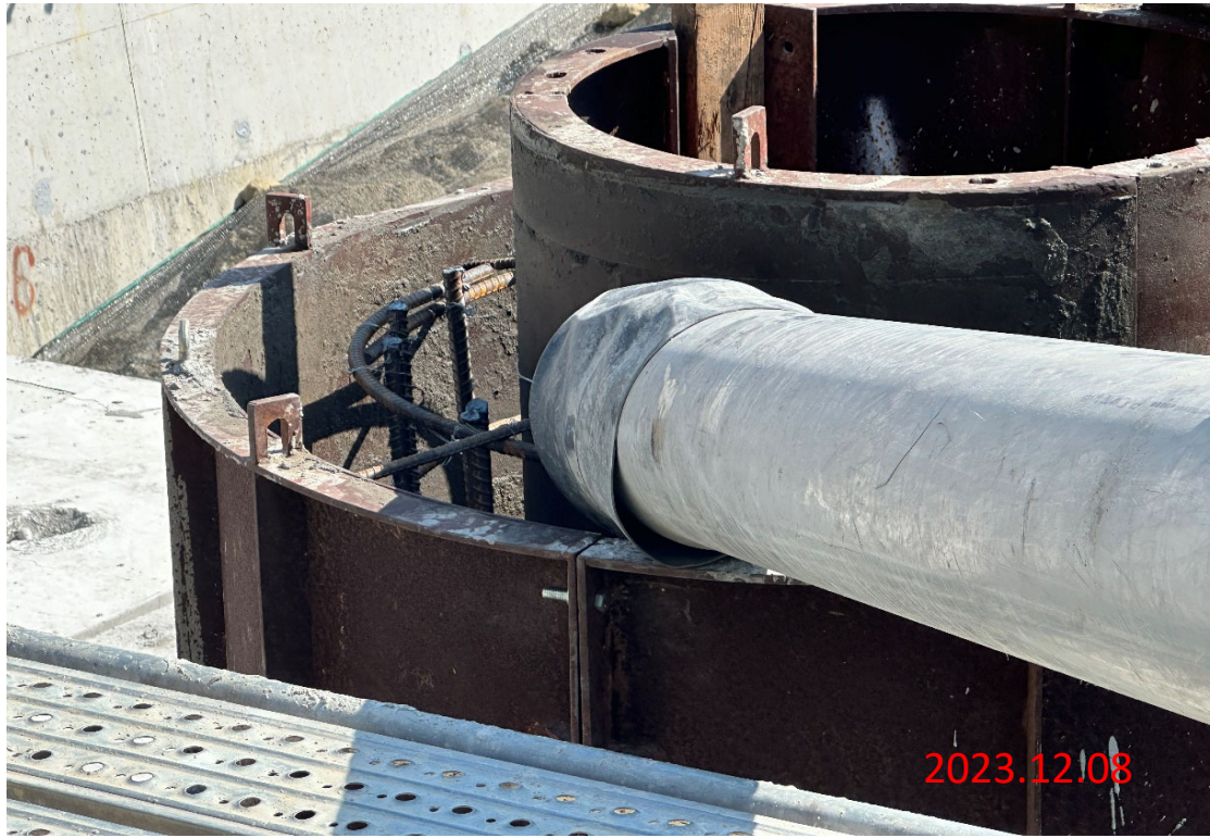
消能設施段工程 IV03蝶閥窰井頸圈(1.51~1.8m)、IV04蝶閥窰井頸圈 (1.51~2.74m) 混凝土澆置
