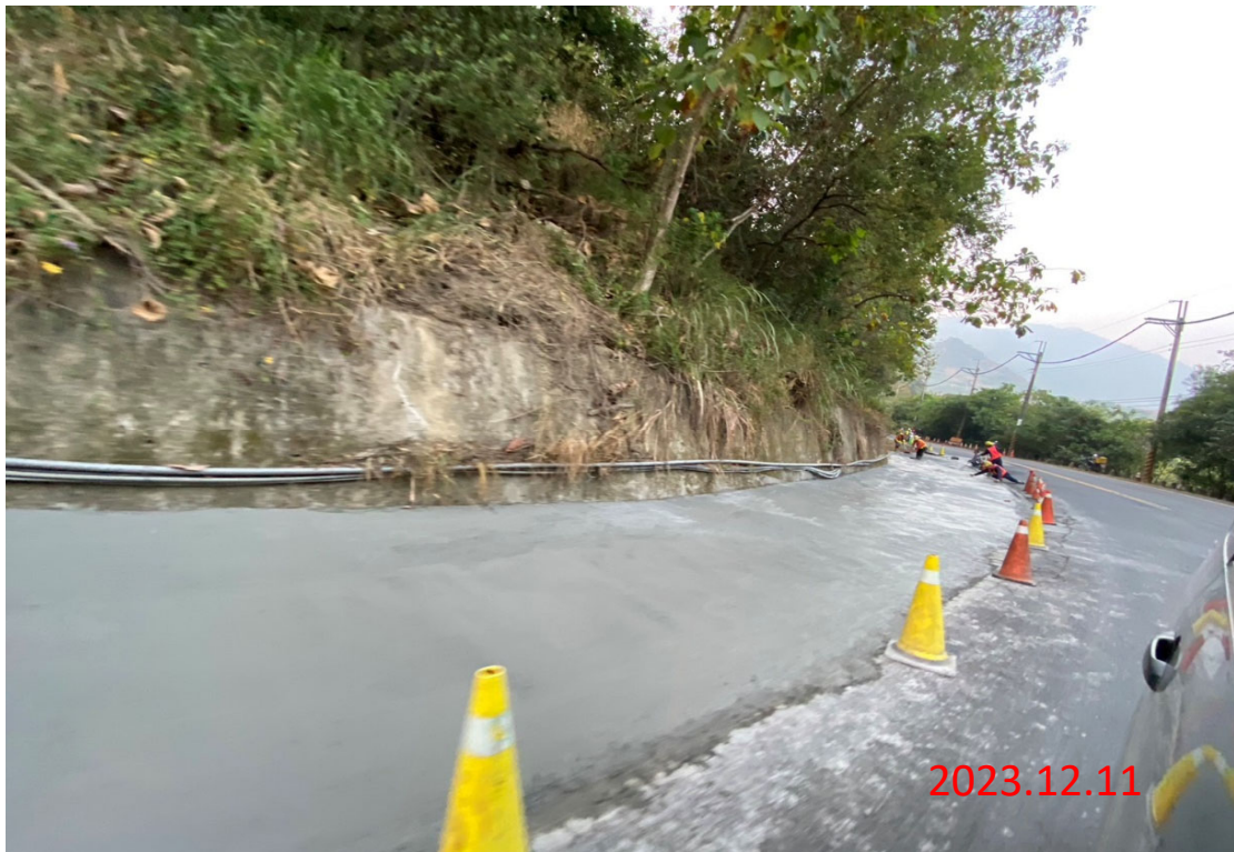
曾庫公路推進段工程 W12-W13便道鋪設
