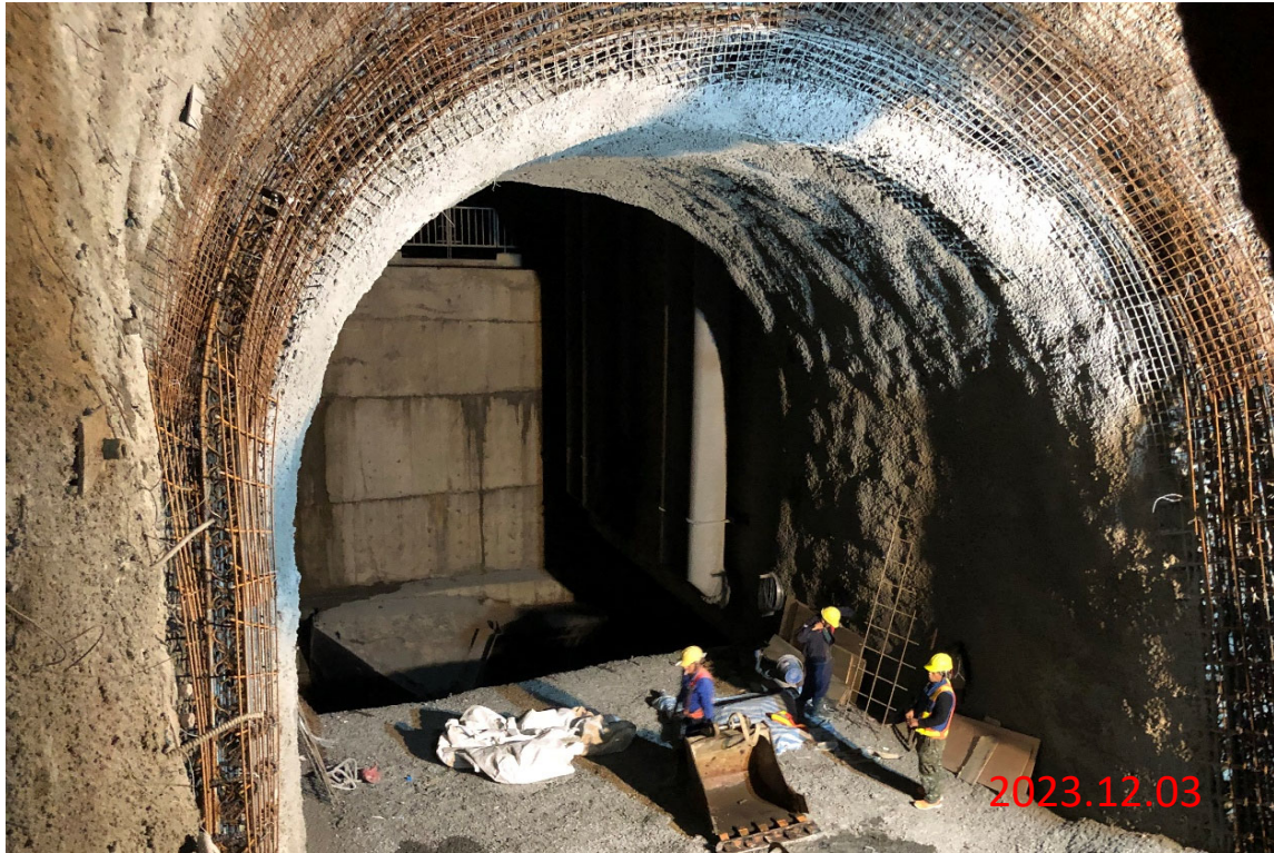
PRO操作風速過高改善工程 通氣斜坑 TOK+235.2~OK+233.7 水平段內襯砌(側牆)施作
