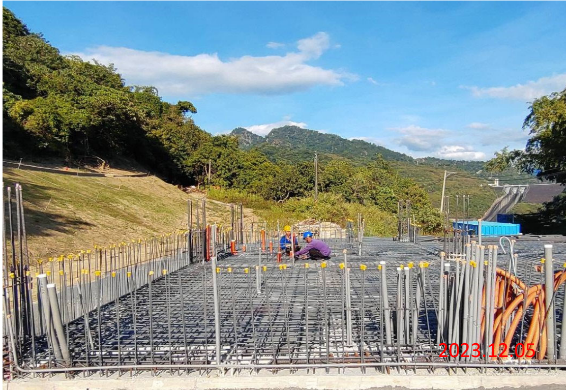
木瓜園操作機房 一樓樓版鋼筋綁紮
