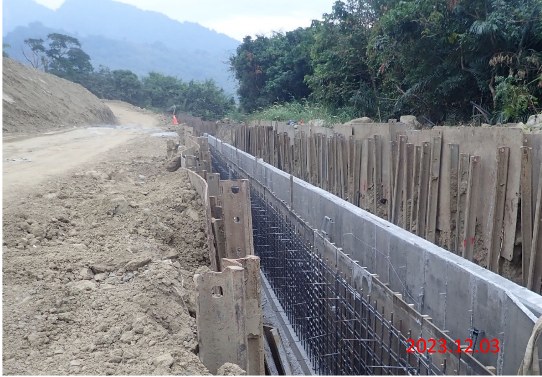
水土保持工程 DB滯洪沉砂溝(2)右側牆身模板組立
