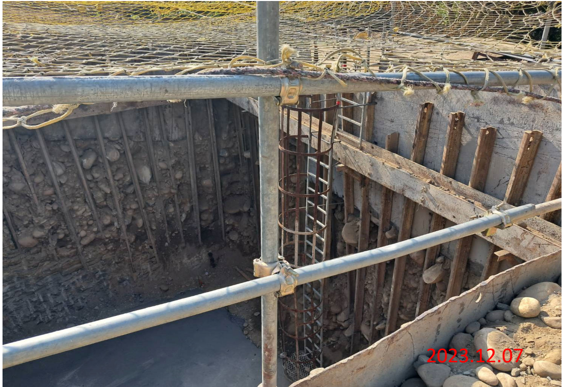
雙向備援工程 電動蝶閥窰井開挖
