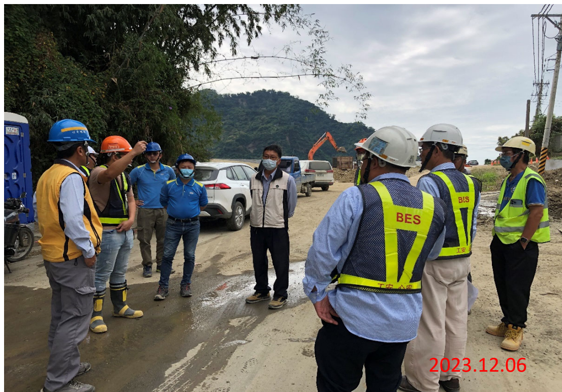
112年12月6日辦理木瓜園通達道路電線地下化介面協調會勘
