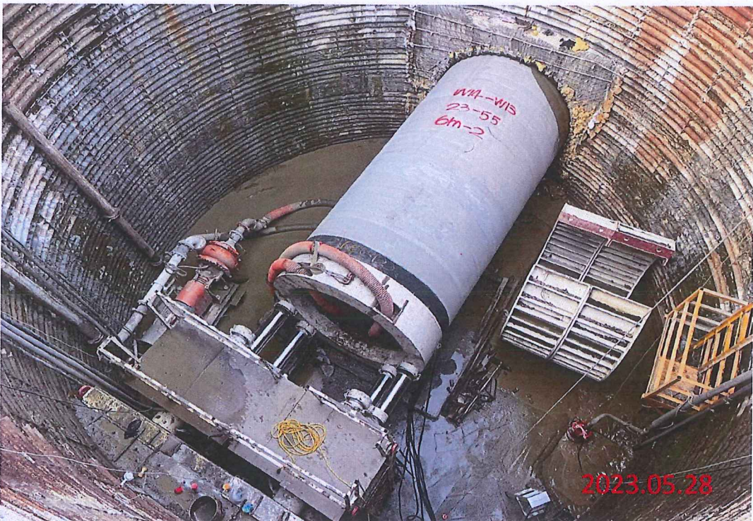
曾庫公路推進段工程 W14工作井往W13工作井推進，DIP U2 \phi 2600mm， L=6m，第2支，接合，推進
