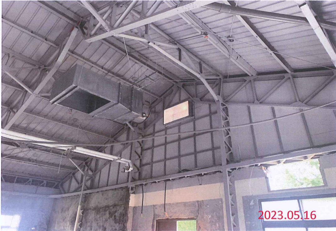
永續一館 消防排煙通風管裝設
