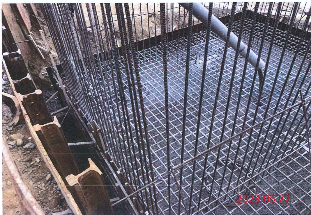
曾文三號水管橋 A2橋台基礎 280kgf/cm 2 混凝土澆置
