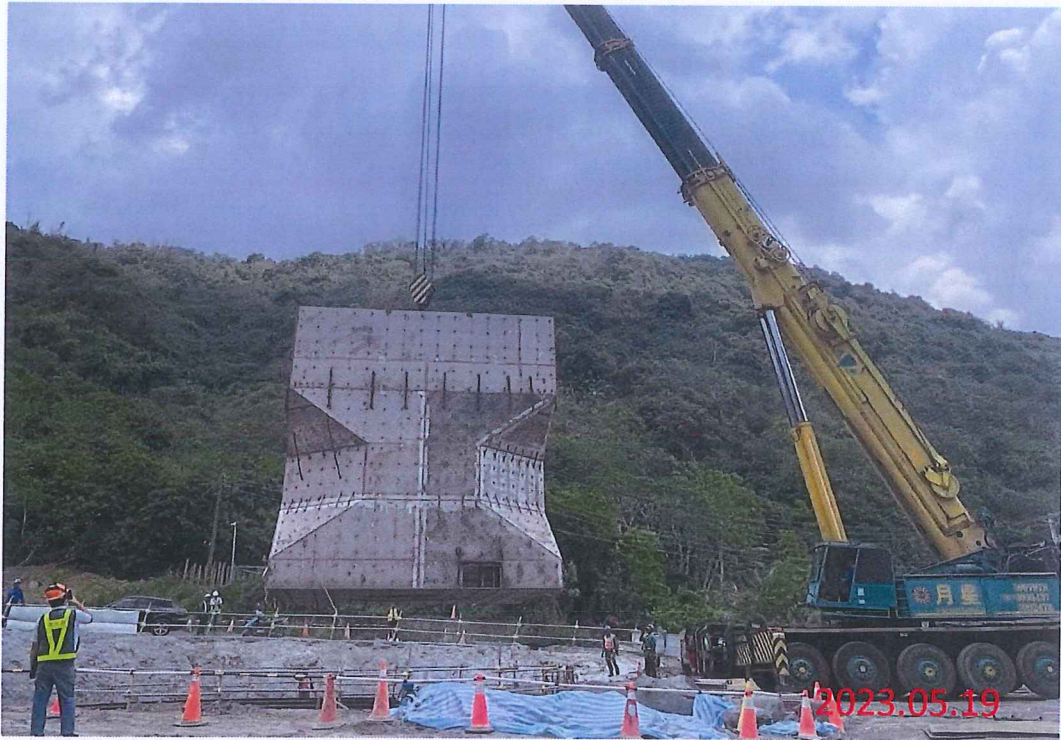
消能設施段工程 消能井抗沖蝕鋼板吊入
