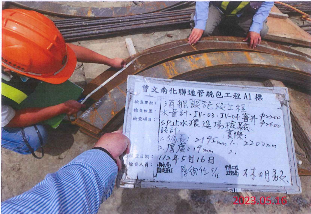
辦理消能設施段水量計、IV-03、IV-04窰井 \phi 2200\text{mm} 、 \phi 2600\text{mm} SP止水環進場檢驗
