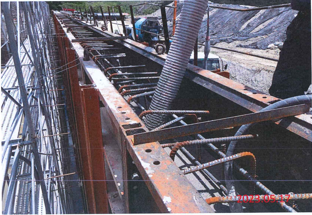
消能設施段工程 調整池牆身1K+603.97~623.78左側第二昇層混凝土澆置
