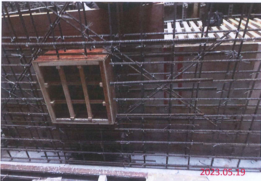
消能設施段工程 消能豎井第十四昇層EL. 147.15~149.40 隔牆鋼筋綁紮
