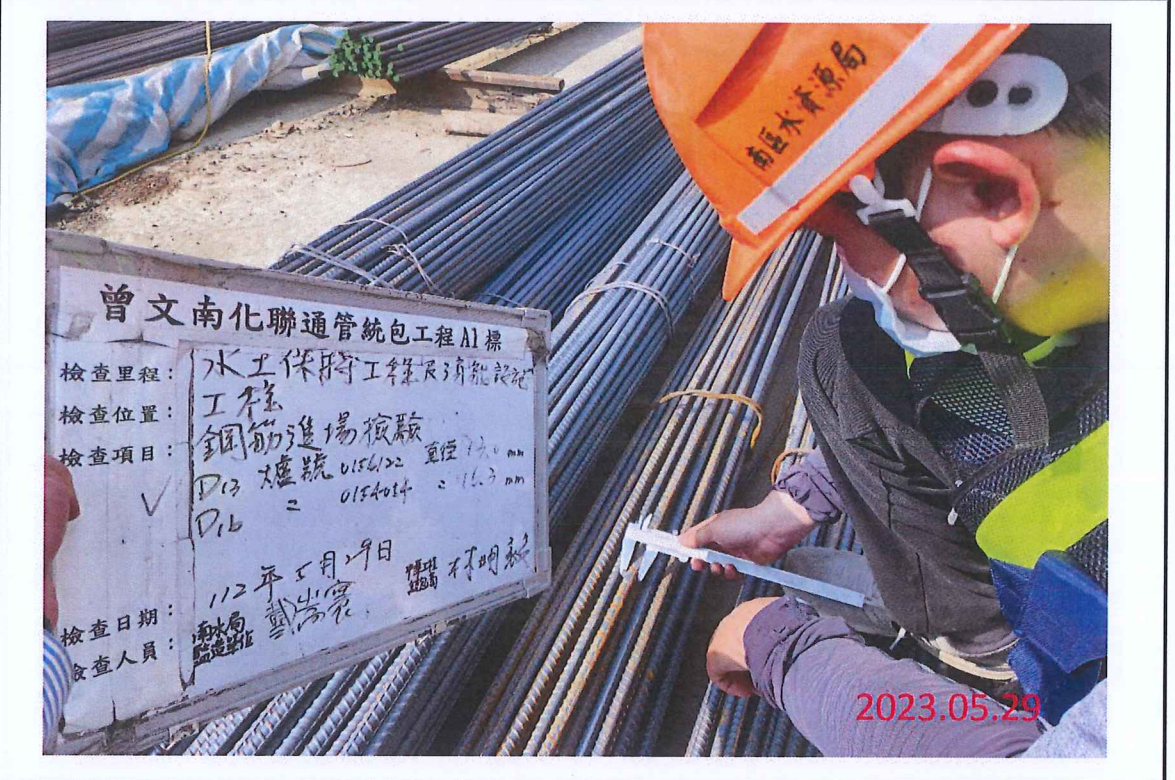
消能設施段工程辦理竹節鋼筋進場查驗及取樣
