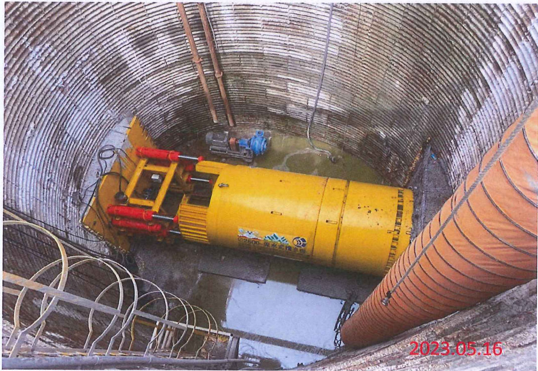
曾庫公路推進段工程 W12工作井 佈場整理
