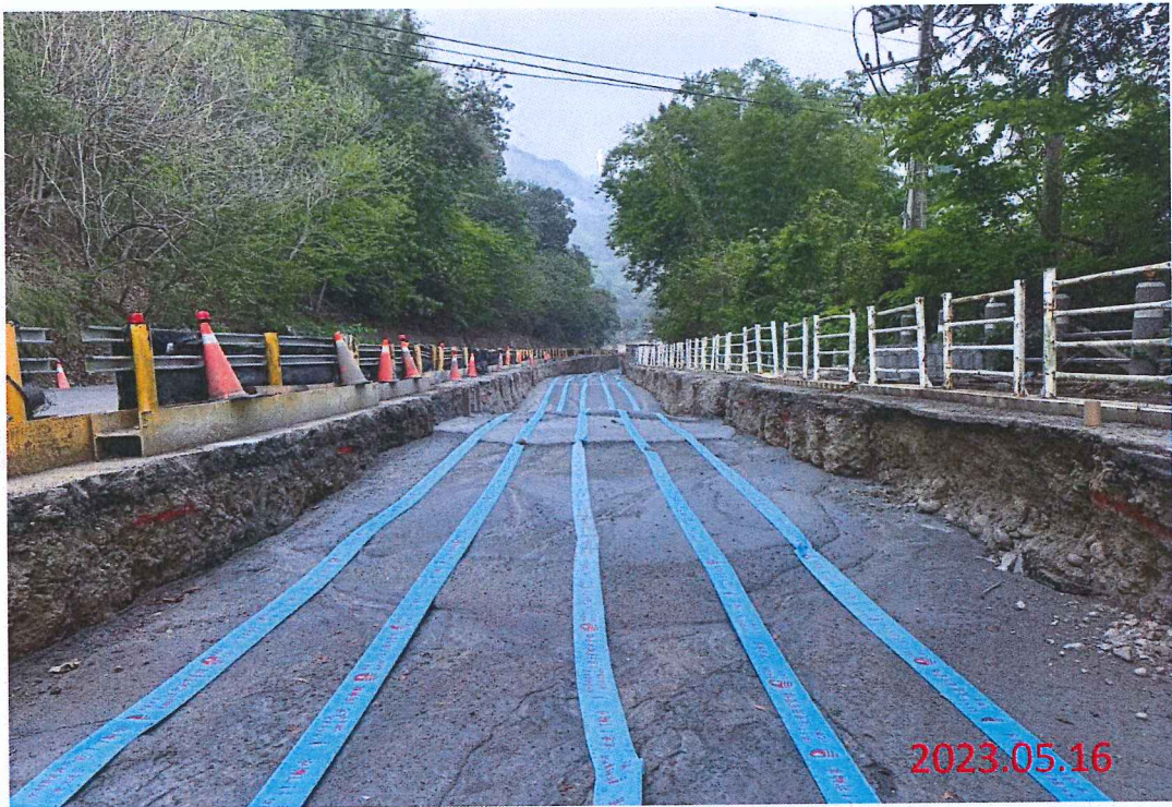
曾庫公路明挖段工程 6K+601.6~666.1 (第三層)、6K+666.1~739.1 (第二層) 20~80kg/cm 2 控制性低強度回填材料澆置
