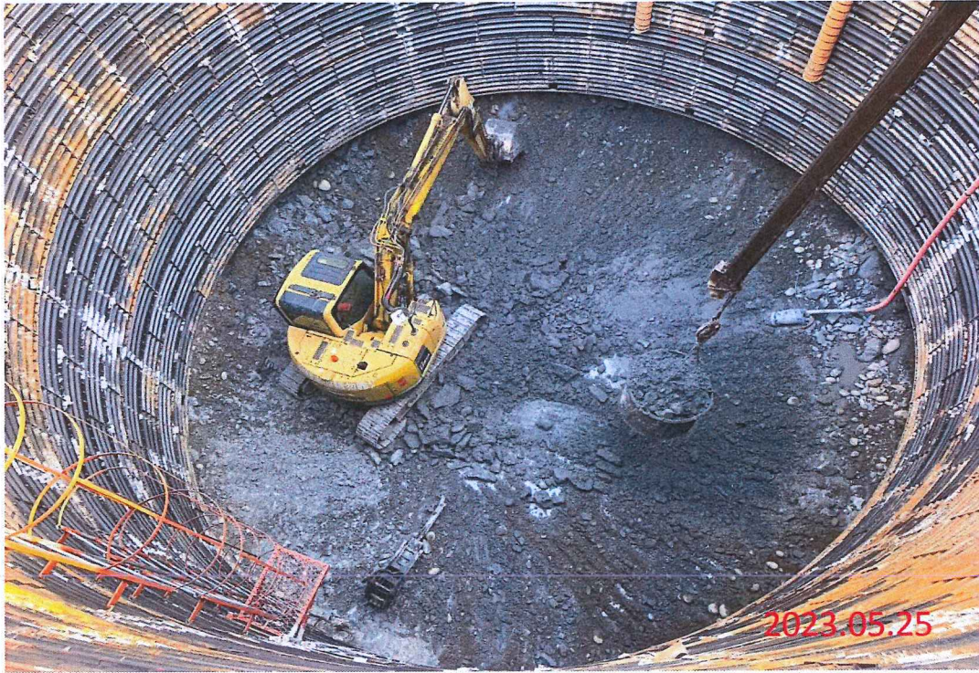
雙向備援工程 消能井EL. 107~106 開挖、鋼襯板安裝(t=5.3mm)、G200鋼支保組立
