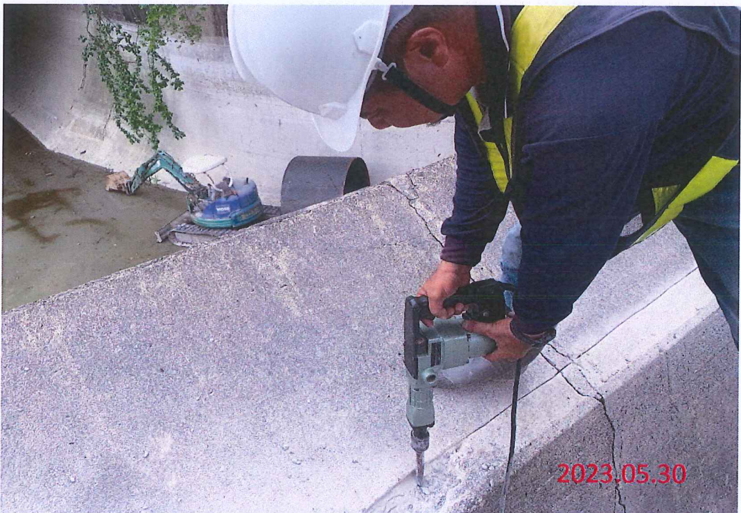
跨河段工程 W01工作井防洪牆TYPE-II 堰體敲除
