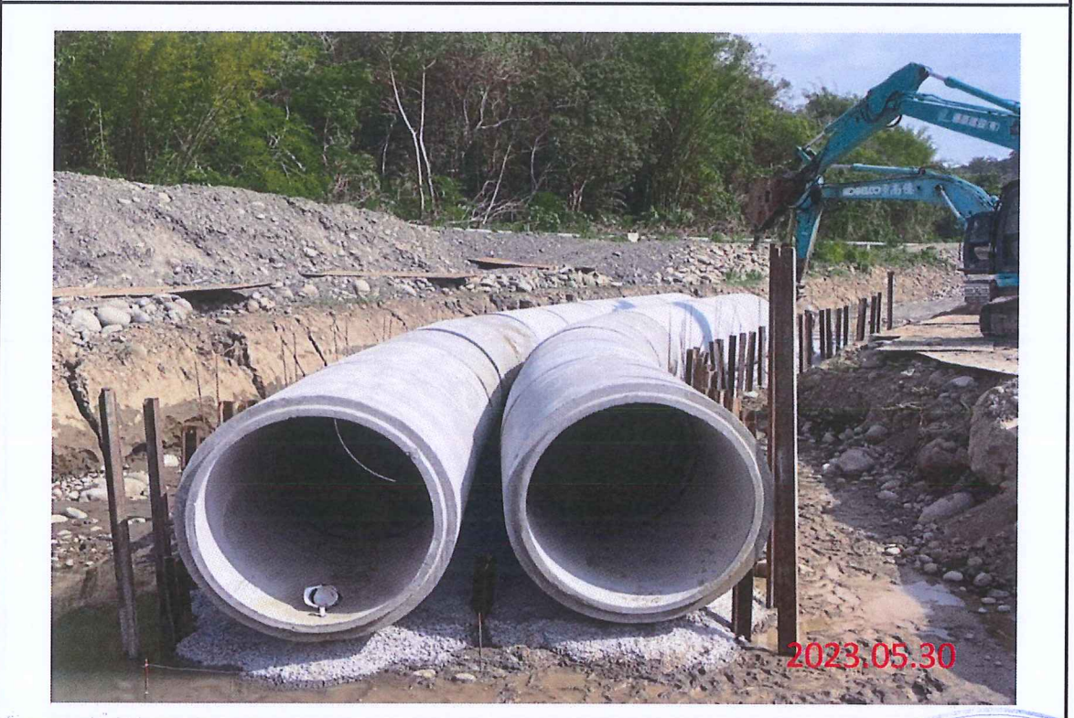
雙向備援工程 放水路 \phi 1800mmRCP管理管開挖
