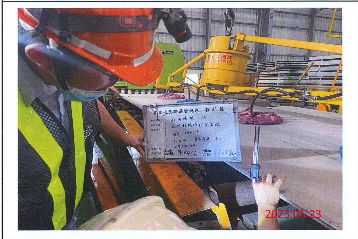
辦理雙向備援工程抗沖蝕鋼板母材取樣， t=16\text{mm} 不銹鋼鋼板1件
