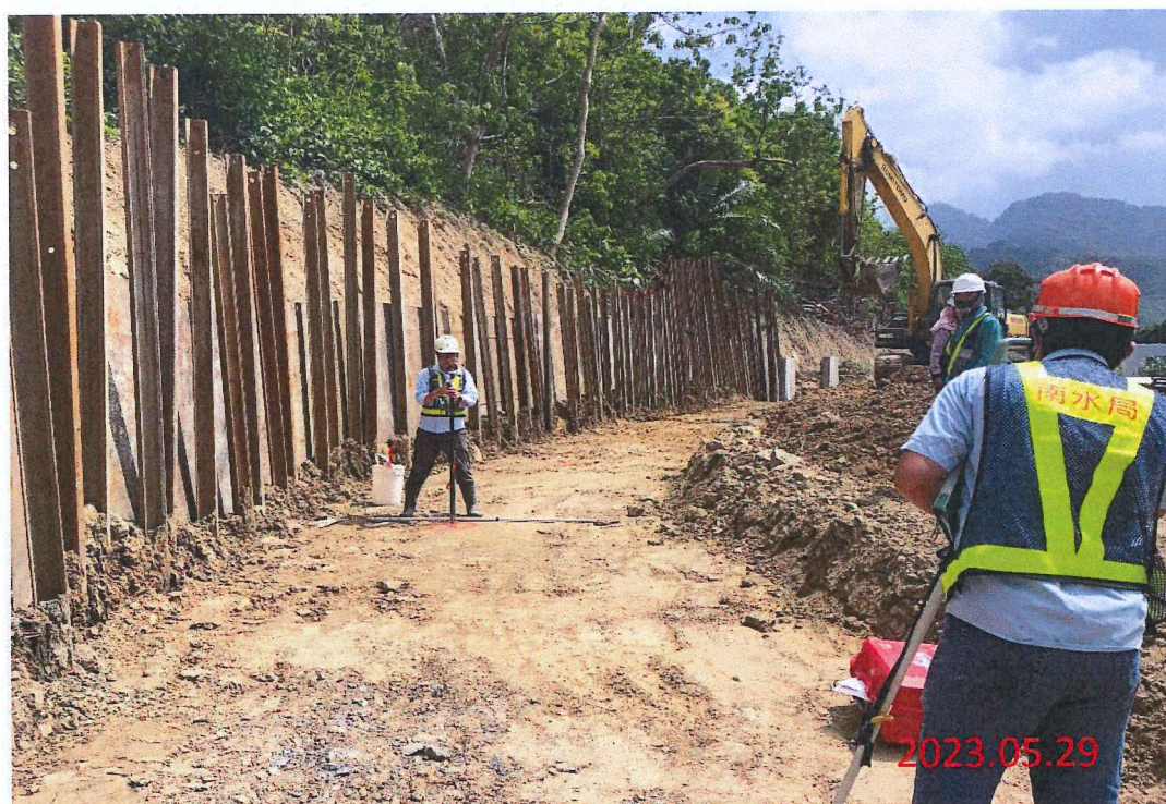
水土保持工程 UC1排水溝0K+694.067~0K+735.656基礎位置、高程放樣
