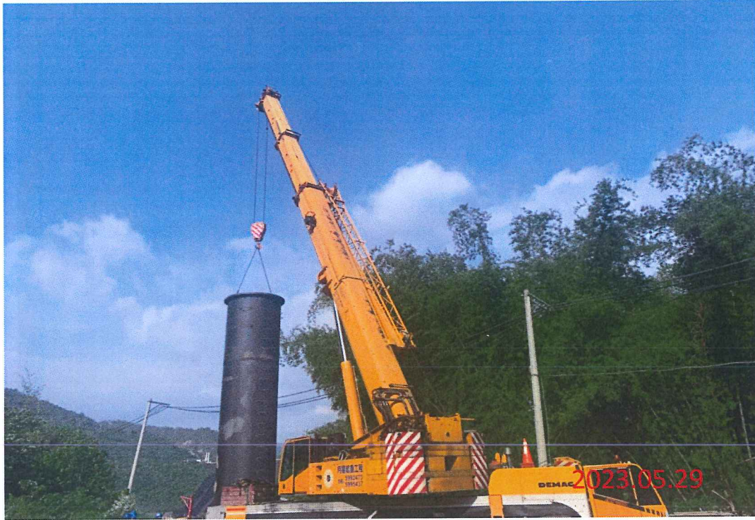
消能設施段工程 供水豎井鋼管銜接(EL:127~136M)
