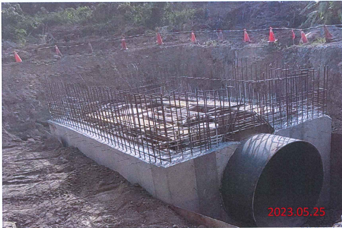
消能設施段工程 水量計窰井底版&牆身EL174.23~177.33 隱蔽物回填
