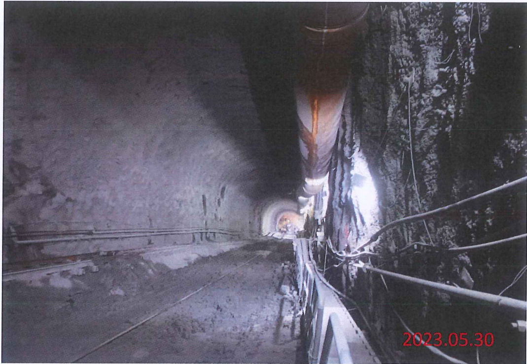
PRO操作風速過高改善工程 通氣斜坑H0K+166.36~0K+167.66(H126)開挖及一次支撐
