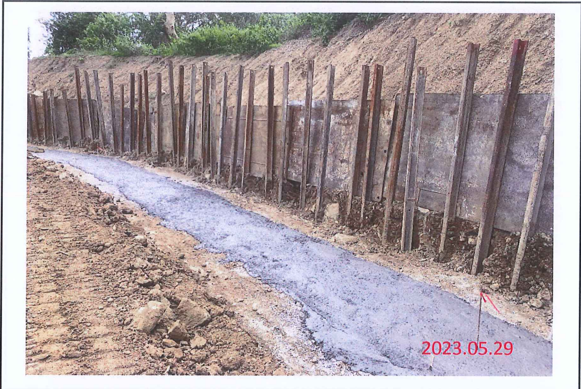
水土保持工程 UC1截水溝PC 140kgf/cm 2 混凝土澆置
