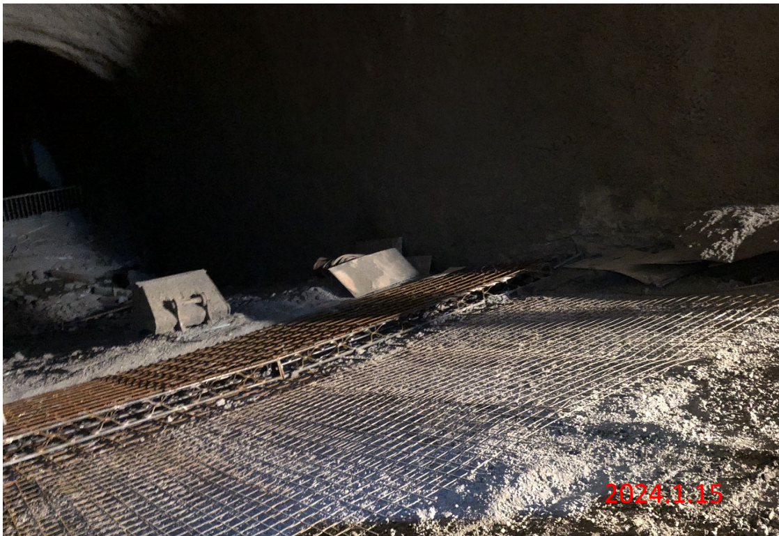
PRO操作風速過高改善工程 通氣斜坑 TOK+224.7~0K+223.2 一般段TypeII-C內襯砌(仰拱)
