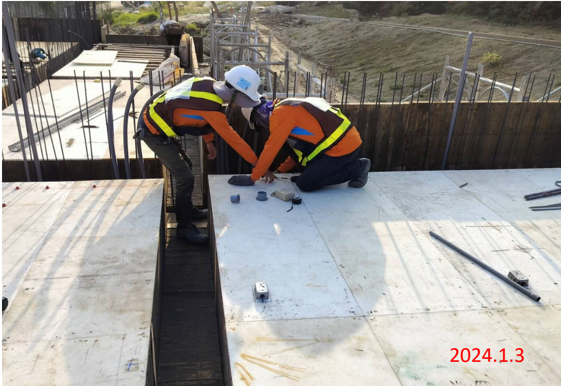
木瓜園操作機房 1F模板組立
