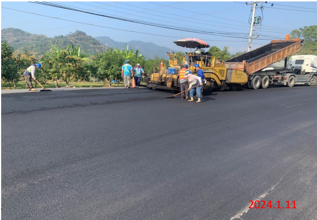
曾庫公路推進段工程 W09工作井 8K+193.8~203.8道路AC復舊
