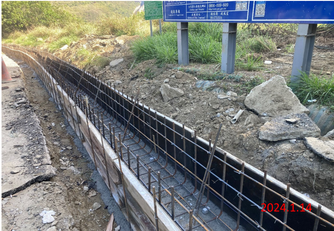
水土保持工程 UB2(1)、UB3、UB4排水溝底版模板組立及混凝土澆置
