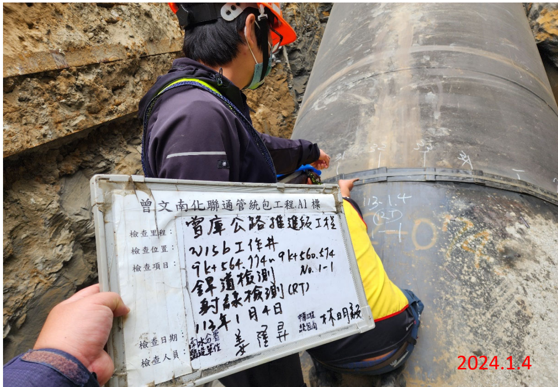
於112年1月4日至曾庫公路推進段工程W15B工作井辦理SP鋼管鋼道檢測 (VT、RT)
