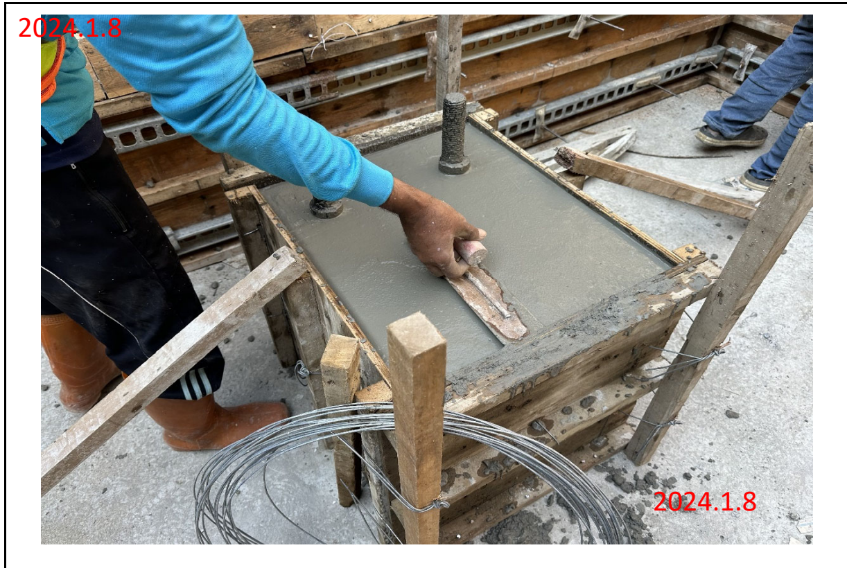
雙向備援工程 蝶型閥窰井蝶閥固定座 280kgf/cm 2 混凝土澆置
