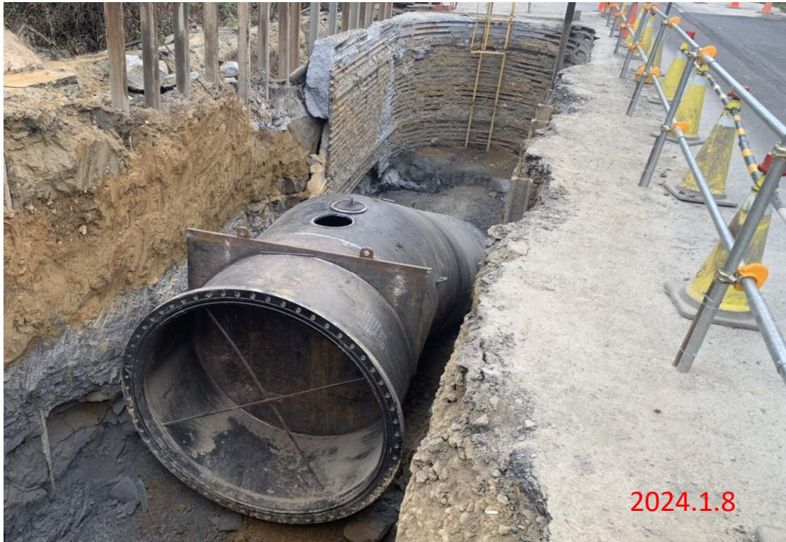
曾庫公路推進段工程 W15B工作井開挖
