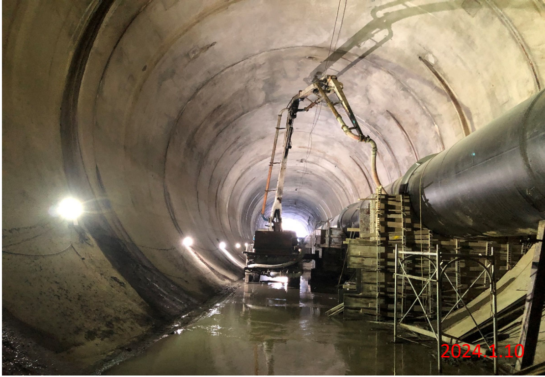
#2導水隧道 D0K+832.46~0K+754.46 基礎台(2) 280kgf/cm 2 混凝土澆置
