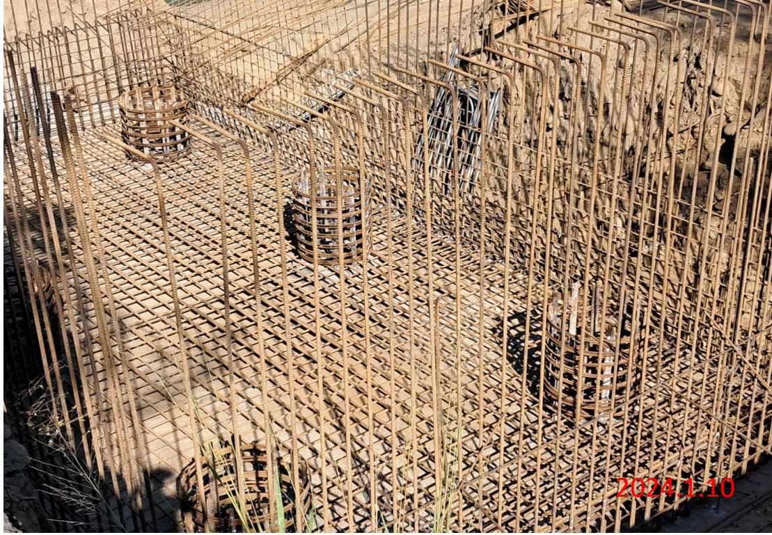
曾文二號水管橋 A2橋台鋼筋綁紮
