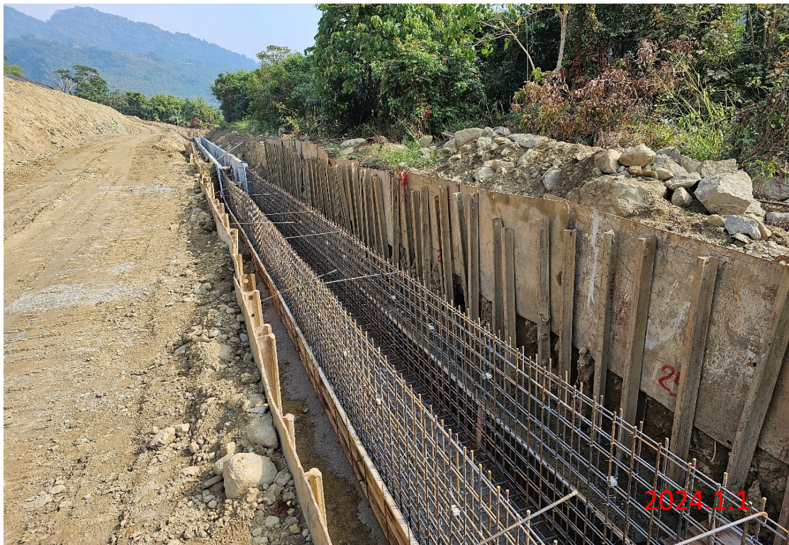
水土保持工程 DB滯洪沉砂溝(3)底版 280kgf/cm 2 混凝土澆置
