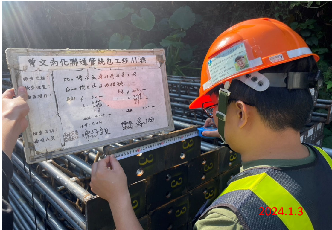
於112年1月3日 PRO操作風速過高改善工程進場查驗，鋼支保 G150，17組；鋼支保 G200，51組
