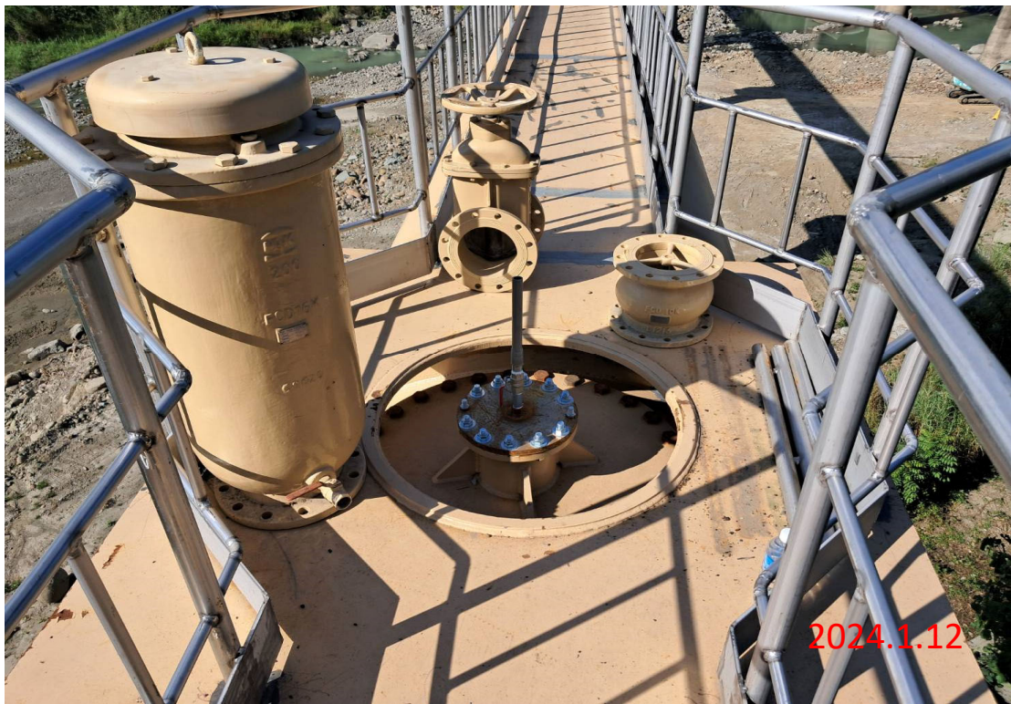
曾文三號水管橋 排氣閥安裝
