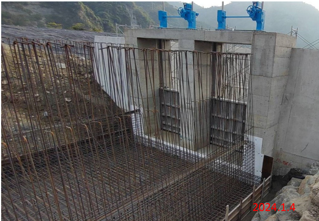
消能設施段工程 引水路箱涵底板模板組立
