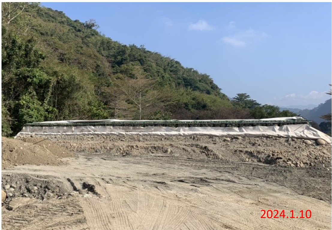
溪畔護岸整治工程 溪畔公園整地，HDPE管及不織布、排水器安裝
