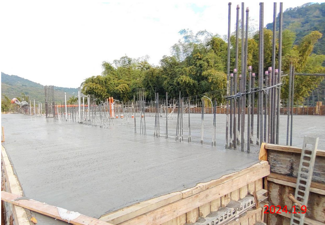
木瓜園操作機房 1F牆、柱、頂版、樓梯、2F樑，混凝土澆置
