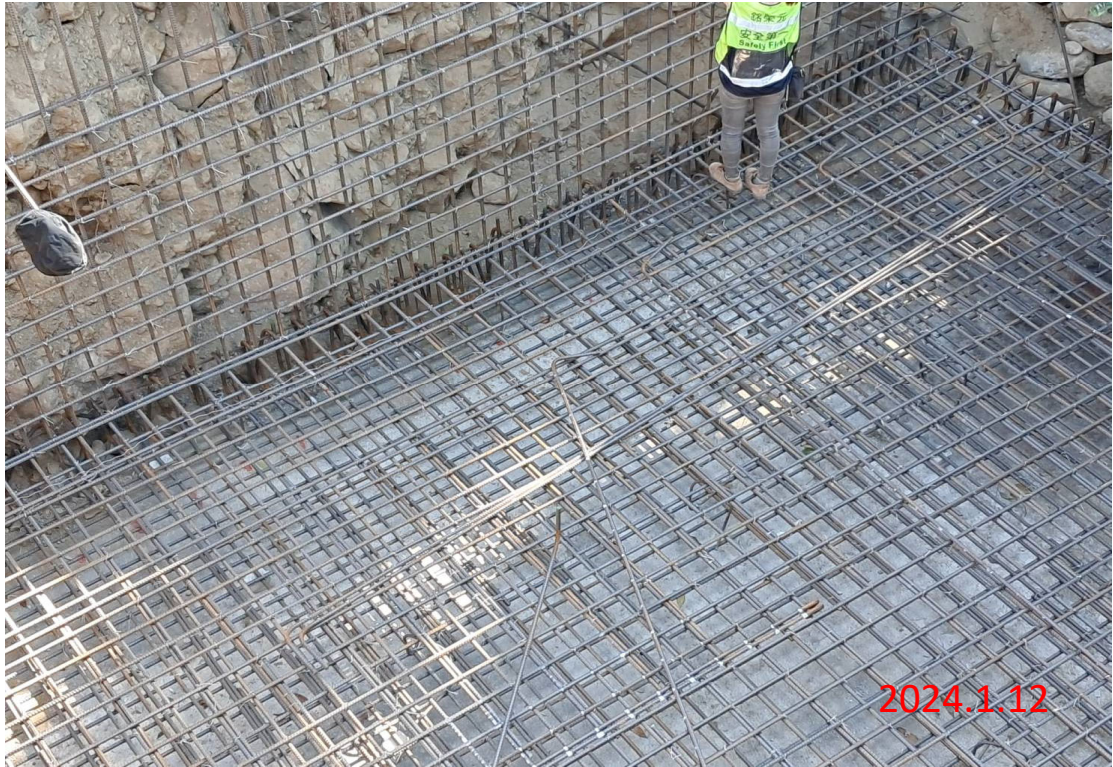
溪畔水管橋 A2可撓管窰井鋼筋綁紮
