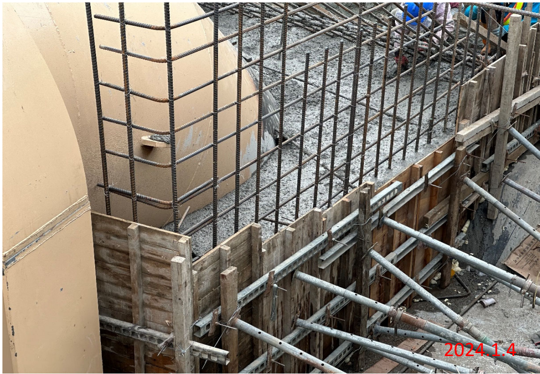
曾庫公路明挖段工程 4K+500.0 船型管A2橋台牆身第一昇層(0~1.2m)模 板組立及混凝土澆置
