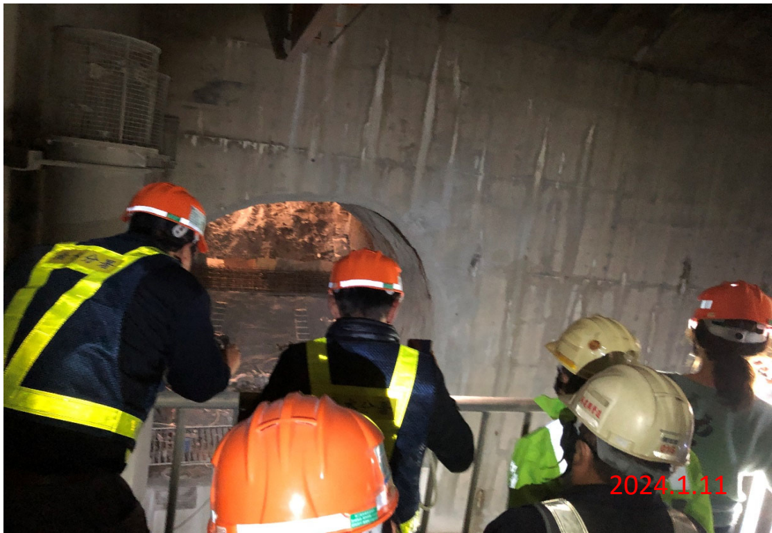
於113年1月11日假維護隧道口集合為配合曾文水庫安全檢查，養護科邀集PRO閘室抽排水現勘
