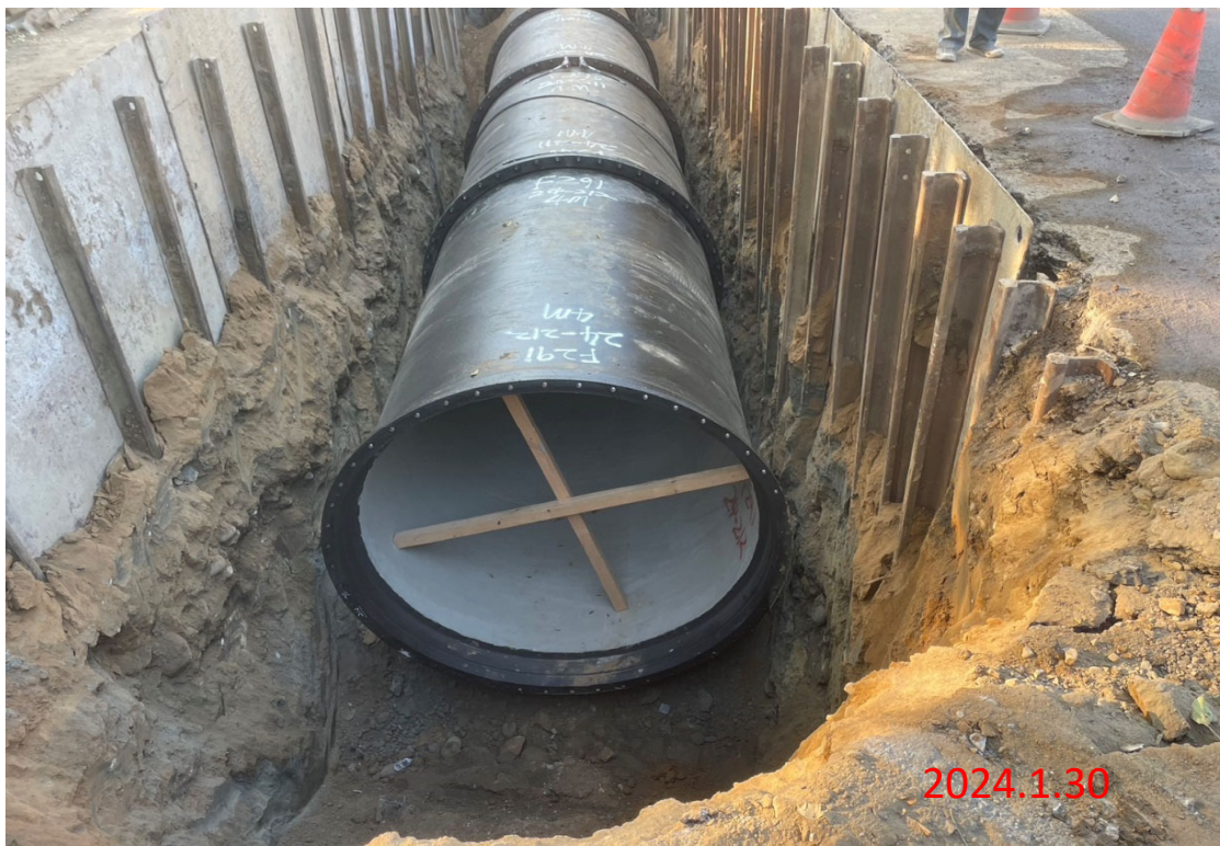
曾庫公路明挖段工程 6K+835.1~6K+843.1 土方開挖，K管埋設， \phi 2600mm
