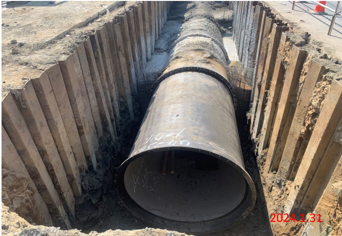
曾庫公路推進段工程W10A-W10 8K+466.337~8K+462.337 土方開挖，K管埋設， \phi 2600\text{mm}
