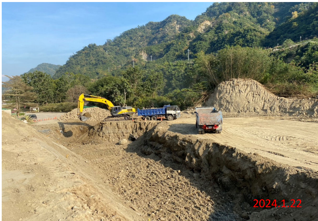
溪畔護岸整治工程 溪畔公園整地、土方回填
