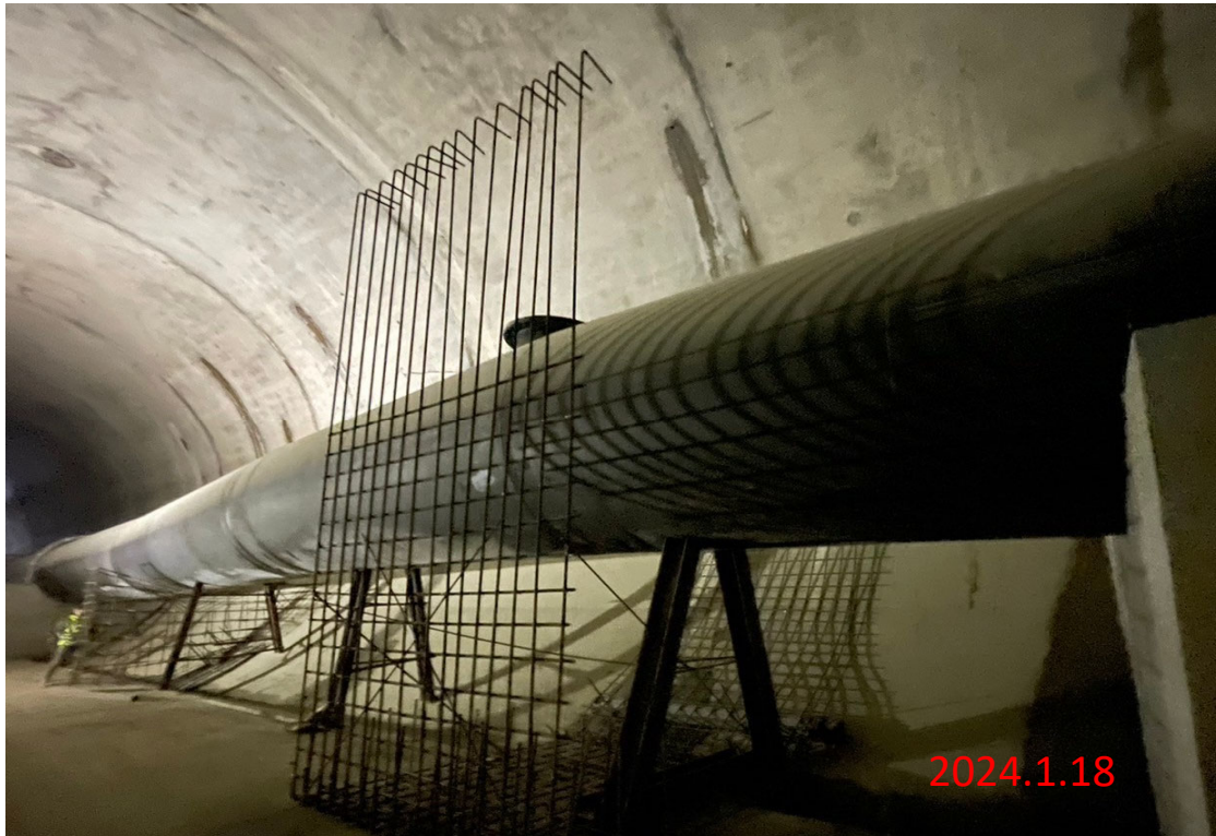
#2導水隧道 固定台(B0K+277.415)、基礎台(B0K+290)鋼筋綁紮
