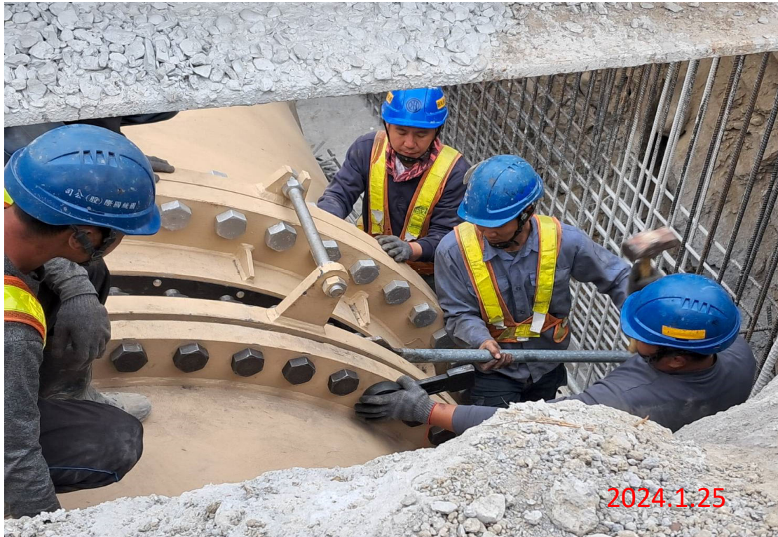
溪畔水管橋 A1、A2可撓管安裝鎖固
