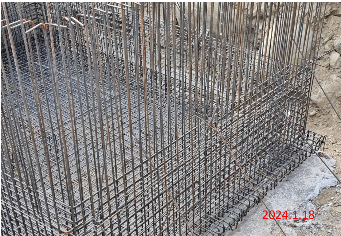
溪畔水管橋 A1可撓管窰井鋼筋綁紮
