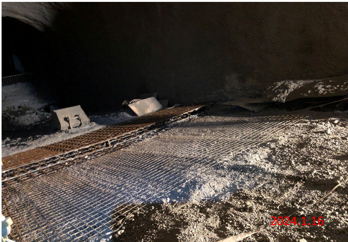
PRO操作風速過高改善工程 通氣斜坑 H0K+185.34~0K+182.79 210kgf/cm 2 鋪面噴凝土
