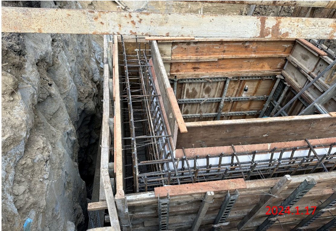
曾庫公路明挖段工程 2K+348.0 排泥閘窰井井蓋鋼筋綁紮、模板組立
