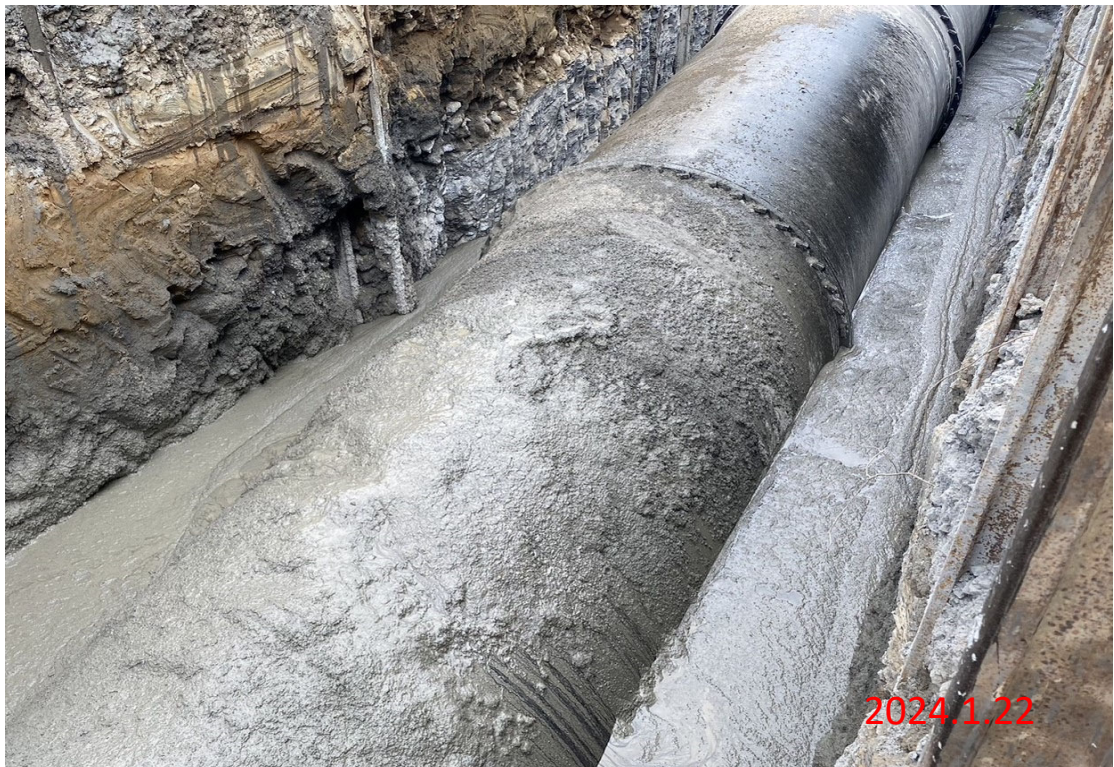
曾庫公路推進段工程W15B-W15 9K+553.047~533.047(2) 20~80kgf/cm 2 控制性低強度回填材料澆置
