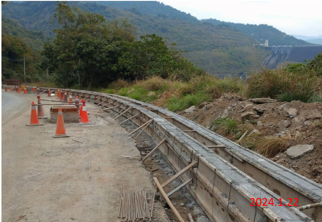
水土保持工程 UB4排水溝(2)牆身、D13集水井牆身 210kgf/cm 2 混凝土澆置
