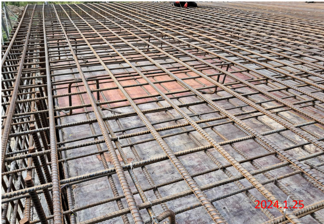
雙向備援工程 落水池頂版鋼筋綁紮
