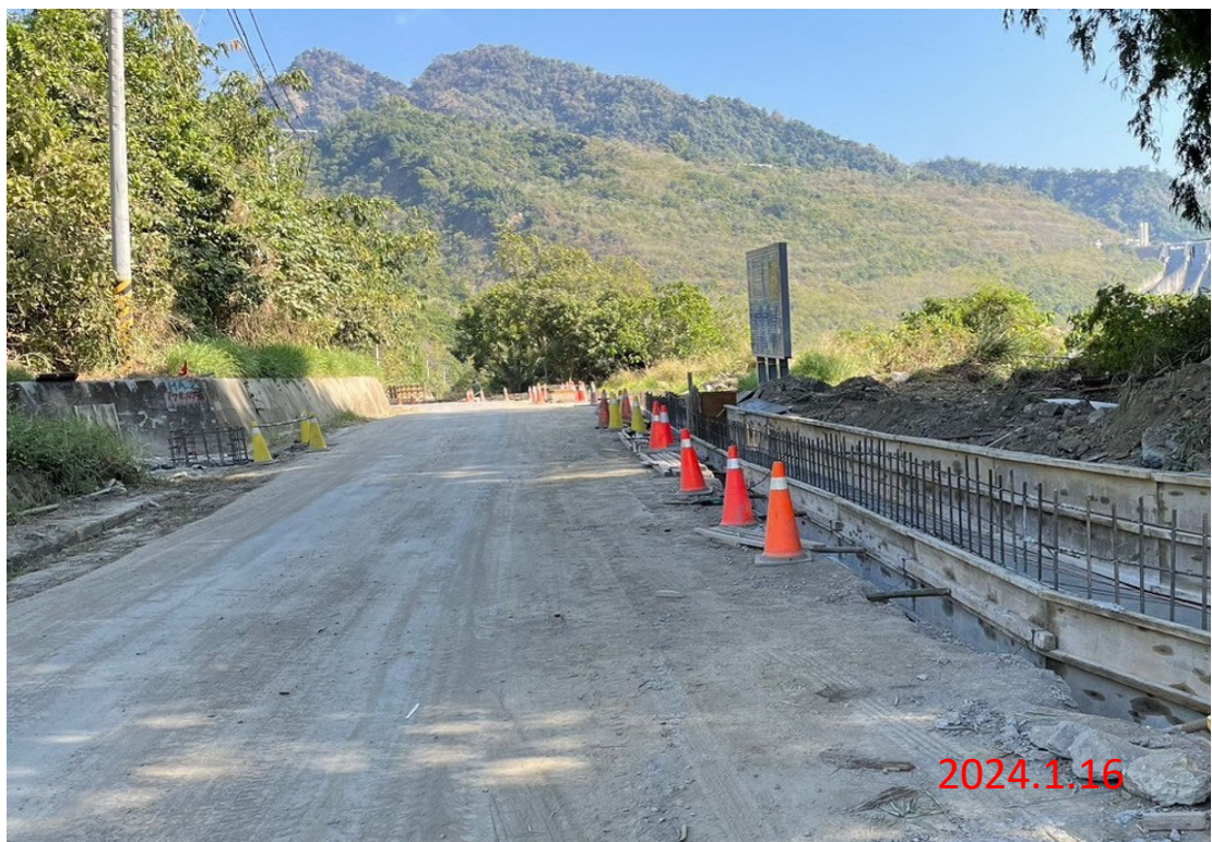
水土保持工程 UB2(1)、UB3、UB4排水溝牆身模板組立
