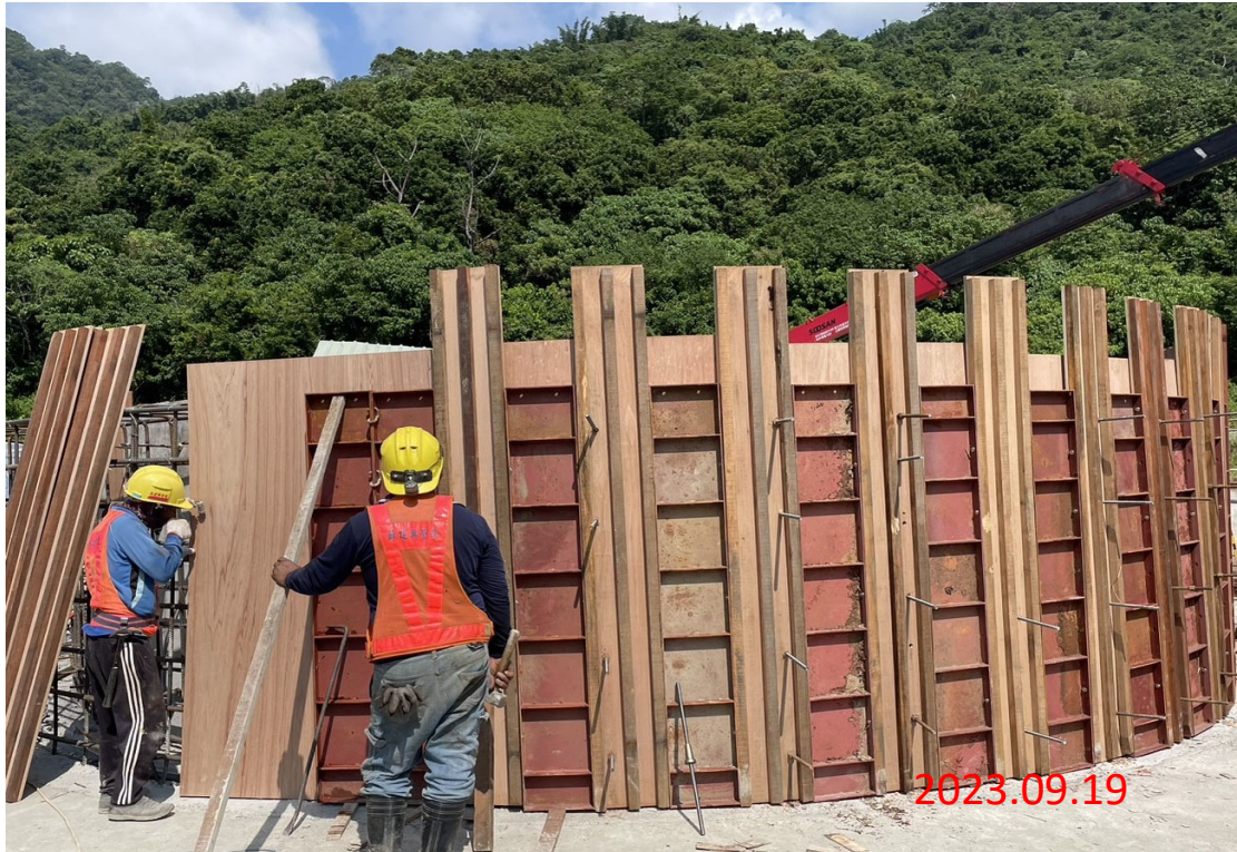
消能設施段工程 消能豎井第二十九昇層EL. 180.75~183.0 模板組立
