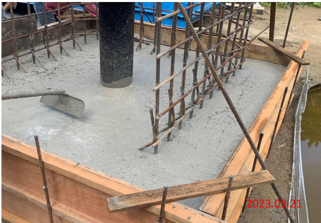
消能設施段工程 供水豎井排氣閥窰井地面護框基座 210kgf/cm 2 混凝土澆置
