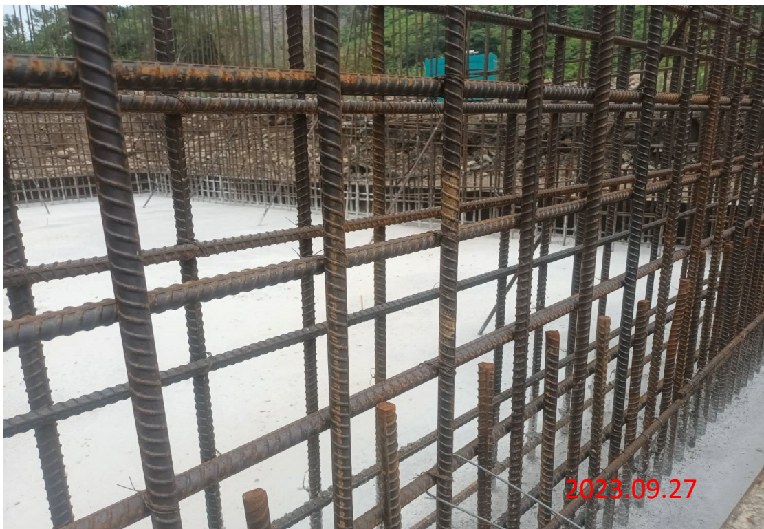
雙向備援工程 落水池底版 210kgf/cm 2 混凝土澆置
