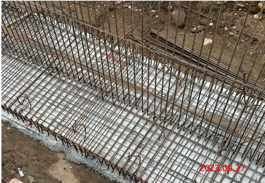
雙向備援工程 I0K+008.0~0K+054.0 懸臂式擋土牆鋼筋綁紮
