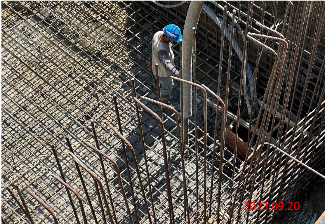
消能設施段工程 IV-04電動蝶型閥窰井底版(含集水坑) 280kgf/cm 2 混凝土澆置
