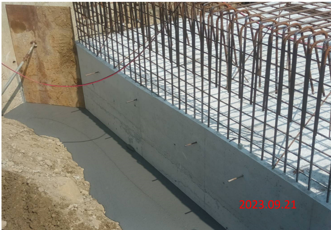
溪畔水管橋 A1橋台CLSM回填
