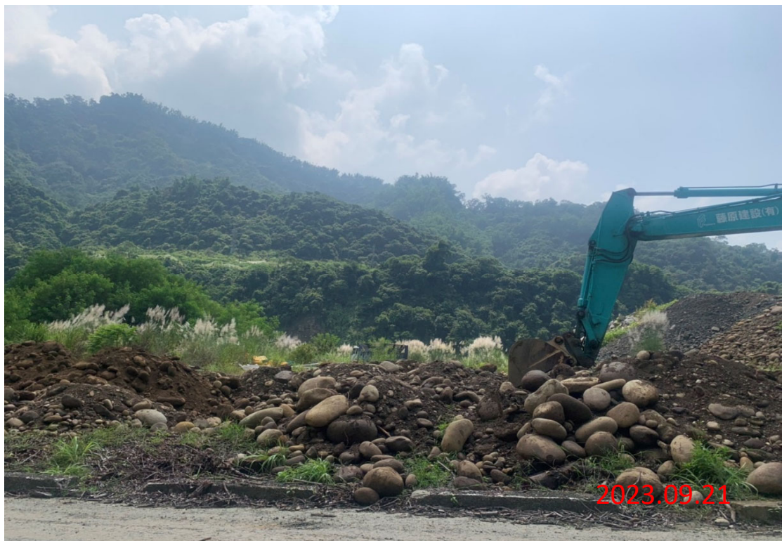
溪畔護岸整治工程 石籠前置作業
