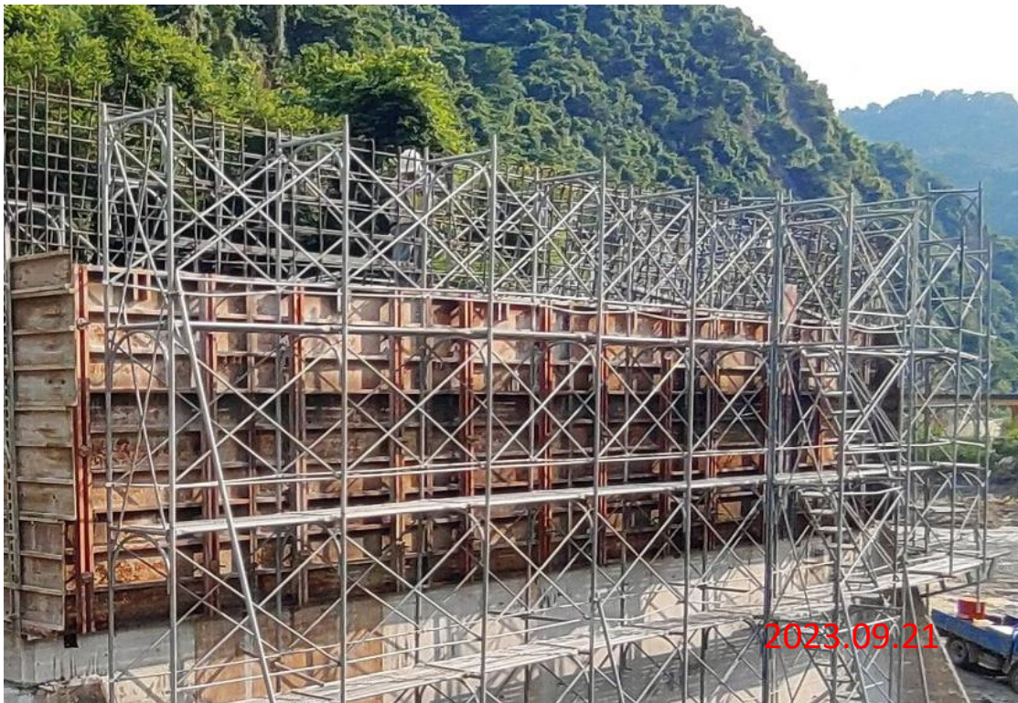
跨河段工程 防洪牆TYPE-III(6~9M) 210kgf/cm 2 混凝土澆置
