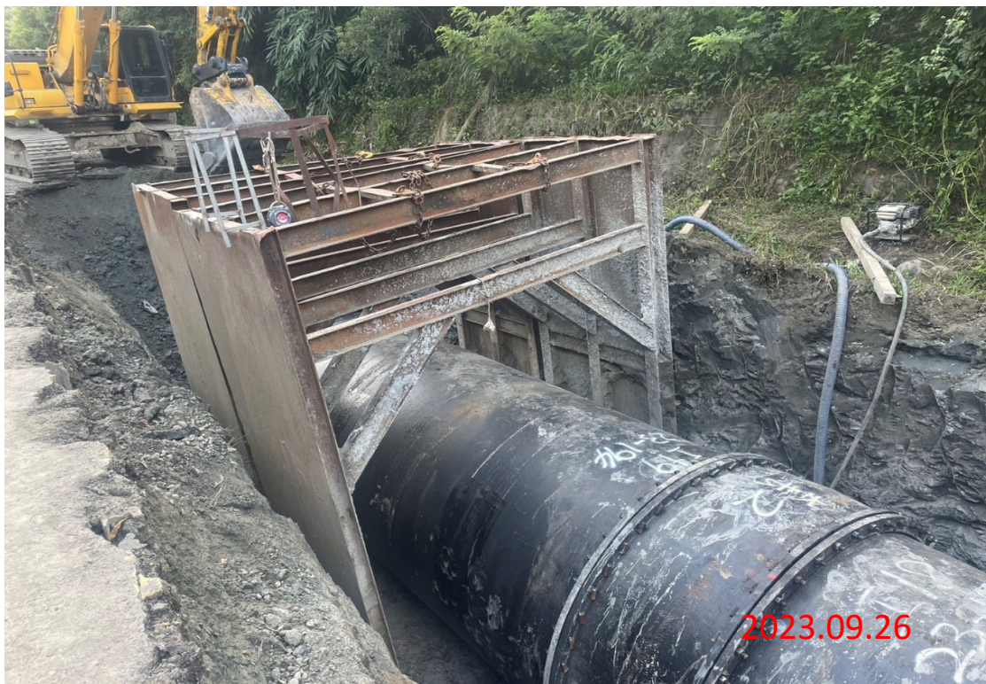
曾庫公路明挖段工程 4K+625.5~4K+626.5土方開挖，K型套管埋設， \phi 2600mm，L=1M_1支
