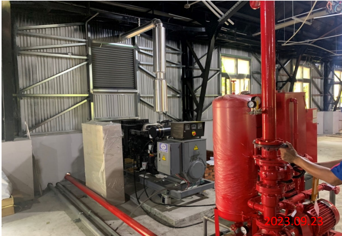
永續二館 餐廳消防發電機、泵浦試運轉，查驗
