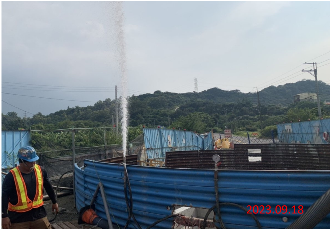
曾庫公路推進段工程 W10工作井往W08A(8K+342~8K+003.59)試壓及管內 水質檢測
