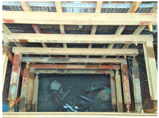
W50 工作井：工作井開坑作業
