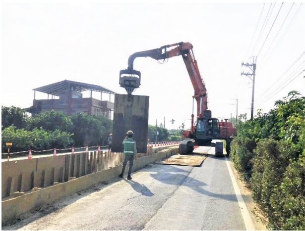
三埔段： 21k+639~21k+707 擋土鋼板拔除
