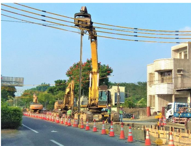
北寮段： 23k+949~23k+987 鋼軌樁打設
