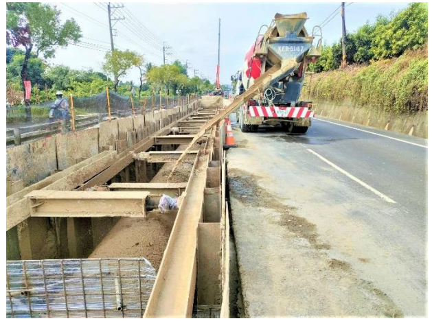
沙田段： 20k+578~20k+631 RMSM 回填
