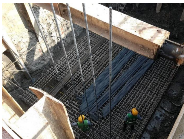
IV-12 蝶閥：窰井底版鋼筋綁紮
