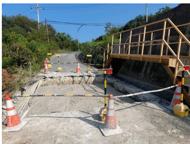
平壓段：0k+475~0k+528 RMSM 回填
