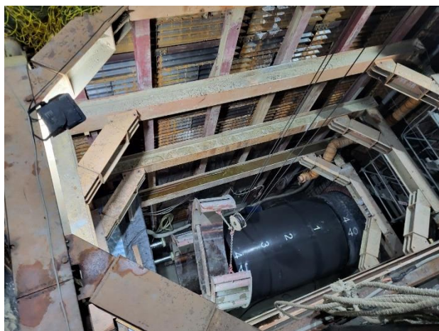
W50-1 工作井：推進作業施作
