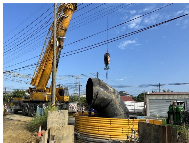
W50-2 工作井：鋼管吊裝
