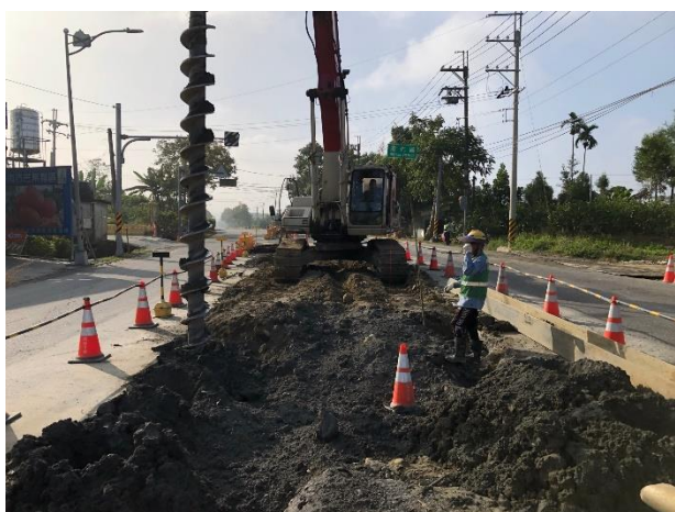
主線明挖段： 銜接四埔水管橋 A2 鋼軌樁引孔
