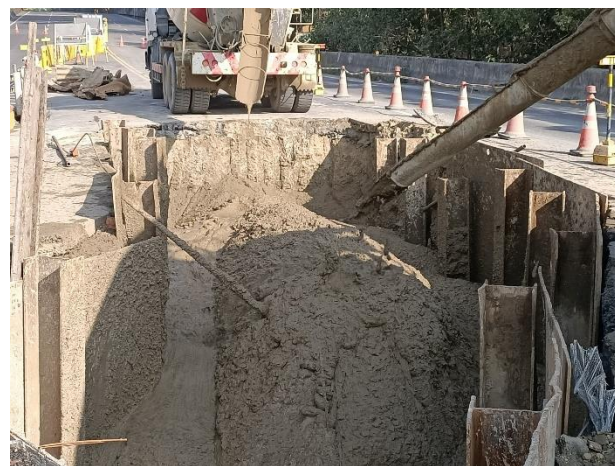
主線明挖段： 銜接四埔水管橋 A1 RMSM 回填
