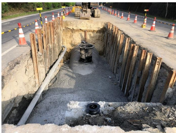
主線明挖段： 銜接三埔水管橋 A1 RMSM 回填
