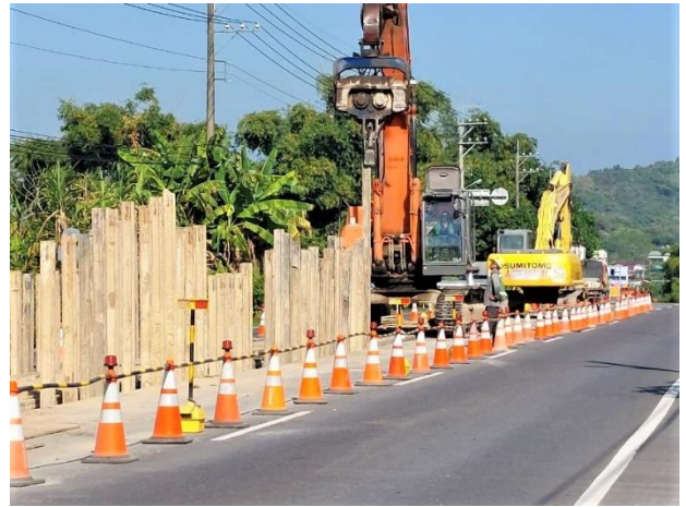
三埔段： 22k+320~22k+373 鋼軌樁打設
