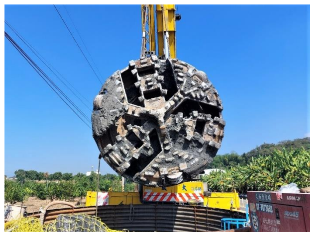
W59 工作井 → W58 工作井： 推進設備拆除
