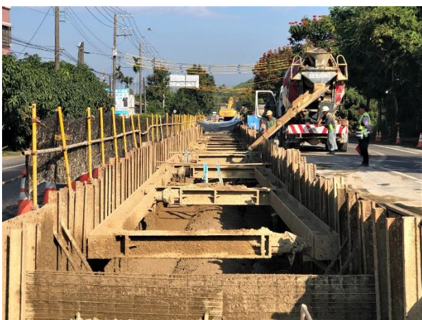
北寮段： 23k+941~24k+063 RMSM 回填
