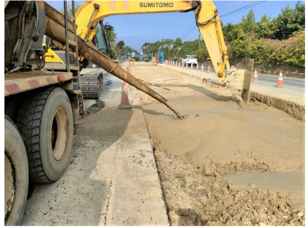
沙田段： 20k+540~20k+631 RMSM 回填
