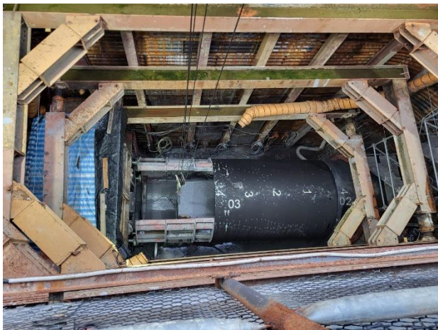
W50-1 工作井：推進作業施作
