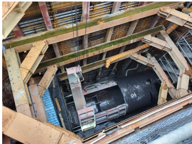
W50-1 工作井：推進作業施作
