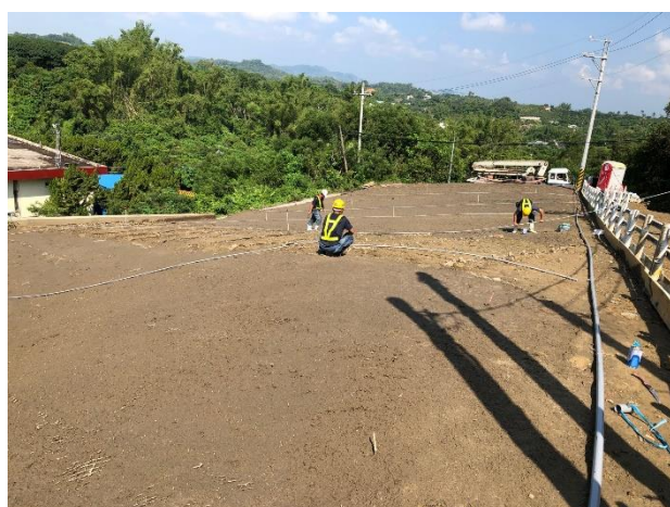
調節池消能設施：自動澆水管路配設
