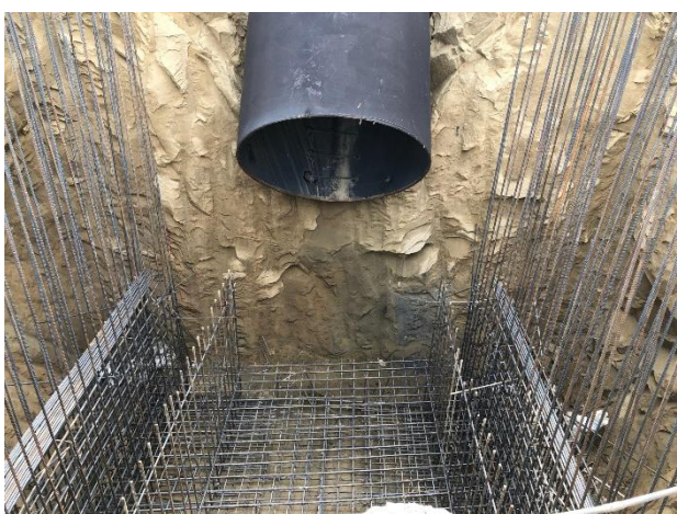
調節池消能設施： 調節池箱涵鋼筋綁紮
