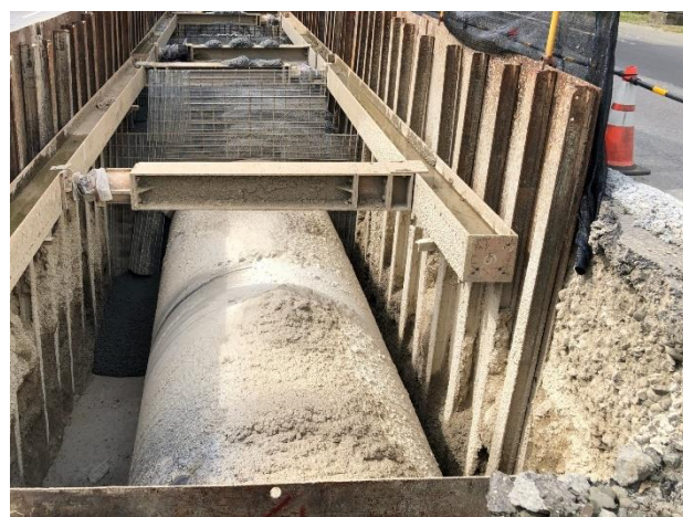
北寮段：銜接 T 型管固定台施作
