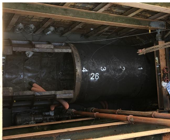
W54 工作井：推進作業施作
