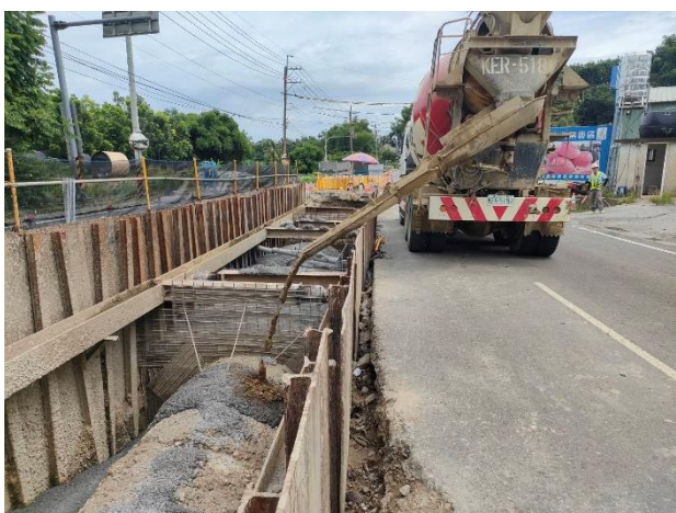
北寮段： 23k+534~23k+572 RMSM 回填
