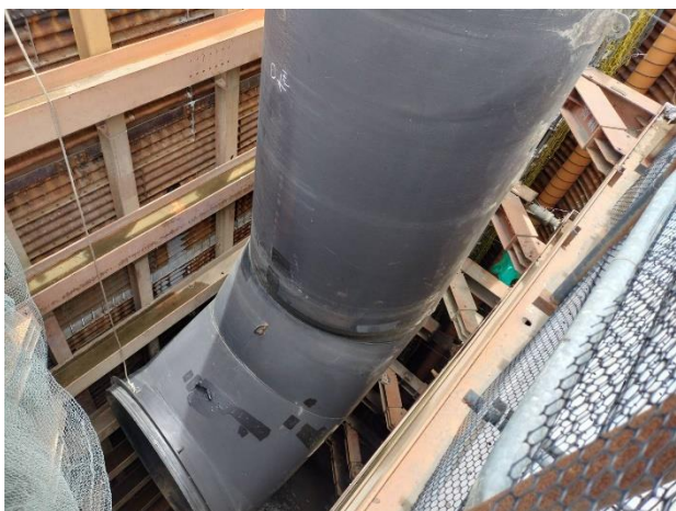
W50 工作井：鋼管吊裝
