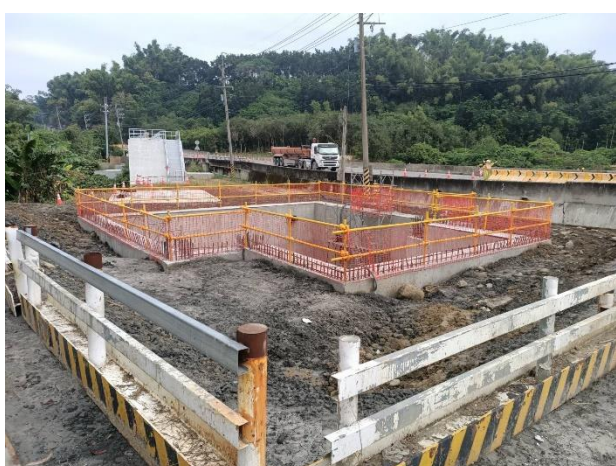
IV10 球閥：欄杆施作
