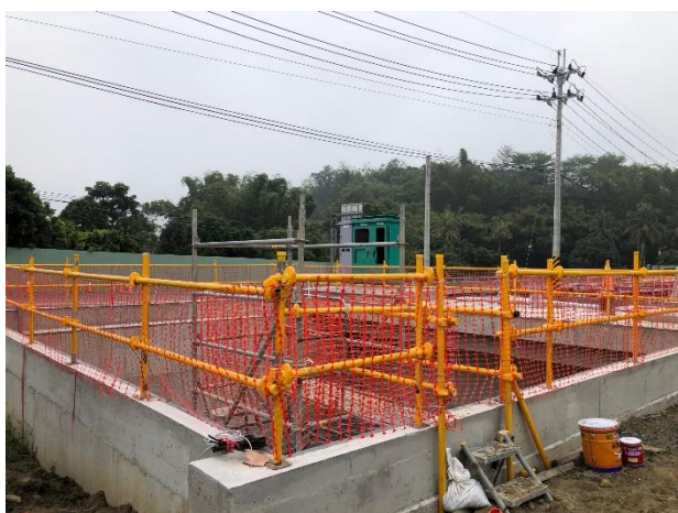
IV09 球閥：欄杆施作
