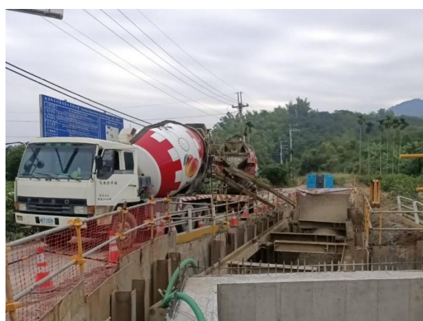
平壓明挖段：RMSM 回填
