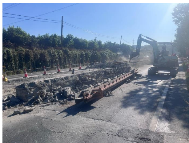
W50-1 工作井：天車軌道破除作業
