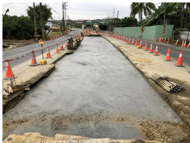
主線明挖段： 銜接三埔水管橋 A1 管溝開挖
