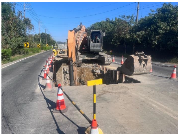
主線明挖段： 銜接沙田水管橋 A2 RMSM 回填
