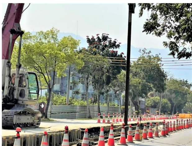
北寮段： 23k+721~23k+782 鋼軌樁打設
