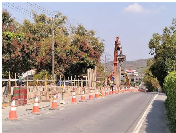
三埔段： 21k+395~21k+456 鋼軌樁打設
