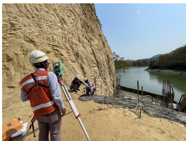
調節池消能設施：齒墩位置放樣
