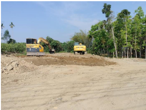
四埔水管橋 A2 整理復舊
