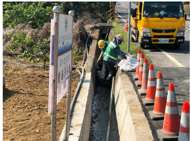
平壓明挖段整理復舊
