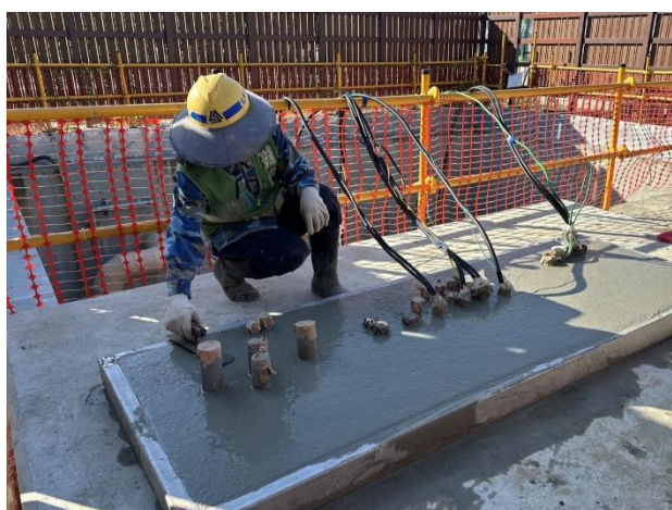
IV-08 球閥：配電盤基座混凝土澆置
