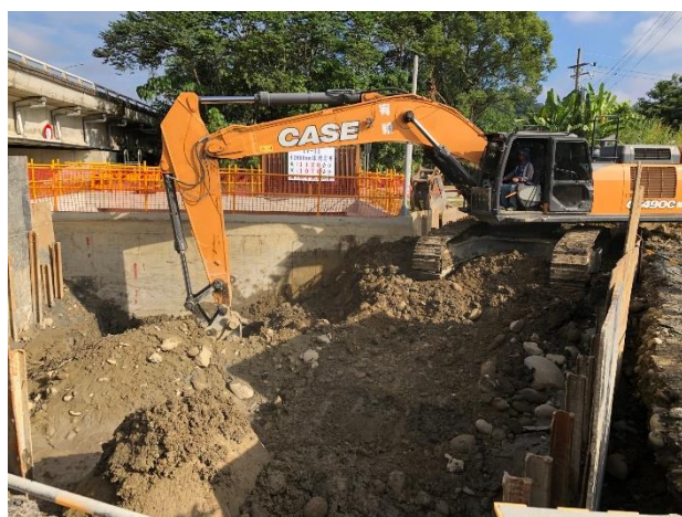
明挖段：銜接 IV-11 球閥 管溝開挖
