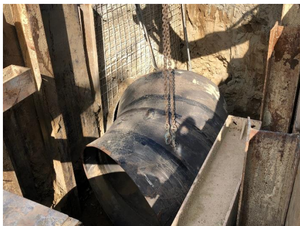
明挖段： 銜接沙田水管橋 A2 鋼管吊裝
