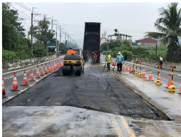
明挖段：21k+939.25 神農廟前過箱涵固定台 瀝青鋪築
