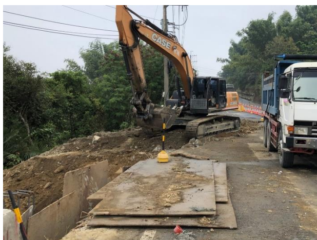
明挖段： 銜接四埔水管橋 A1 管溝開挖
