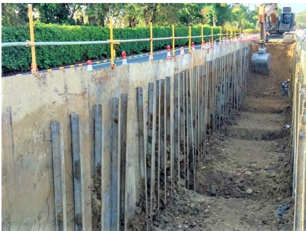
北寮段：23k+821~23k+881 管溝開挖
