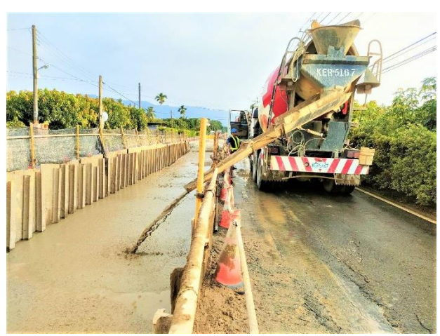
三埔段： 21k+753~21k+791 RMSM 回填
