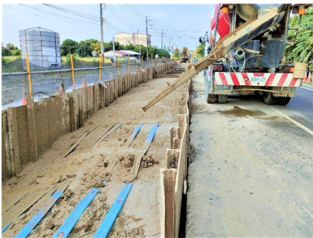
北寮段： 24k+093~24k+139 RMSM 回填
