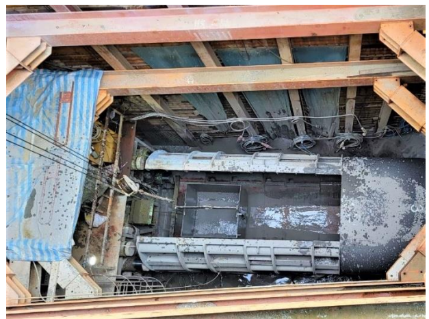
W57 工作井：推進作業施作
