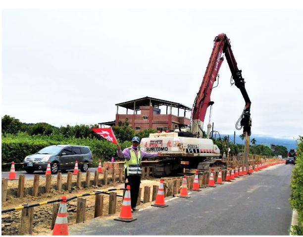
三埔段： 21k+639~21k+707 擋土鋼鈹打設
