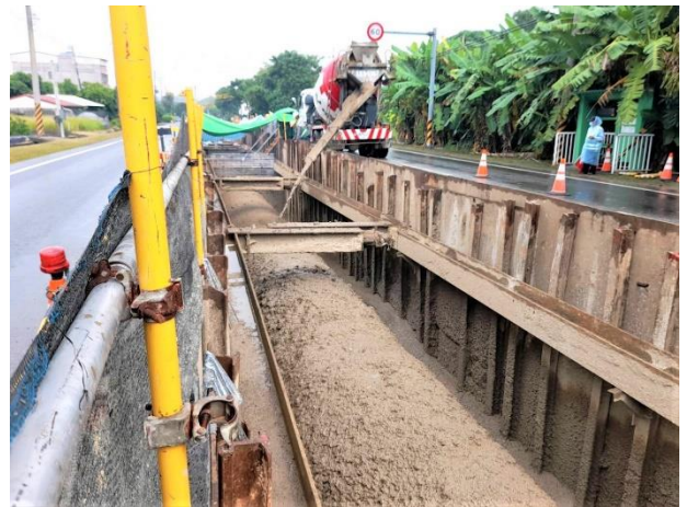
北寮段： 24k+063~24k+139 RMSM 回填
