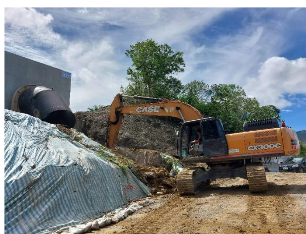
調節池消能設施：箱涵基礎開挖
