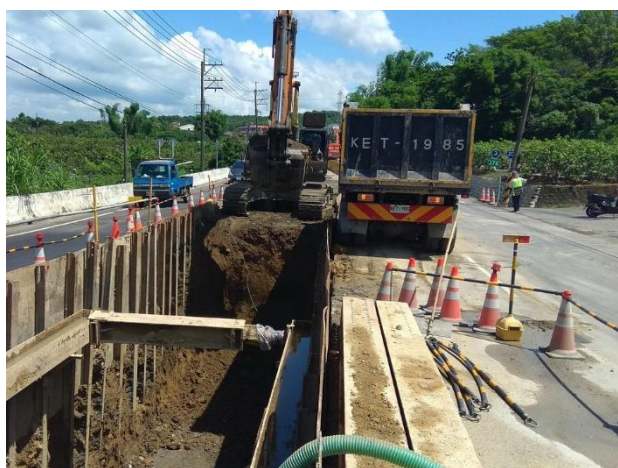
三埔段：21k+112~21k+158 管溝開挖
