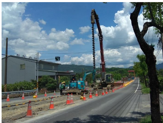
沙田段： 20k+357~20k+423.6 鋼軌樁引孔
