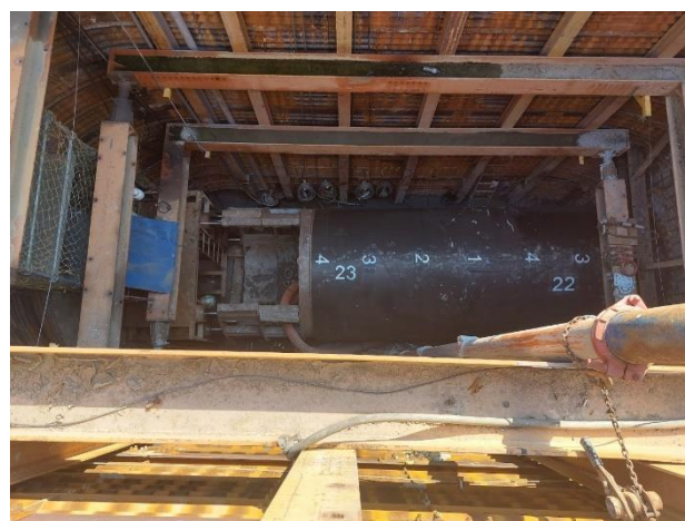
W54 工作井：推進作業施作
