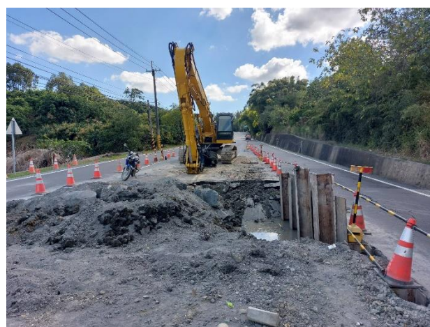
平壓明挖段：管溝開挖
