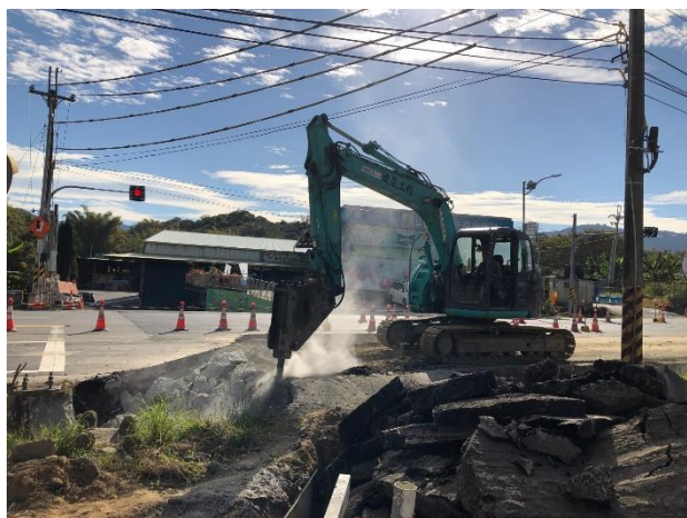
主線明挖段： 銜接四埔水管橋 A2 管溝開挖
