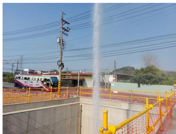
IV-11 球閥：試水試壓
