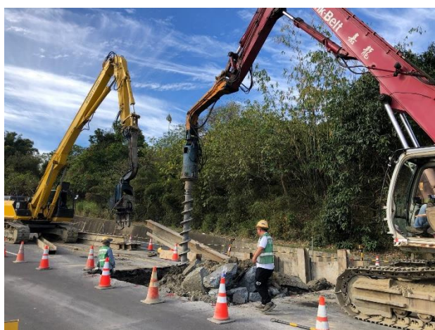
平壓明挖段：鋼軌樁引孔
