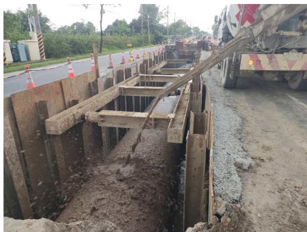
沙田段： 20k+513~20k+540 RMSM 回填
