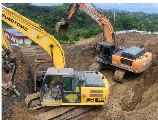
平壓段：0k+534~0k+572 管溝開挖
