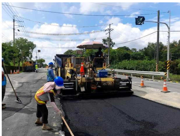
沙田段：20k+354~20k+423 瀝青鋪築
