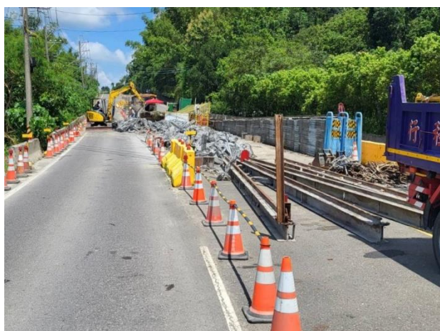
W54 工作井：推進設備拆除
