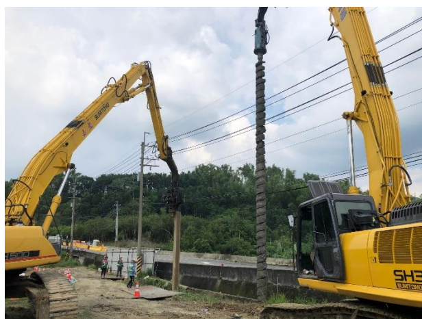
IV-10 球閥：球閥窰井擋土施作
