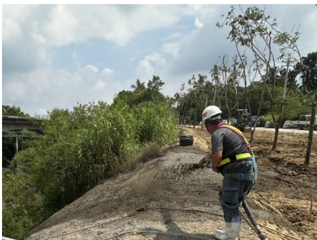
三埔水管橋：A2 噴植生施作
