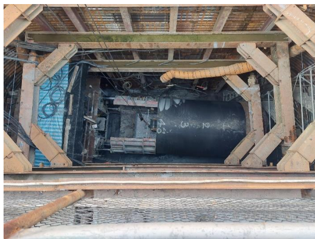
W50-1 工作井：推進作業施作
