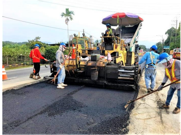
三埔段：21k+800~21k+883 瀝青鋪築
