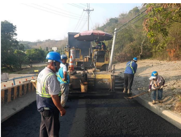
平壓段瀝青鋪築
