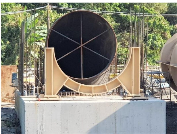
鏡面水庫水管橋： A2 固定環樑座吊裝
