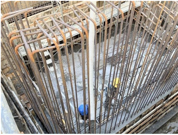
沙田水管橋： A1 可撓管窰井第一升層澆置
