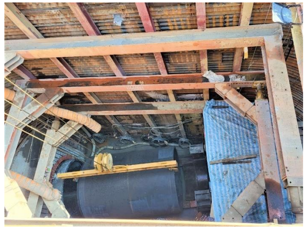
W57 工作井 → W56 工作井： 推進工程施作
