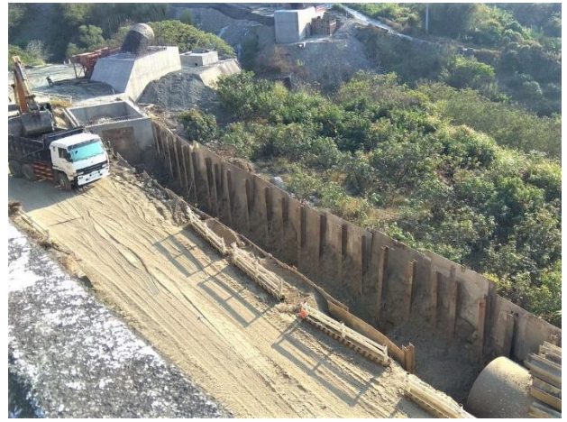
三埔水管橋 → 三埔段： 22k+373~22k+414.6 管溝開挖
