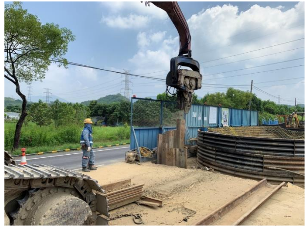
W50 工作井：擋土鋼板打設
