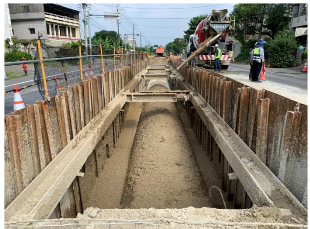
北寮段： 24k+139~24k+177 RMSM 回填
