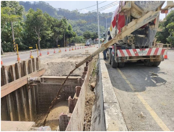
W39 工作井 → 中正段： 16k+726~16k+745 RMSM 回填
