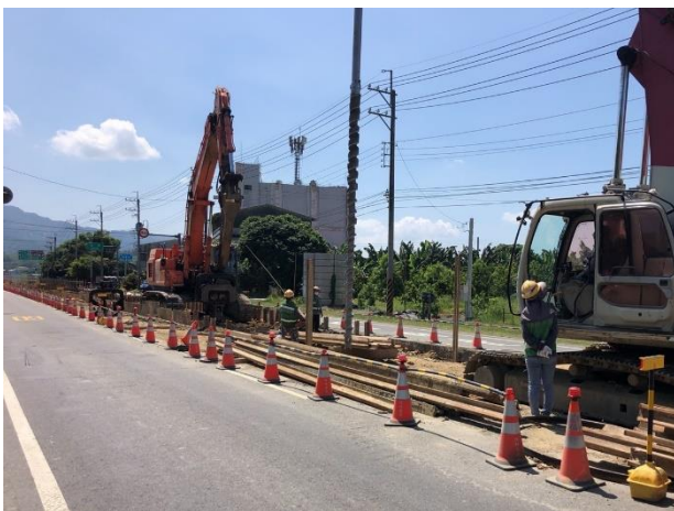
北寮段： 24k+093~24k+139 鋼軌樁打設
