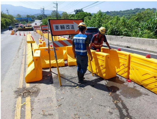
W39 工作井 → 中正段： 16k+726~16k+745 RMSM 回填
