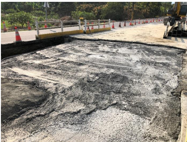
平壓明挖段：RMSM 回填
