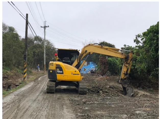
平壓明挖段：管溝開挖
