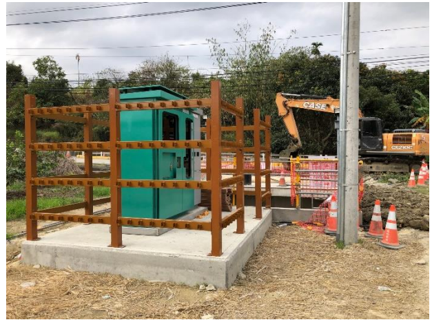
IV-10 球閥： 機電設備仿木隔離設施施作
