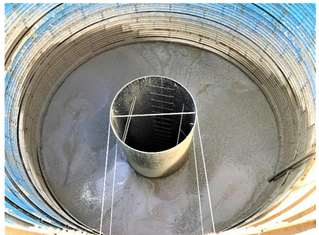
W59 工作井：工作井回填作業
