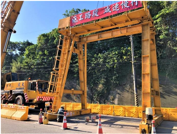
W52 工作井：推進設備拆除
