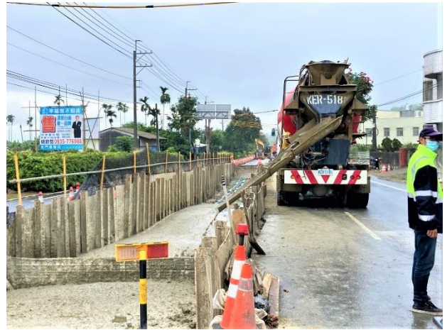
北寮段： 23k+941~23k+987 RMSM 回填
