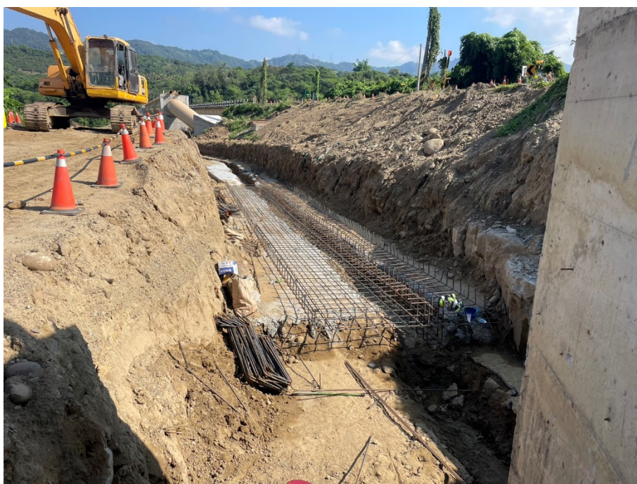
地點： 曾文一橋引道 日期： 112.07.15 說明： 擋土牆基礎鋼筋綁紮
