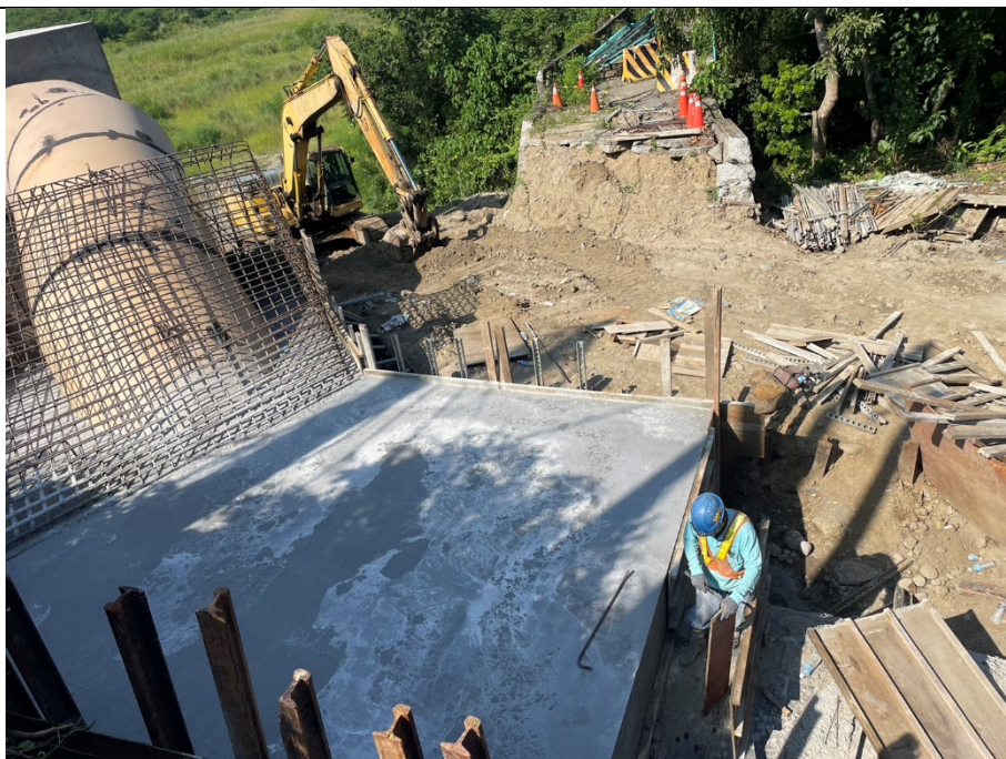
地點： A1 鎮墩 日期： 112.07.15 說明： 第 2 昇層混凝土澆置
