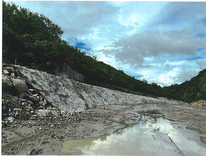
河道施工，無移除樹種
