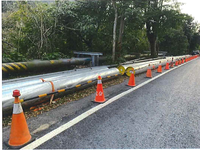
明確區隔工區範圍
