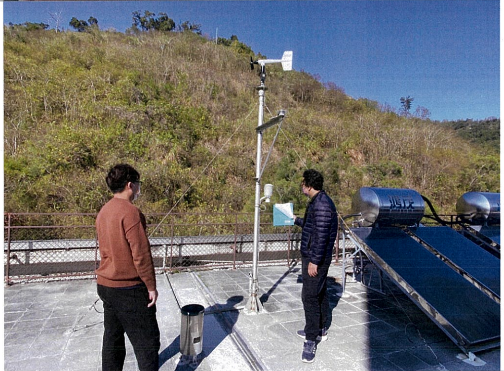
大壩儀器檢查
