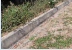
③ 蓄水護岸配合溪流流路設置的砌石護岸
