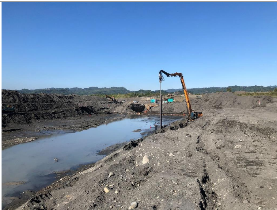
地點： 荖濃溪集水暗管 日期： 112.12.29 說明： 13M 鋼板樁打設施作
