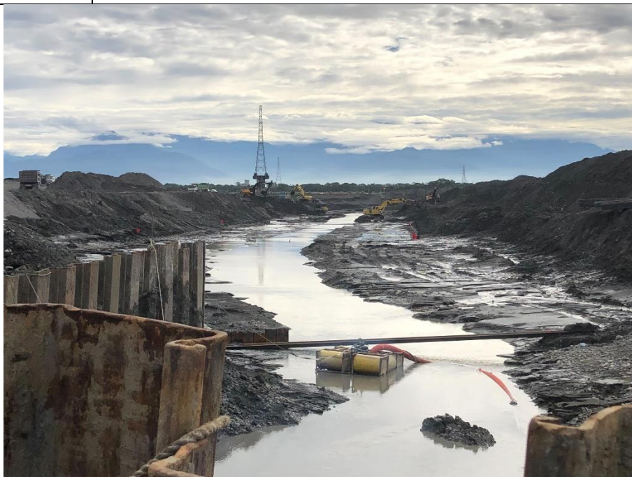
地點： 荖濃溪集水暗管 日期： 112.12.28 說明： 土方開挖及圍堰施作
