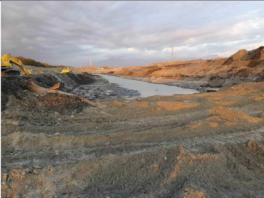
地點： 荖濃溪集水暗管 日期： 113.2.29 說明： 荖濃溪 C 管段第一層土方開挖
