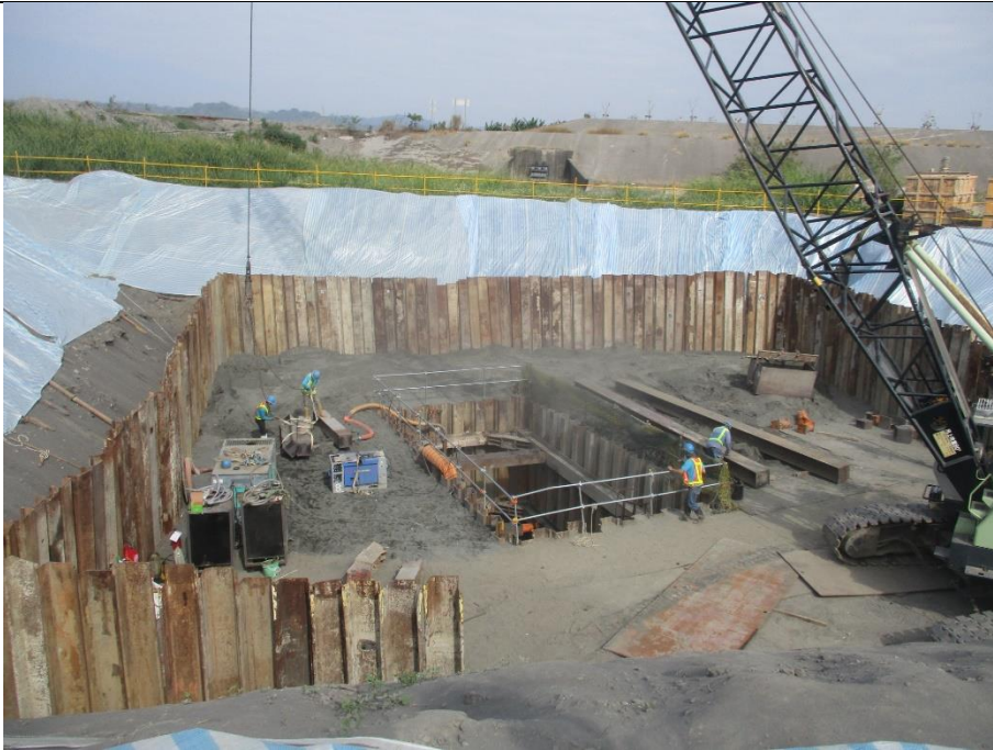
地點： 荖濃溪新增推進井 日期： 113.2.29 說明： H型鋼支撐施作
