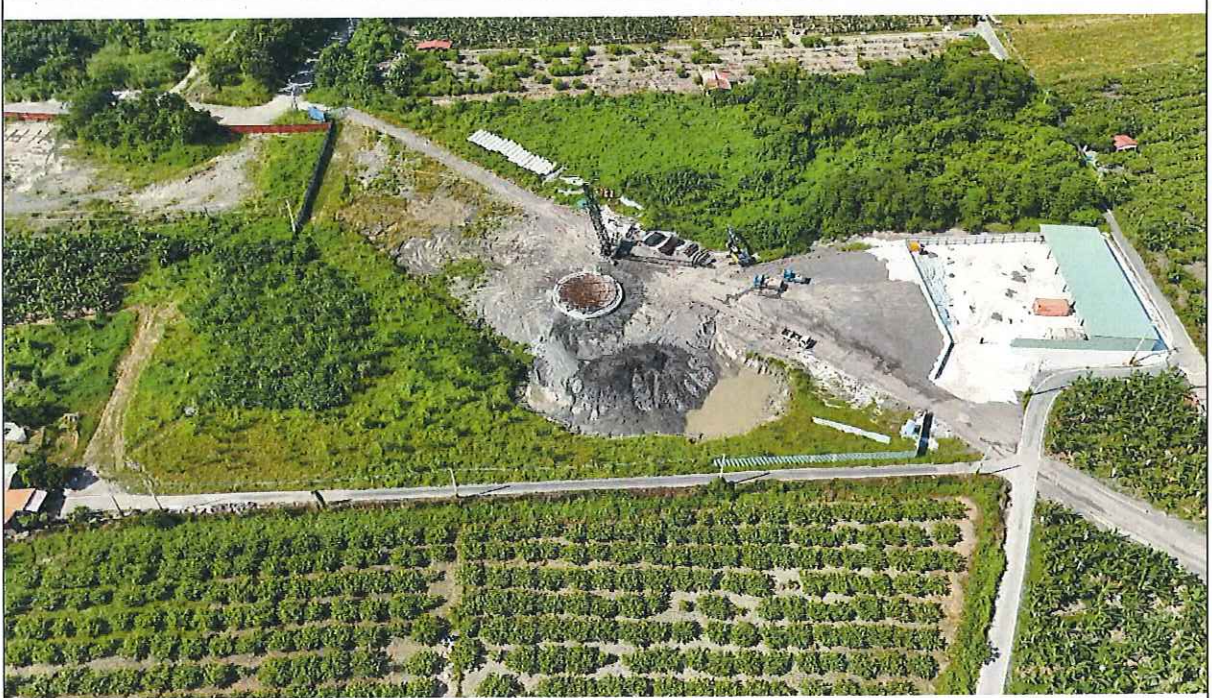
井2旗山溪施工現場情況
