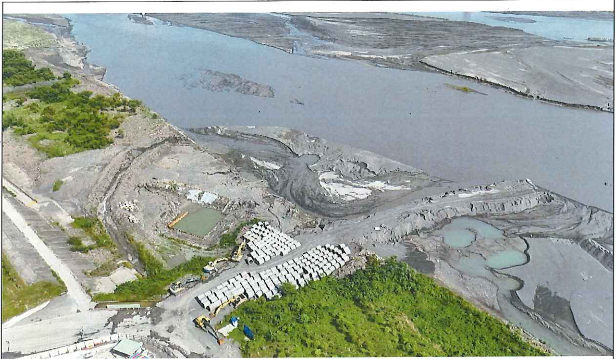
荖濃溪施工現場情況
