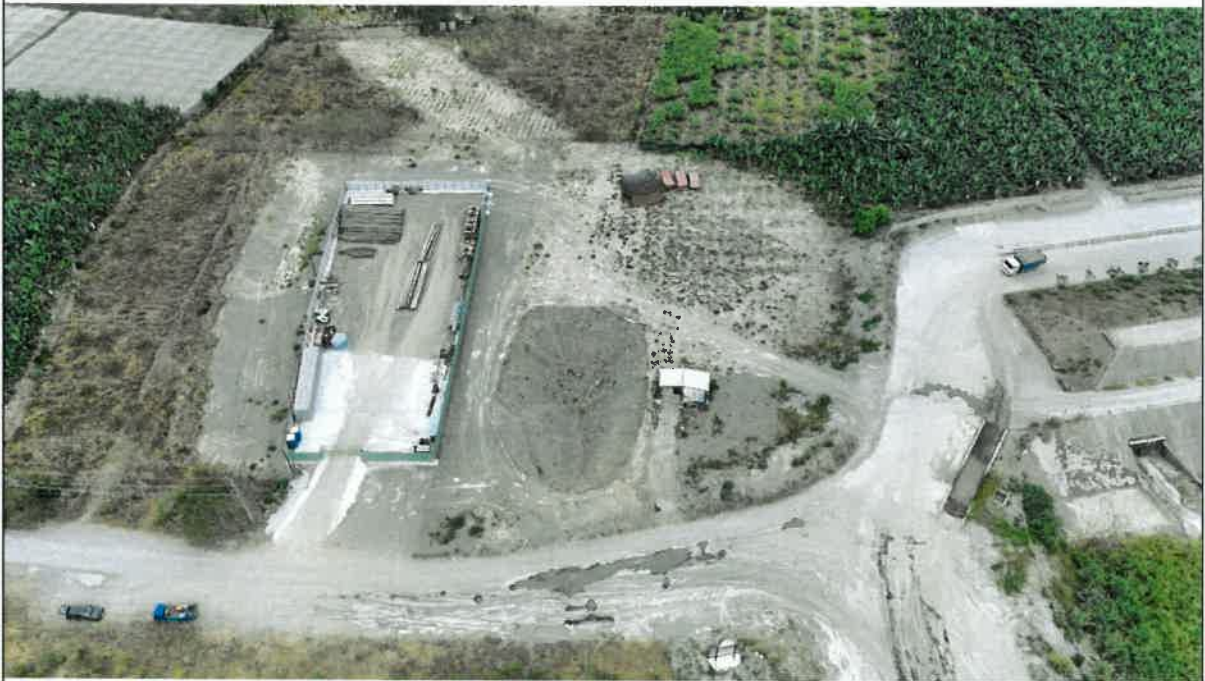
集水井#1 周邊施工現況-2
