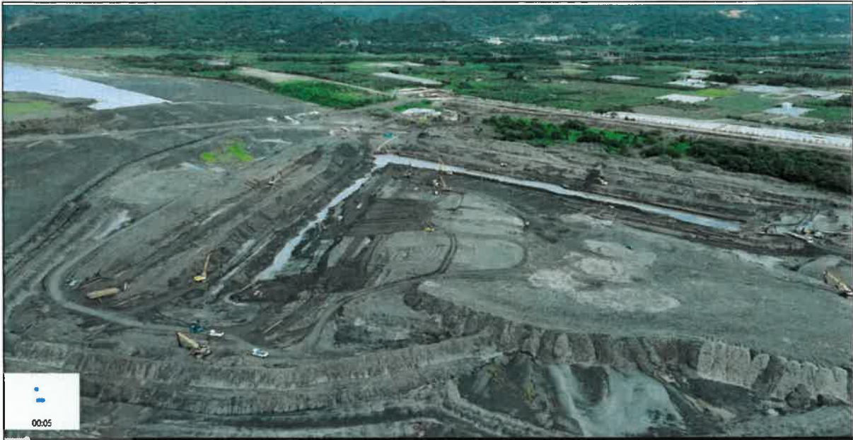
荖濃溪施工現場情況-1
