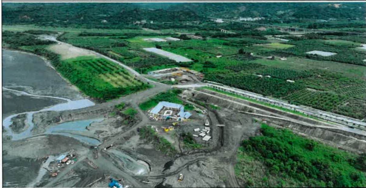
荖濃溪施工現場情況-2
