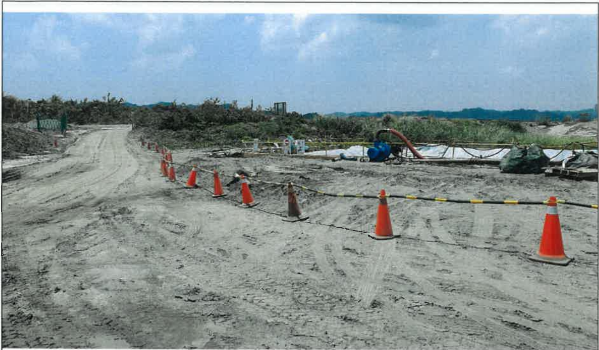
集水井#1 周邊施工現況-1
