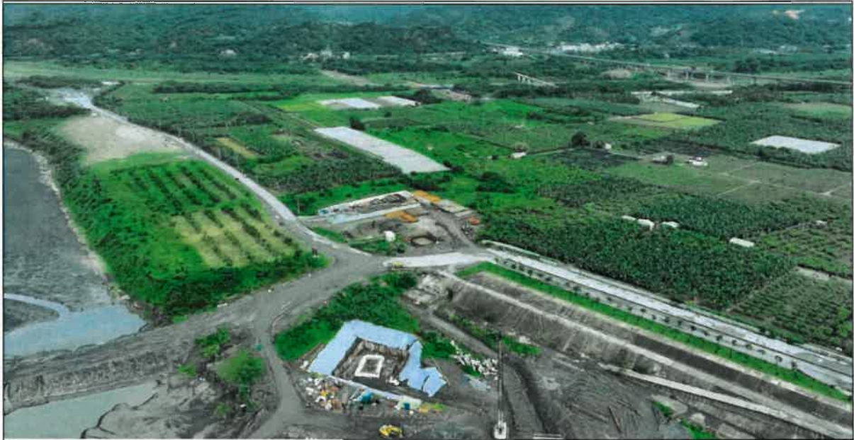
集水井#1 周邊施工現況-1
