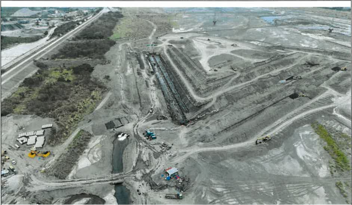
荖濃溪施工現場情況-1
