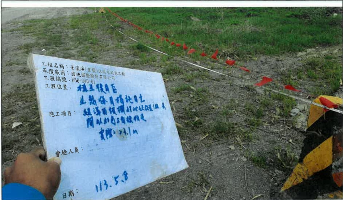
植生復育區外圍隔離帶架設現況
