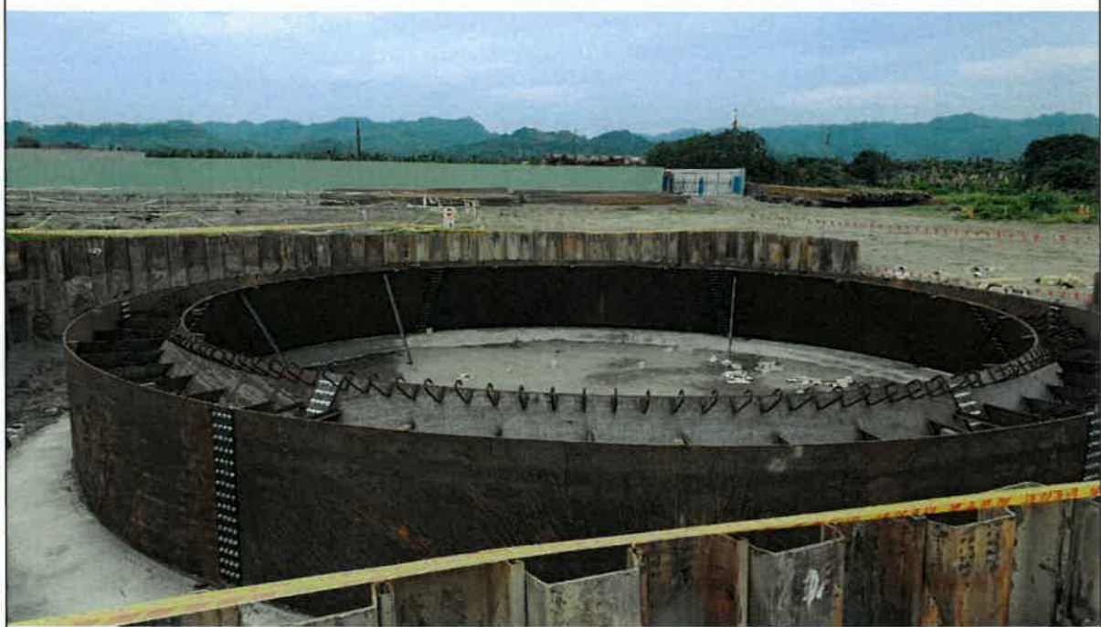
集水井#1 周邊施工現況-2
