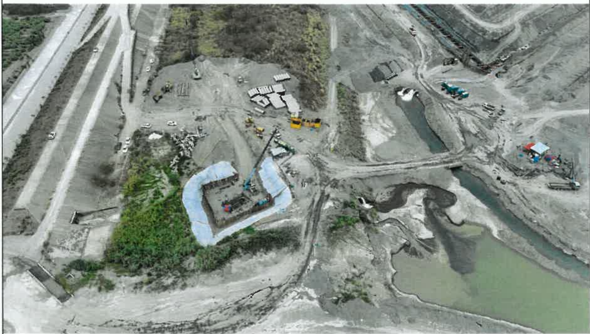
荖濃溪施工現場情況-2
