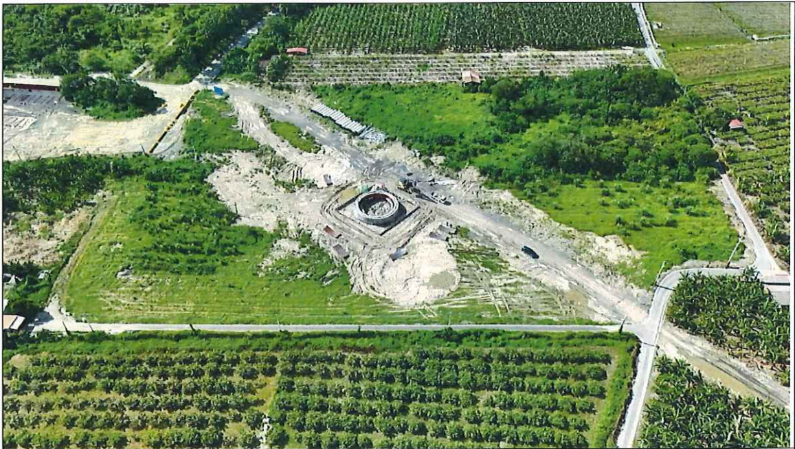
井2旗山溪施工現場情況
