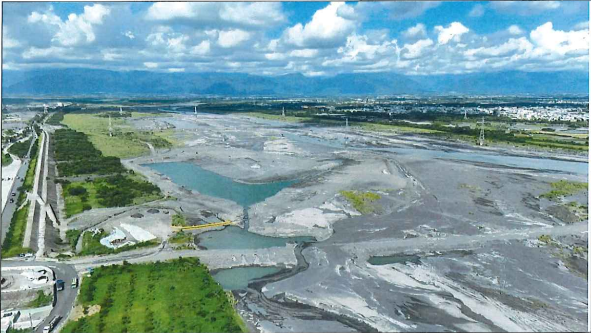
荖濃溪施工現場情況
