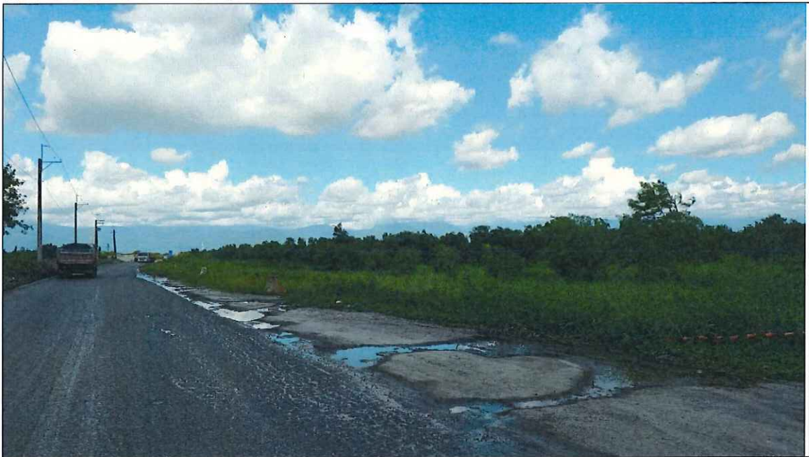
已於植生復育區周遭設置隔離帶
