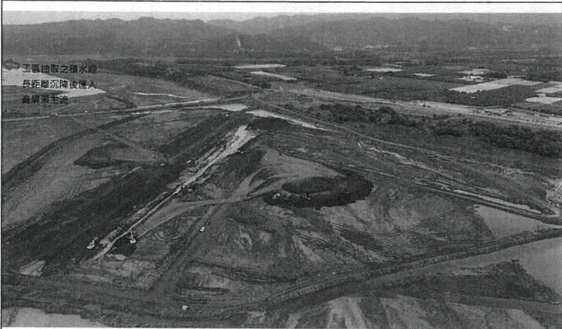
荖濃溪施工現場情況-2
