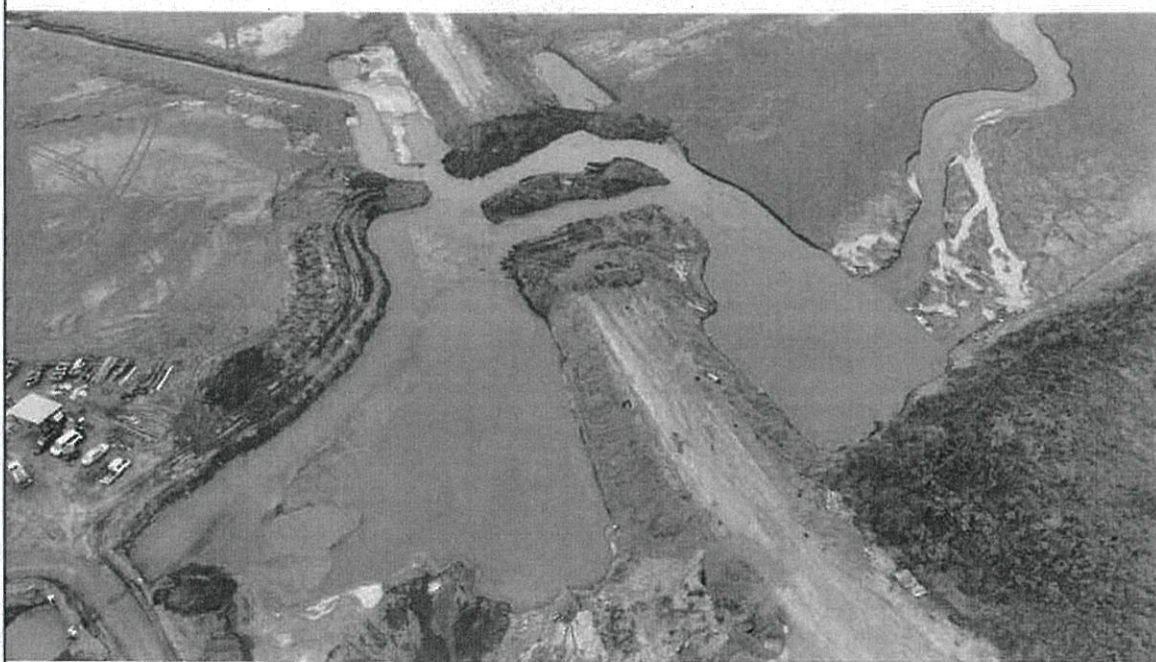
荖濃溪施工現場情況-2
