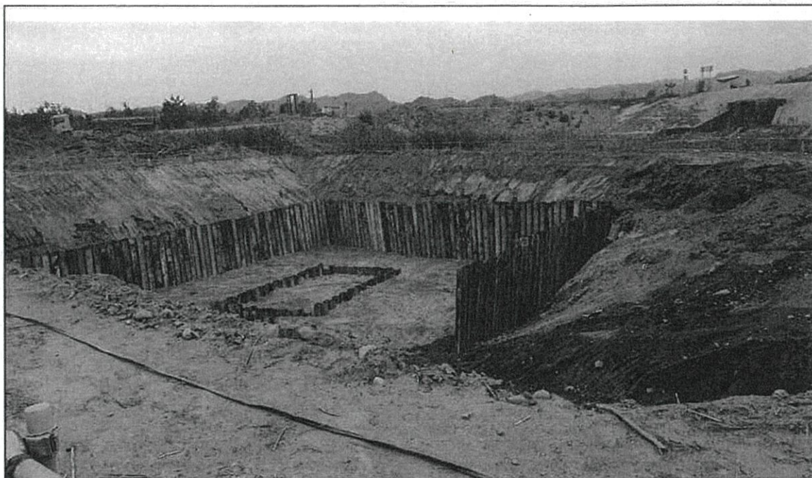
集水井#1 周邊施工現況-1
