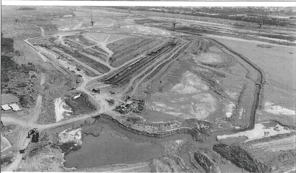
荖濃溪施工現場情況-1
