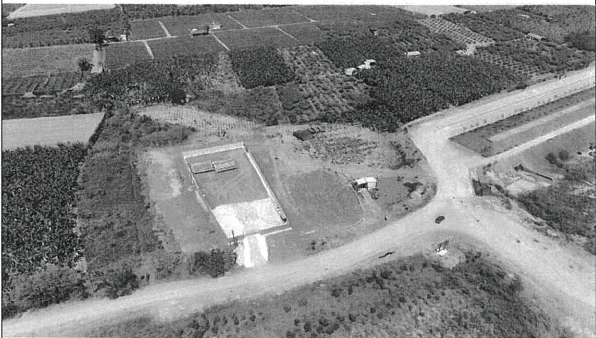
集水井#1 周邊施工現況-2
