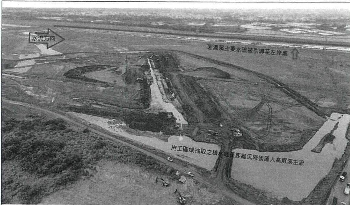
荖濃溪施工現場情況-1
