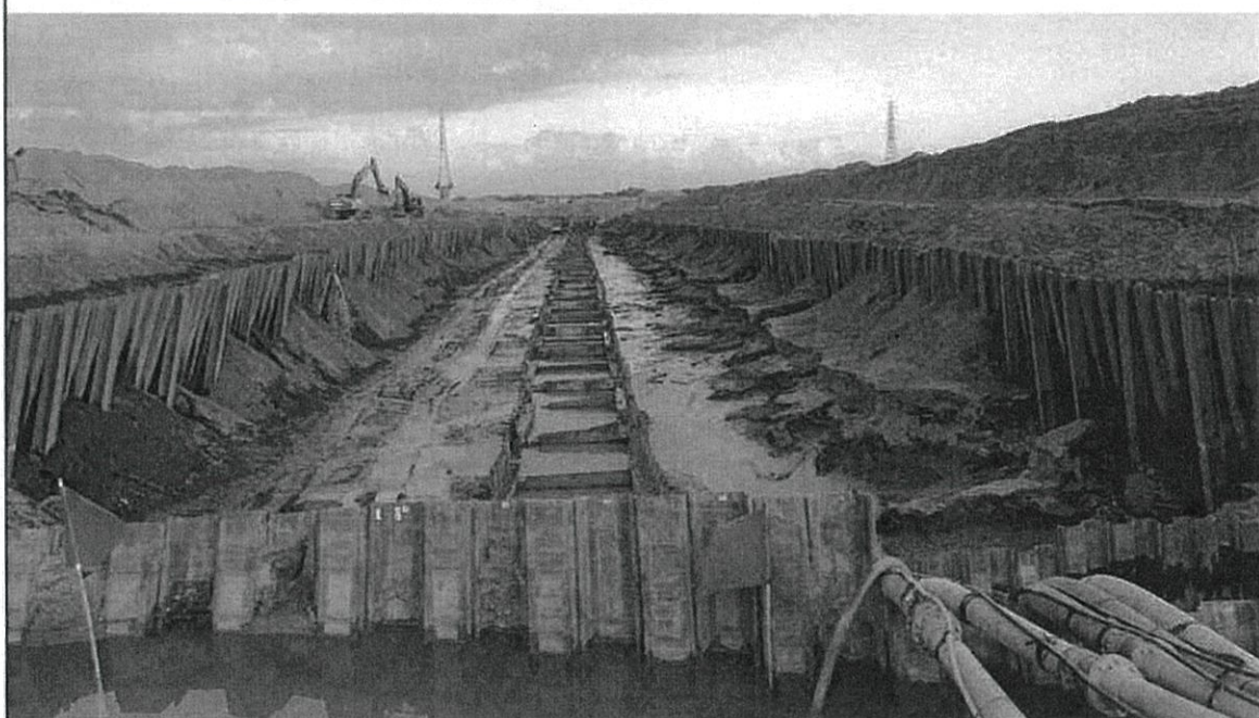
集水井#1 周邊施工現況-2
