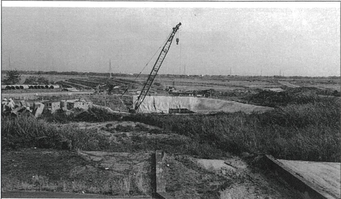
集水井#1 周邊施工現況-1
