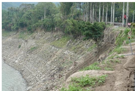
111.05.04 情人公園外側邊坡及前期搶修工程位置
