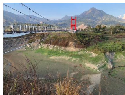
111.07.07 同心吊橋情人公園一側邊坡
