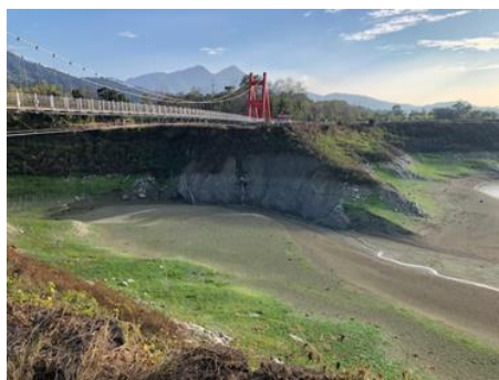
112.01.04 同心吊橋湖濱公園一側邊坡
