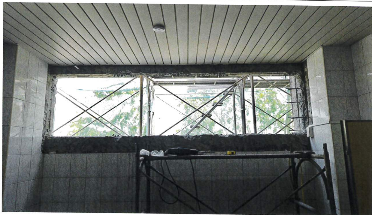
燕巢辦公園區B棟辦公室內外牆打除切割完整
