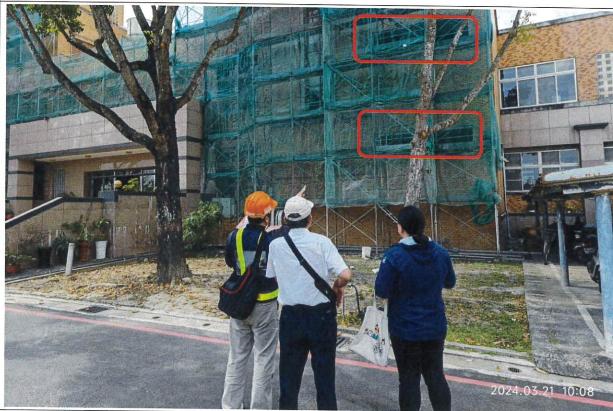
燕巢辦公園區B棟辦公室內外牆打除切割完整(如紅框處)
