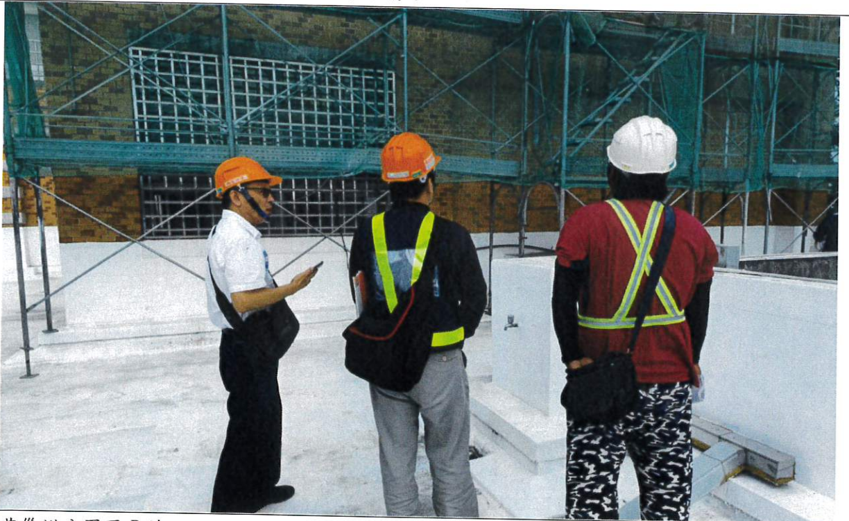
燕巢辦公園區 B 棟辦公室 3 樓樓梯間外牆
