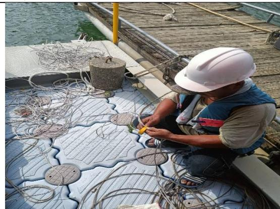
施作後(探頭吊放與率定測試)
