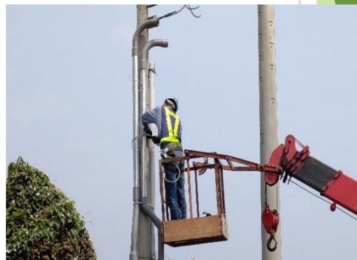
鍍鋅鋼管銜接及束緊固定完成
