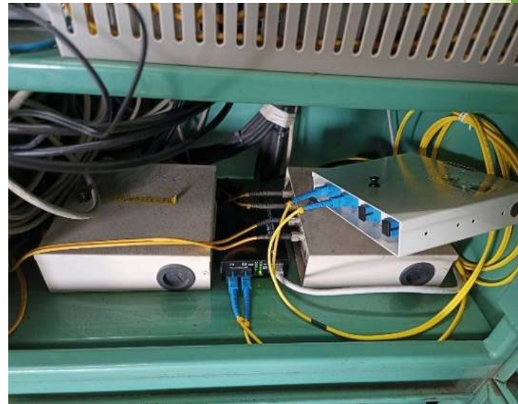
安裝光電轉換器及光纖
