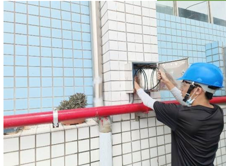
鋪設新光纖管線
