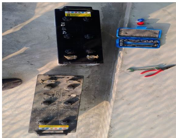
更換發電機組電池
