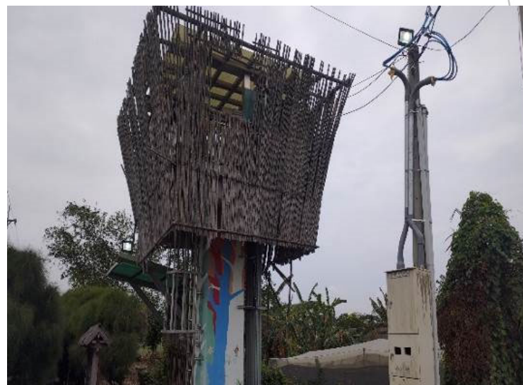
安裝連動投射燈
