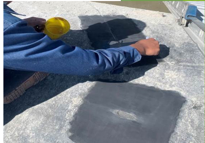
橡皮壩2號袋體表面 剝離修補過程
