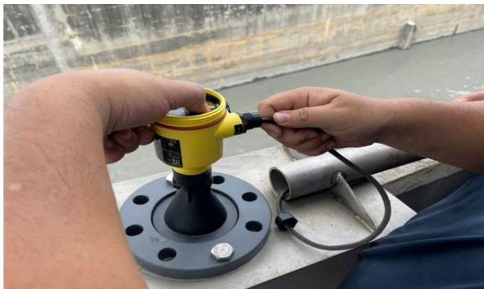
安裝新品水位計
