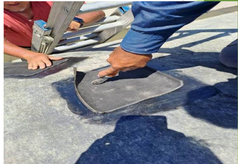
橡皮壩2號袋體表面 剝離貼合過程
