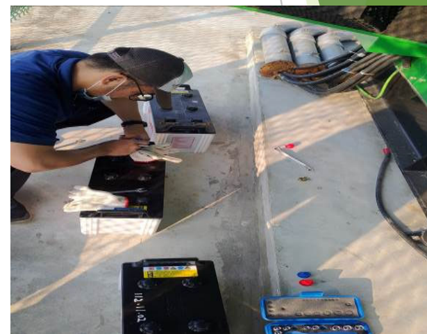
更換電池完成
