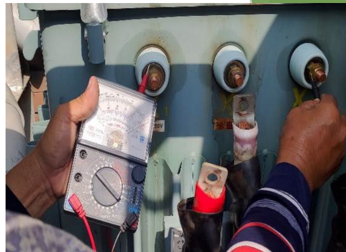
拆卸故障數位式控制線路
