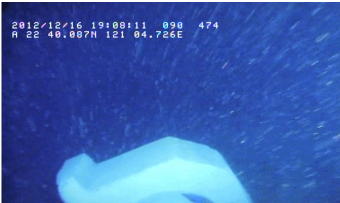
圖附件二-4 水下-475m 處發現有斷管
