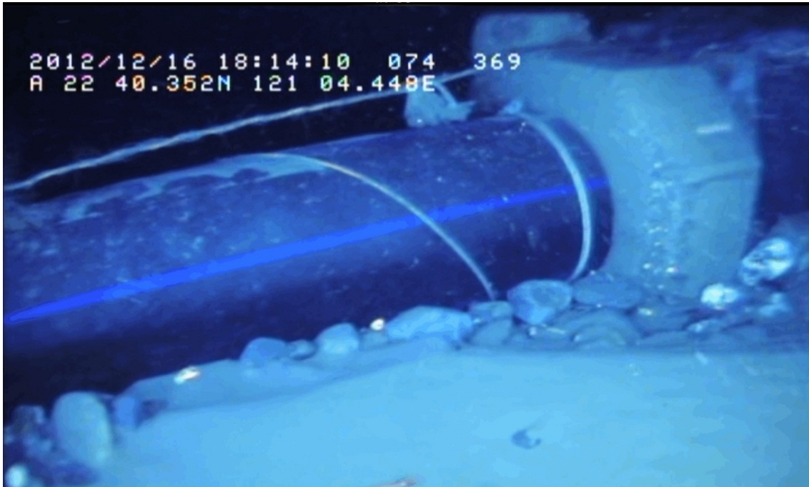
圖附件二-3 水深-369m 處的管線下緣受到沉積物部份填塞
