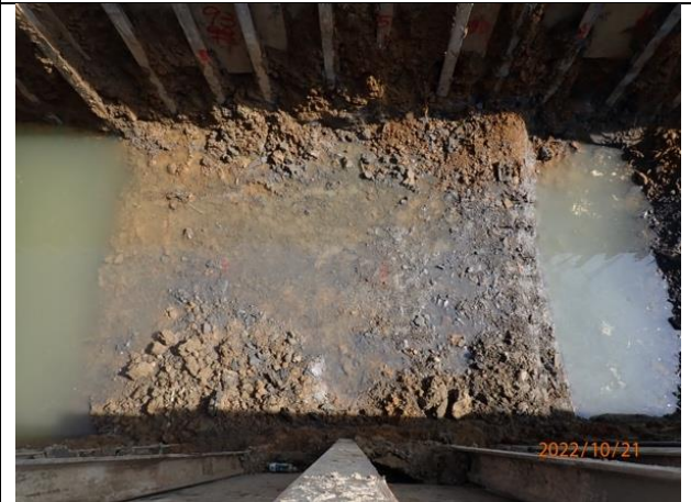
A3 標明挖沙田段開挖坑底
