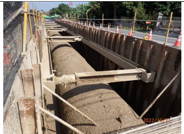
A3 標明挖北寮段工區現況
