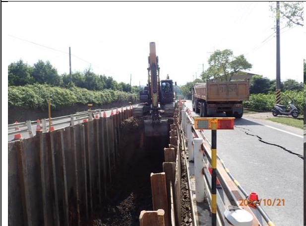
A3 標明挖沙田段開挖狀況
