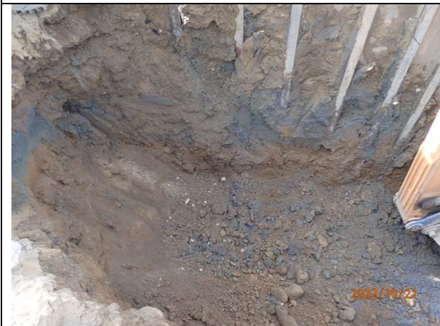
A3 標明挖沙田段開挖地層
