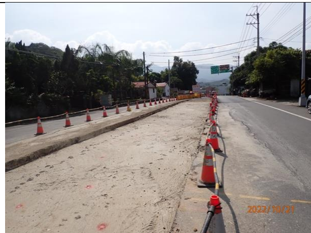
A3 標明挖北寮段工區現況
