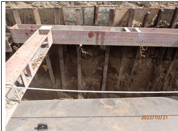
A2 標曾文一號水管橋 A2 橋台至 W18 工作井明挖段工區現況
