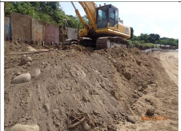
A2 標曾文一號水管橋 A2 橋台至 W18 工作井明挖段工區土層
