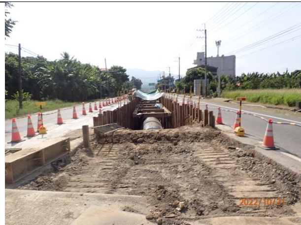
A3 標明挖北寮段工區現況
