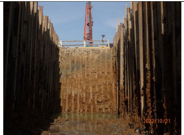
A3 標明挖沙田段開挖斷面
